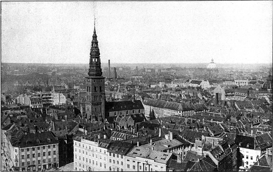
Udsigt fra Christiansborg mod Nikolai Kirkebygning.
