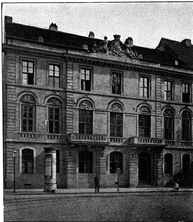
Opstillet i Fortovskanten gør en Plakatøjle mindst Fortræd og ses alligevel af alle forbigående. (Billedet viser en berlinsk Plakatøjle opstillet paa Molkenmarkt).
