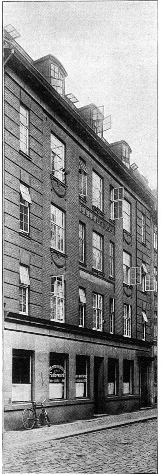
1906. Murersvendeforeningens Stiftelse, Murergade 12 (Architekt ALFR. THOMSEN).
