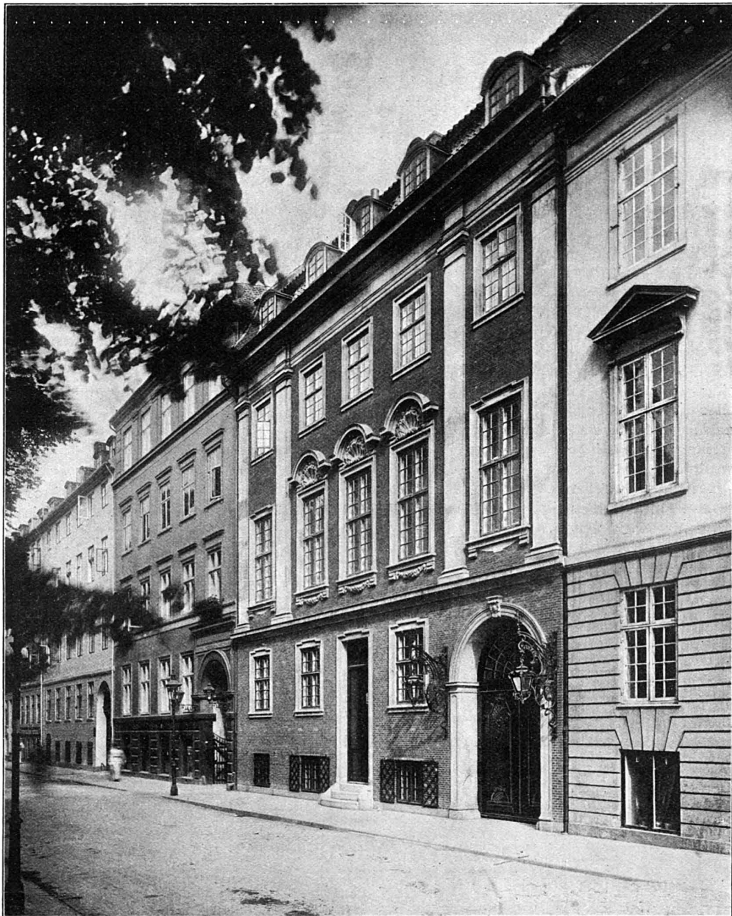
Antikvar C. J. Petersens Ejendom, Kronprinsessegade 4 (Architekt Gotfr. Tvede).
