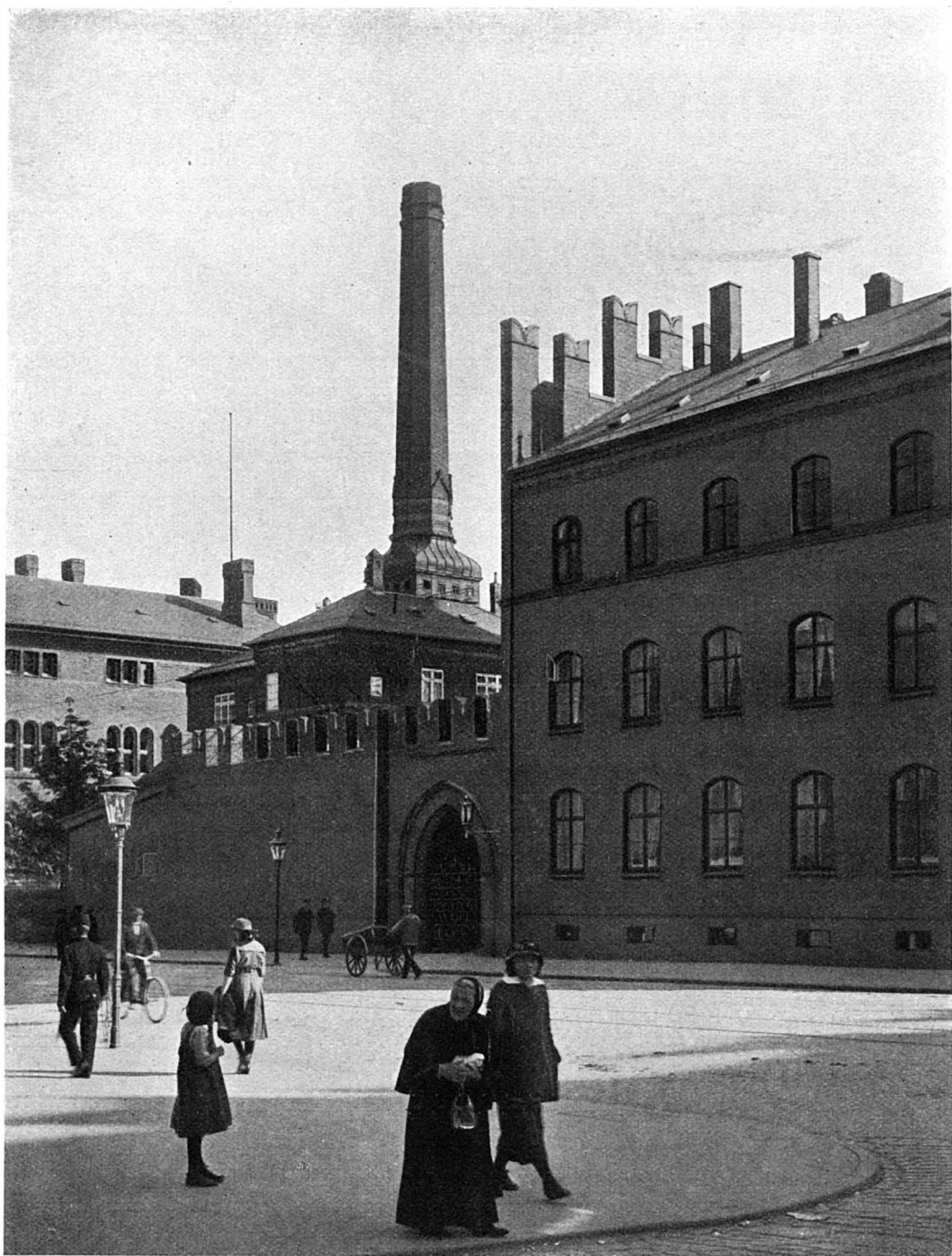
Skorsten paa Raadhusets Kedelbygning (Prof. M. Nyrop).
