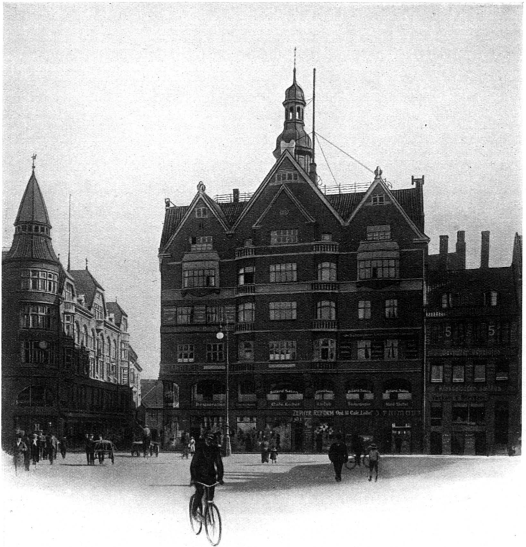
Skorstensforlængelse paa en Ejendom Hj. af Kulturvet og Købmagergade (Arch. Chr. Hansen).
