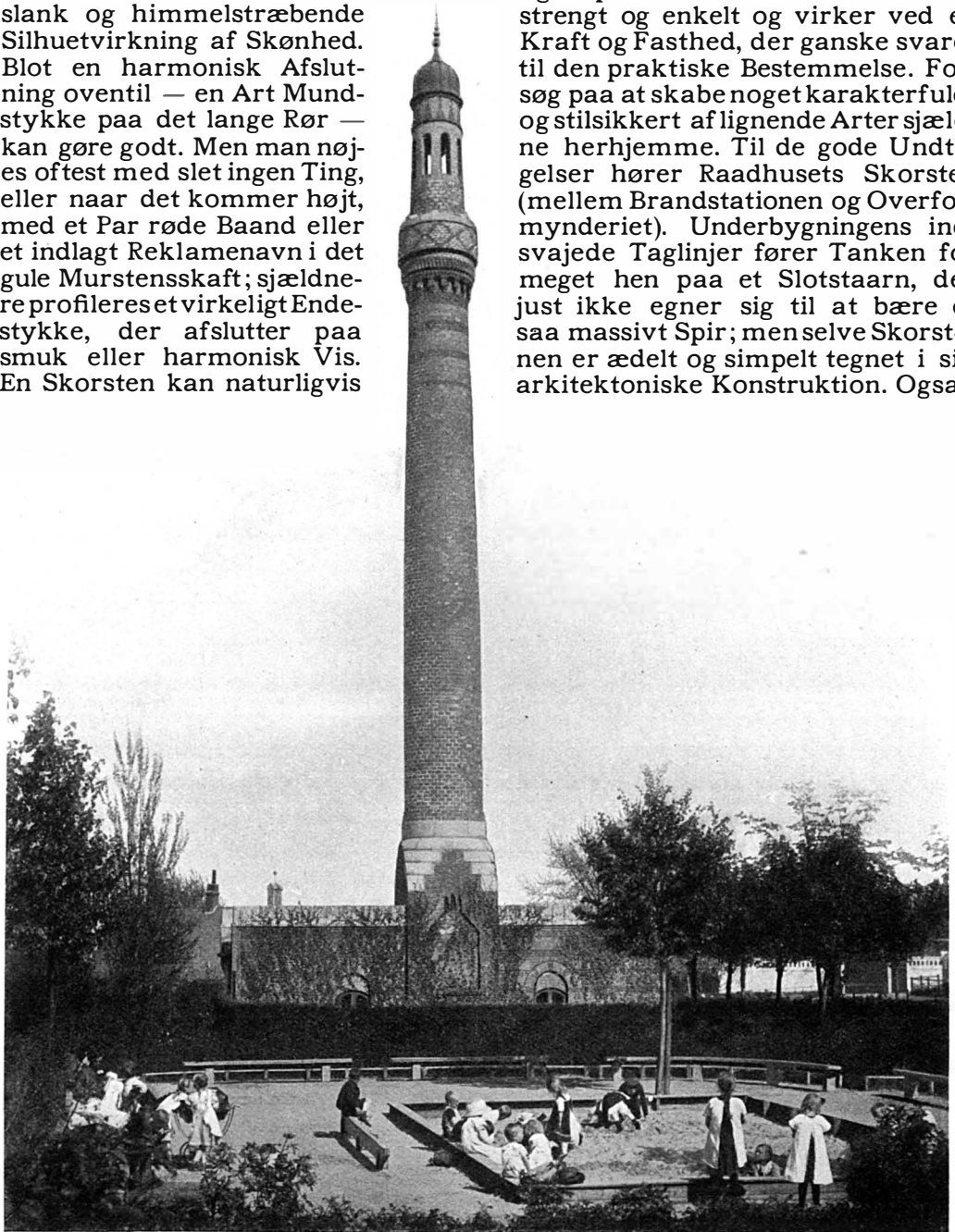
Aftræksskorsten fra Skyllebassinet ved Kloakværket ved Svanemølleviadukten (H. Wright).
