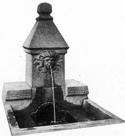
Brønden ved Klampenborgbanestationen. (M. Nyrop og A. Bundgaard).
