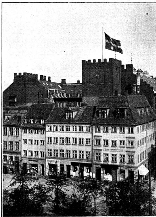
K. F. U. M.'s Bygning, set fra Norrevoldgade.
