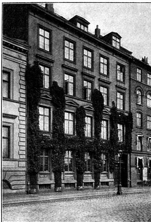
Hus i Havnegade med Vildvin.
