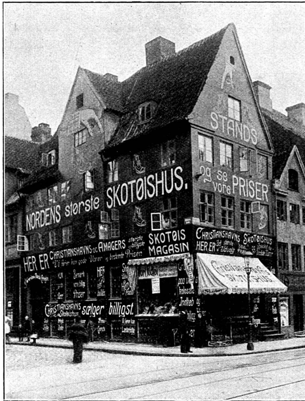
Forretningsejendom i Torvegade.
