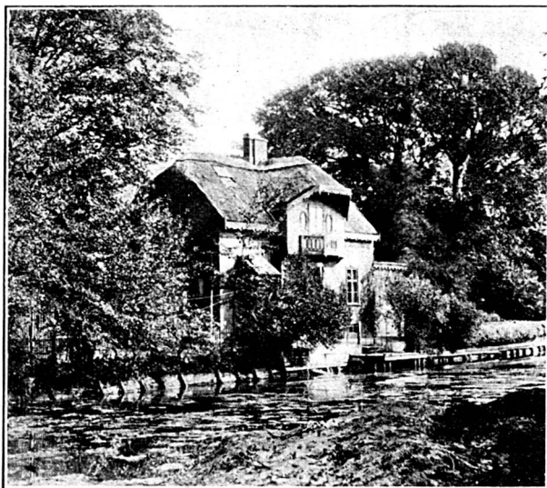
Den gamle Villa »Aggersborg« paa Østerbro.
