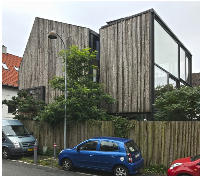
Facade med rafter fra top til bund
