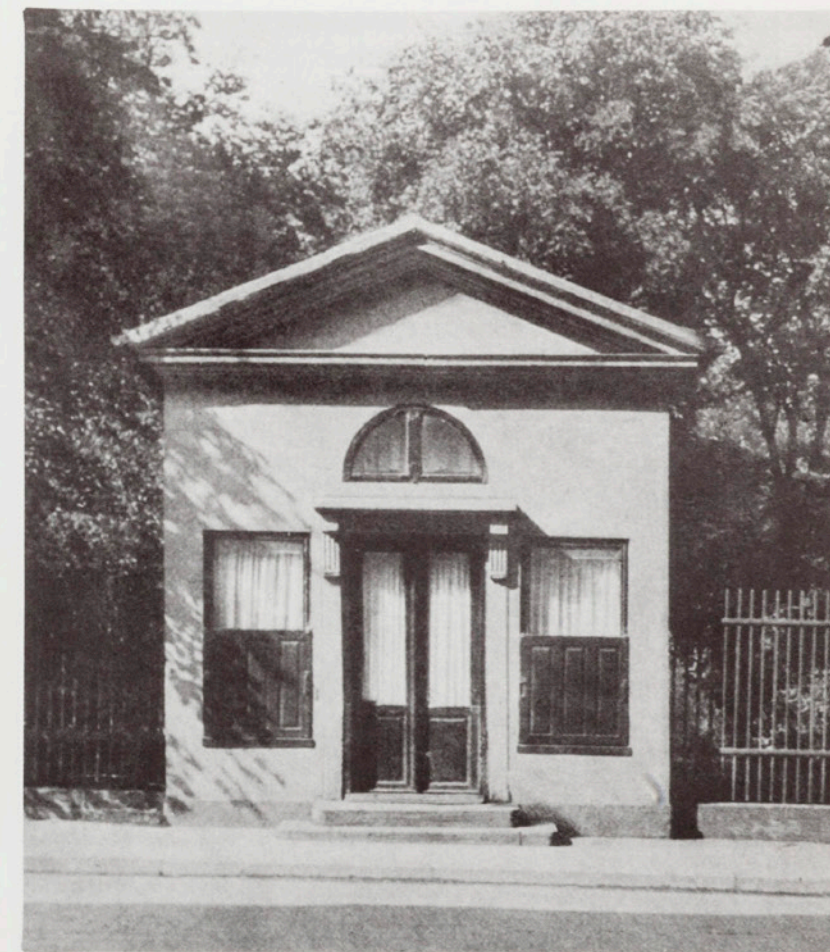
En af Peter Meyns 16 karakterfulde pavilloner mod Gothersgade og Kronprinsessegade.
