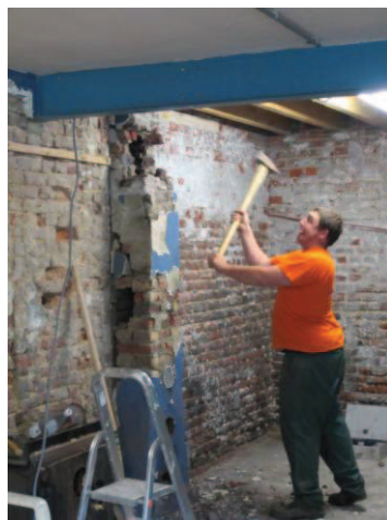
Destruction de la cheminée, devenue désuète
