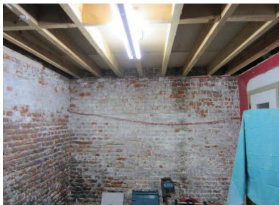
Destruction du plafonnage et du faux plafond
