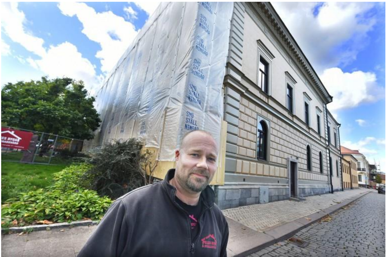
Joakim Nilsson framför den del av fasaden av residenset som är färdig. Tekniken som används, ES METODEN, är i princip unik.
