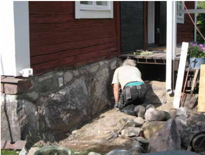
Husgrunden under renovering
