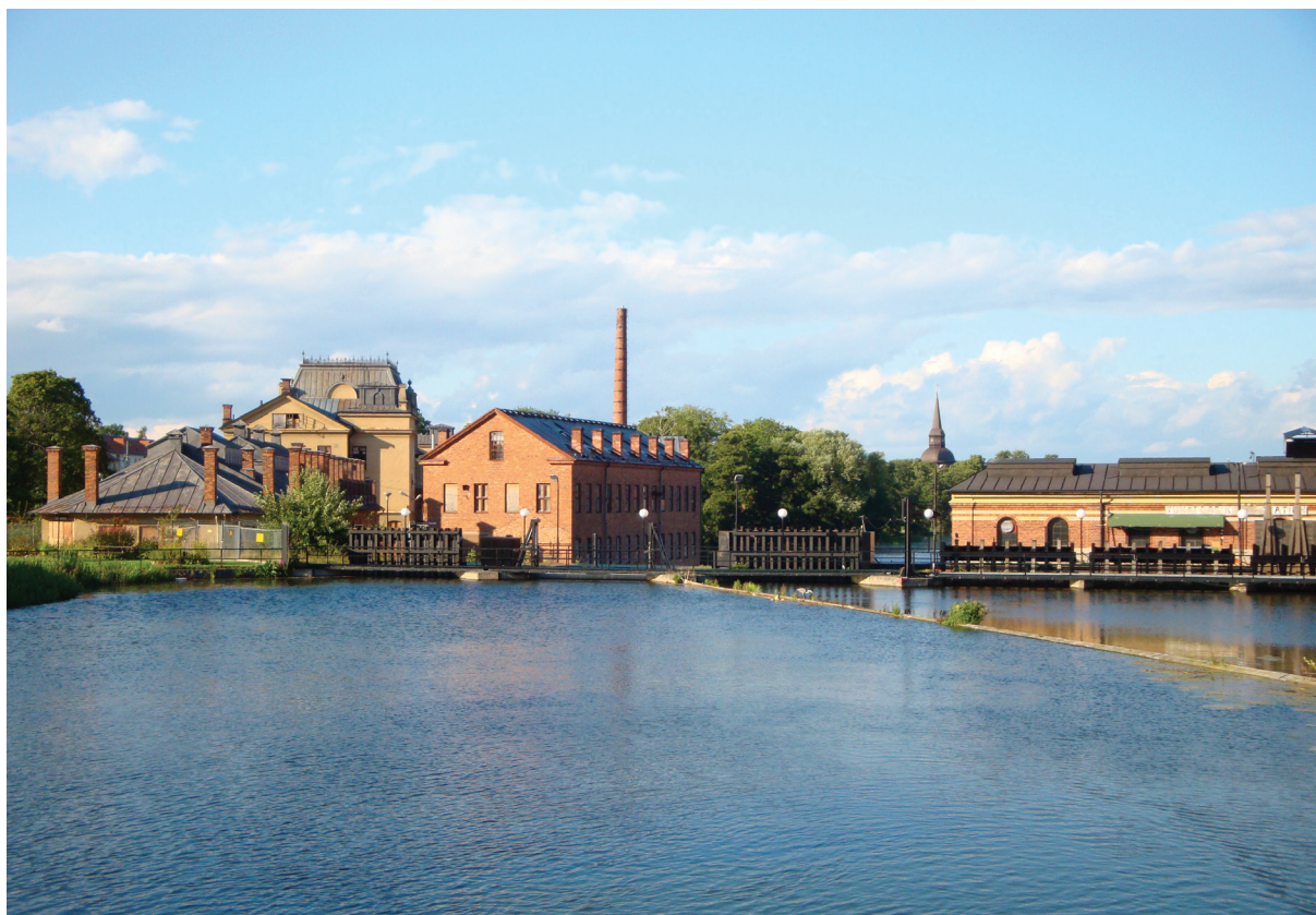
Tunafors fabriker och kraftverk i Eskilstuna. Foto: Richard Attered
