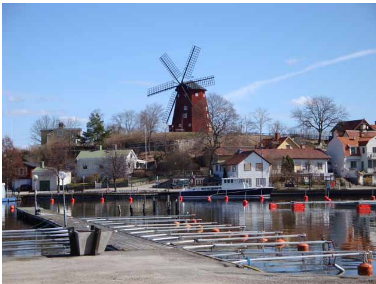
Kvarnen i Strängnäs. Byggd 1855. Foto: Richard Attered
