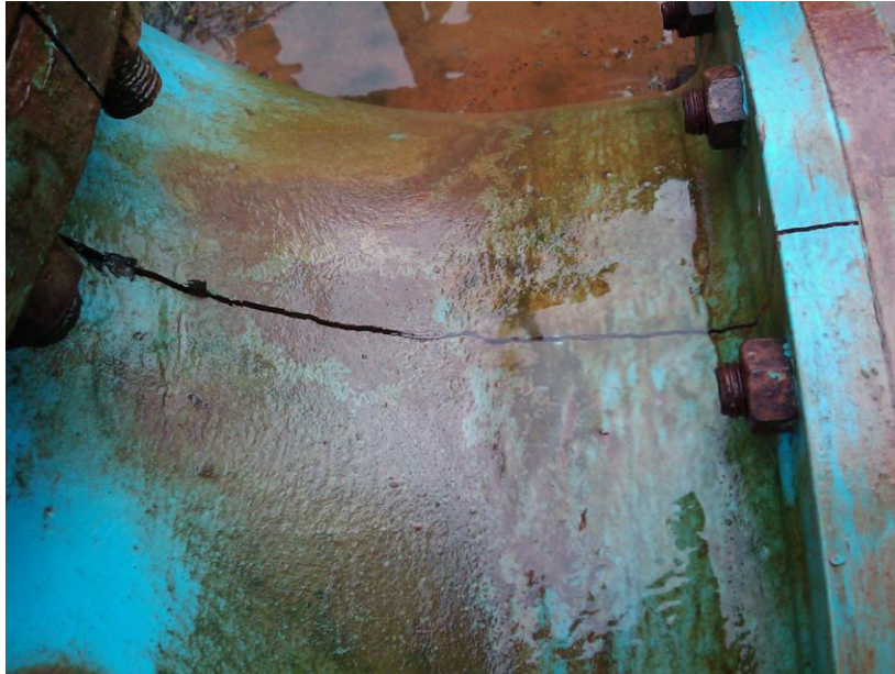
Dégâts sur fonte de la pompe de refoulement.
