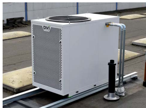
Figur 31 - Ude-delen af en luft-vand varmepumpe. Enheden kan etableres i kaskade for at opnå en større effekt. Kilde: https://dansk-energi-center.dk/varmepumper/store-varmepumper
