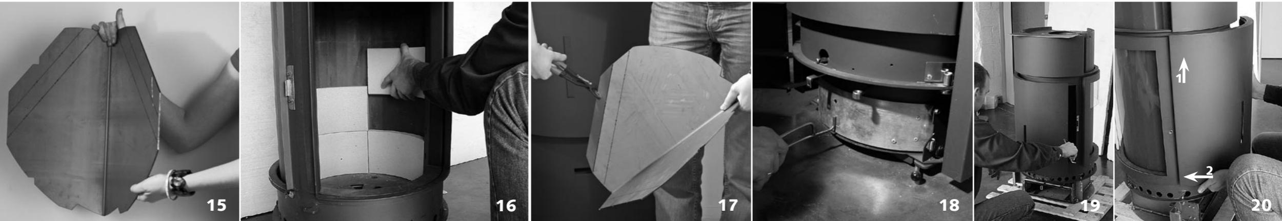
De stalen stang, die de horizontale **vermiculiete** vuurvaste stenen ondersteunt, verwijderen. Door lichtjes op de stang te duwen kan ze uit de groeven worden verwijderd. Eerst de horizontale **vermiculiete** vuurvaste stenen verwijderen (14C). Vervolgens de rookleidingsplaat verticaal verwijderen (14D en 15).
