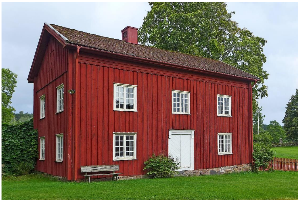
Östra flygelbyggnaden i augusti 2024. Vy från nordväst. Foto: Ulf Larsson.
