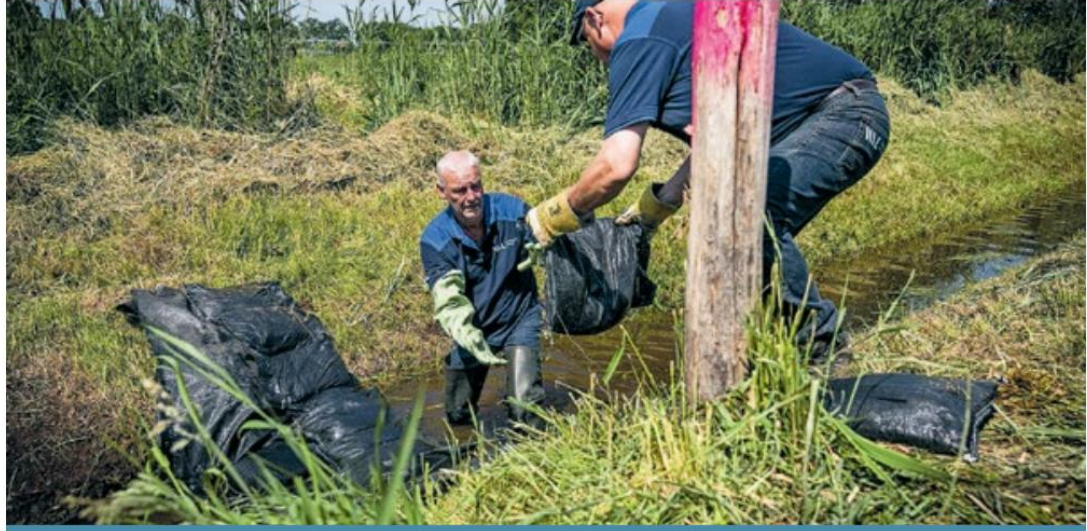
Met zandzakken wordt een dam gevormd in een sloot, om water vast te houden dat kan worden gebruikt bij droogte.
