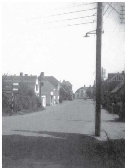
Gadelampe på træmast
