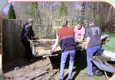
En vägg bärs bort av Oskar Roger, Daniel och Kalle.
