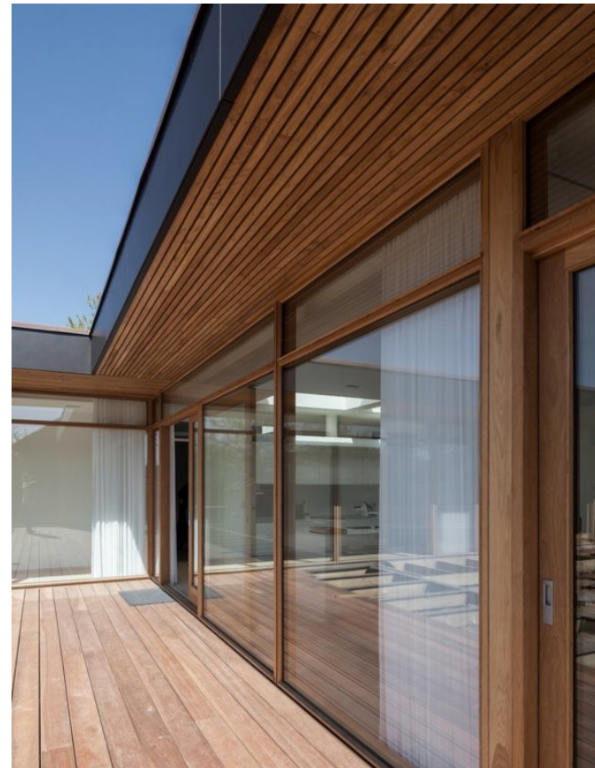
Eksempel på inddækning i træ under udhænget.
