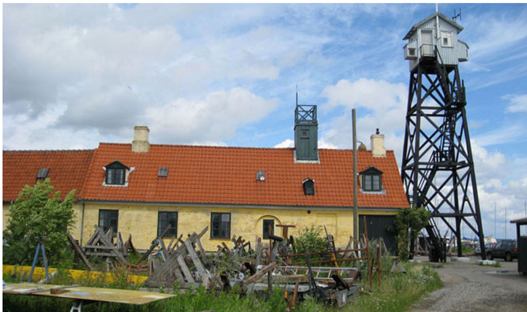
Lodsstationens sydfacade og det 15,8 meter høje lodstårn, 2008.
