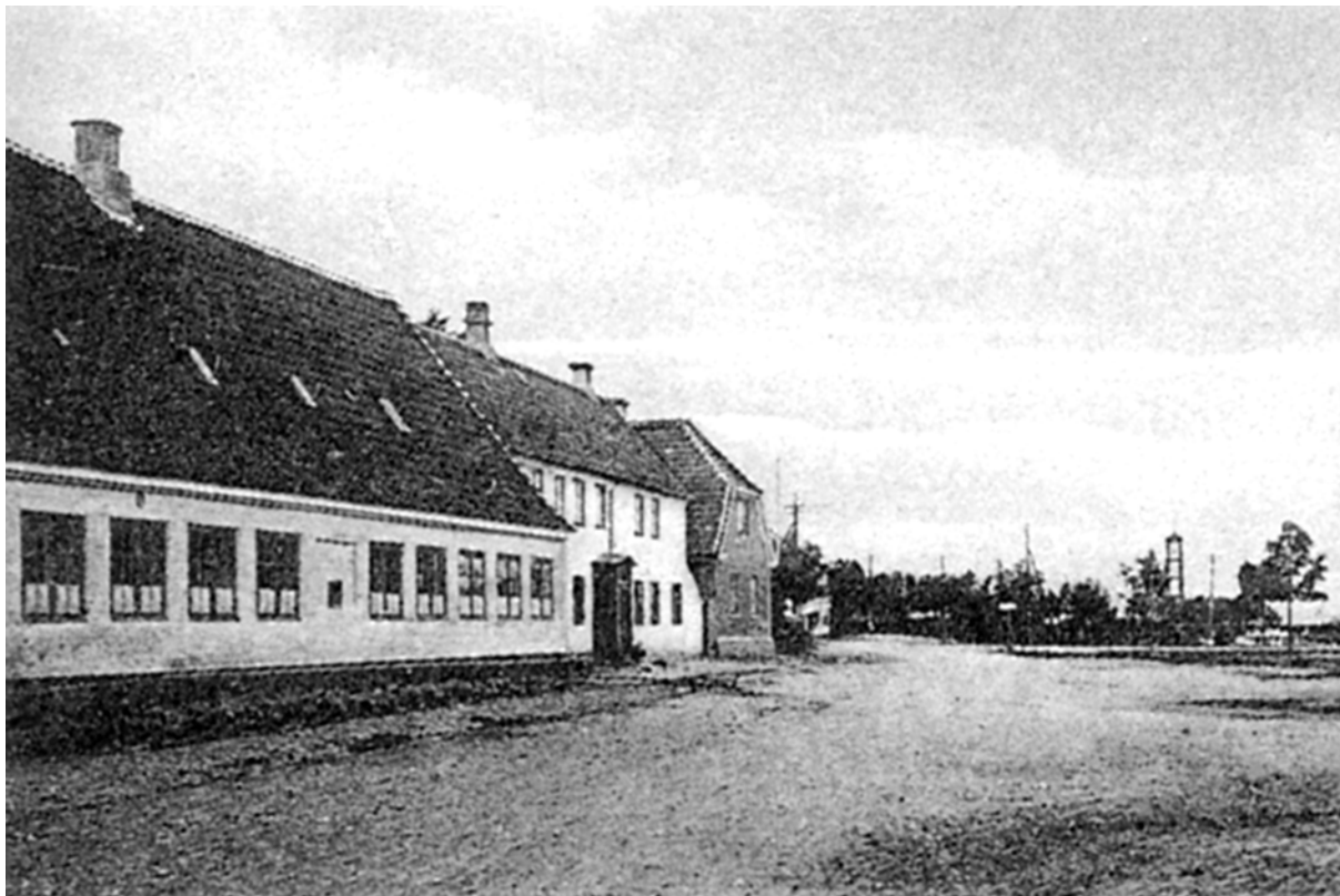
Den nu nedrevne drengeskole på Vestgrønningen. Opført 1827, nedrevet 1956. Efter postkort fra omkring 1900.
