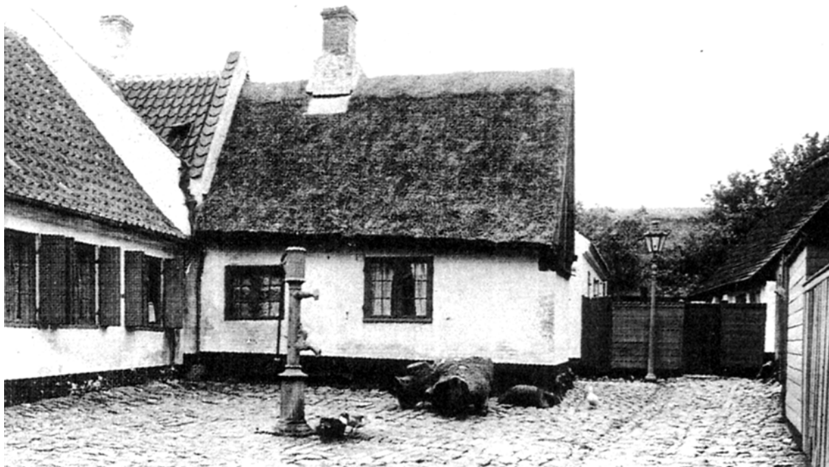
Rendestenen i Zytensgade løber fra Strandstræde ned til stranden. Byposten og huset bag ved eksisterer ikke mere. Optaget kort efter 1900.
