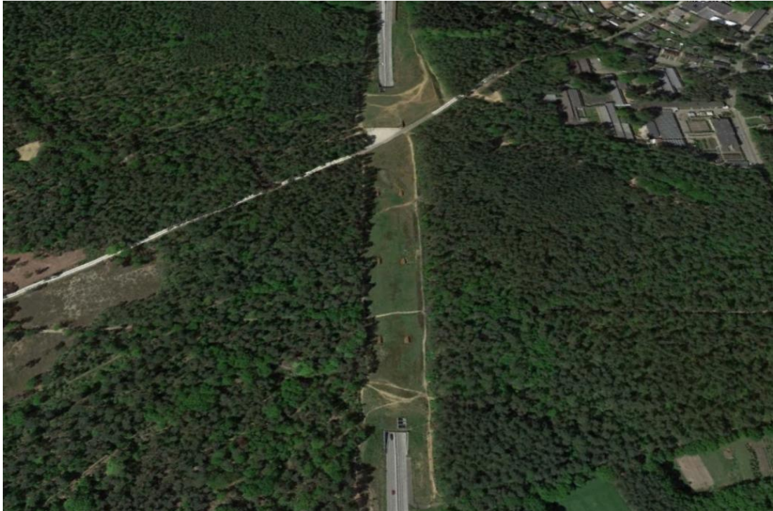
Figuur 10-133 De Hoge Moutunnel in Kasterlee verbindt twee bosgebieden en doet dienst als 'zachte' verbinding.
