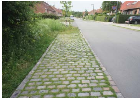
De brostenbelagte p-pladser er fornyet med permeabel belægning og græsfluge, og afvandes mod grøfttekanten.
