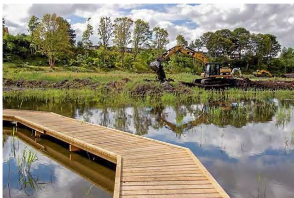
Figur 30: Denne bro forbinder to parallelle stier og fører i sig selv ingen steder hen. Man går altså kun ud på den for at komme tæt på vandet. Broen ligger desuden midt inde i et større naturområde, hvor mindre børn ikke færdes alene. Der er ikke særlige sikkerhedstiltag som lavt vand eller stiger omkring broen.
