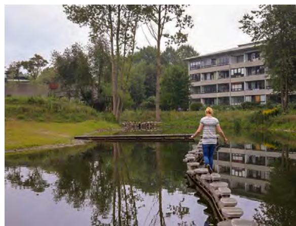
Figur 35: En udfordrende sti på en skillevæg i et regnvandsbassin sender et klart signal om, at her risikerer man at falde i. Sikkerheden er øget ved at reducere vanddybden langs væggen og montere rælinger langs bunden og toppen af væggen (ses på billedet). Broen for enden af væggen sorterer derimod ikke i, hvem der går ud på den. Det kunne man gøre ved at fjerne brodækket på den første meter af broen, så man skulle springe ud på den.
