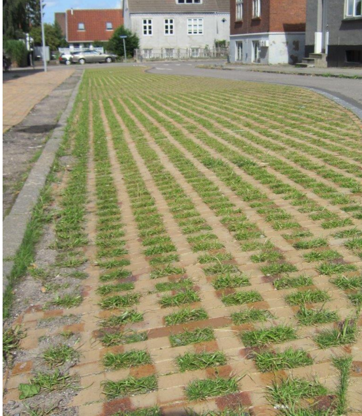
Test af grøn klinkebelægning
