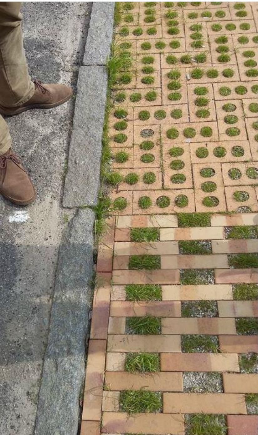
Test af grøn klinkebelægning
