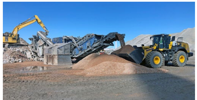
Der er gang i løjerne på Prøvestenen, når MIS Recyclings knuserhold går i gang. Komatsu-læsseren er nyeste maskine på stedet, hvor den kommer til at køre et stykke tid fremover.
