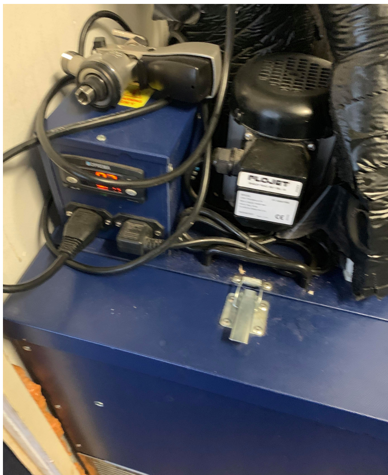
Figur 1.5. Dette er ølanlægget er det op mellem 3.0 grader?
