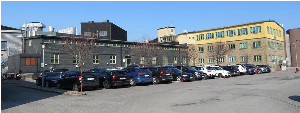
Televerkets verkstad (till höger i bild) och förråd (till vänster i bild) är sammanbyggda och bildar ett L. Bilden är tagen från innergården. Foto LKU 2022.
