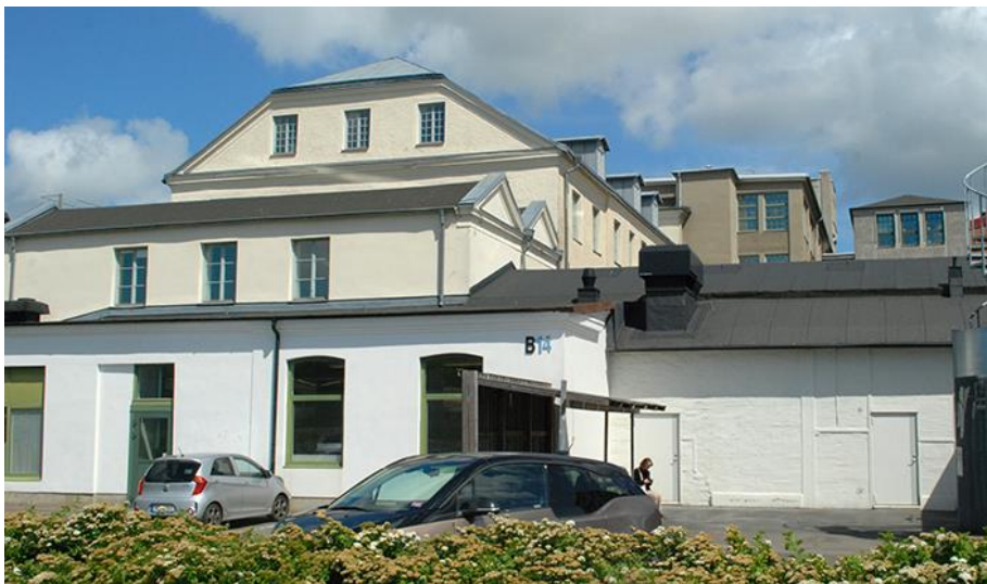
I fonden syns B1 och framför den de två smala sadeltakfallen och den lägre delen med pulpettak mot parkeringen i väster (B14). (Se även bilden på föregående sida.) Foto LKU 2021.
