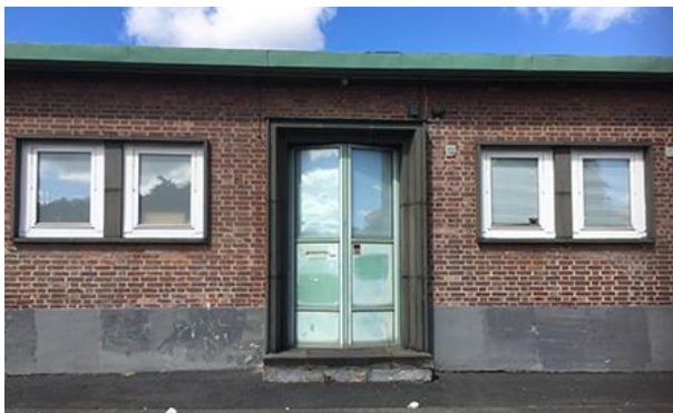
Kontorsbyggnadens gavel mot öster. Foto LKU 2021.
