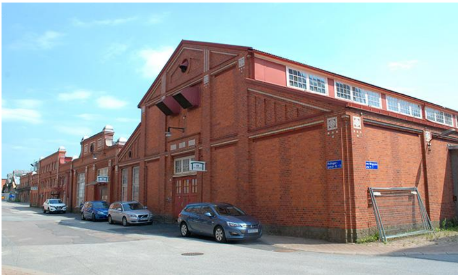
M-fabriken med den äldsta västra verkstadens norra gavel i förgrunden. Foto LKU 2021. Ritningen nedan är signerad Ernst Krüger 1913. Ritningen från Stadsbyggnadskontoret. Ritningen är beskuren.
