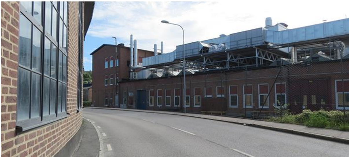
D-fabriken mot öster har tydlig industrikaraktär. Taklanterninerna finns kvar men är delvis dolda bakom stora fläktanordningar. Foto ID 2021. Nedan ritning från Stadsbyggnadskontoret. Ritningen är beskuren.
