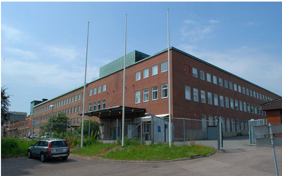
S-fabrikens södra och östra fasader. Merparten av fasaderna mot söder är avstängda med stängsel och därmed inte möjliga att inventera. Längst till vänster i bilden anas byggnadsdelarna från 1937 och 1941 som syns på ritningen längst ner. Foto LKU 2021.
