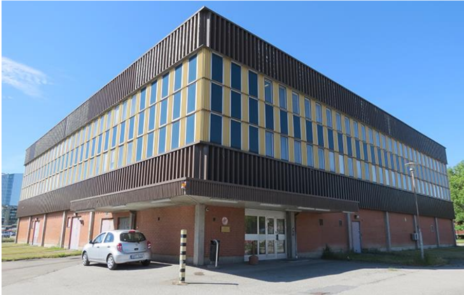
Byggnaden som SKF lät uppföra i mitten av 1970-talet som datorcentral är lådformad med platt tak och har fasader av tegel och olika typer av plåt. I byggnadens sydöstra hörn sitter en ursprunglig entré. Foto ID 2021.
