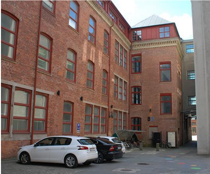
Bilden visar delar av norra fasaden med trapphuset mot nordväst. Till höger i bild anas B3 (Rensbyggnad/Spinneri). Foto LKU 2021.
