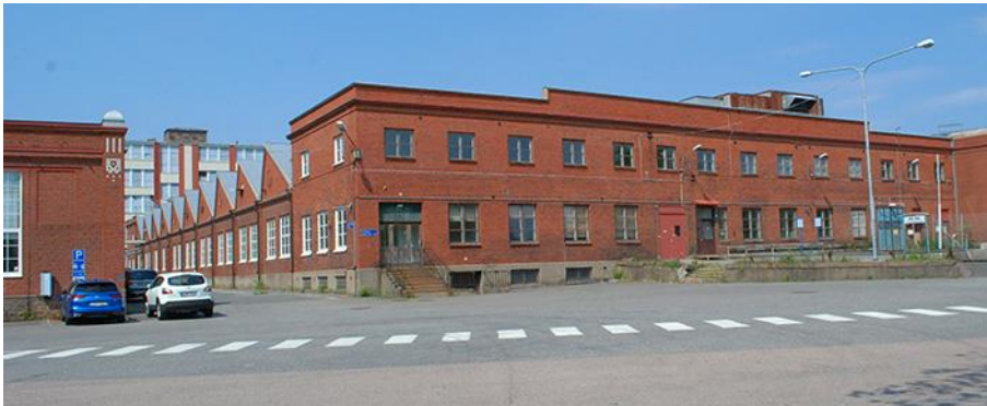
R-fabrikens södra och västra fasader. Byggnaden är relativt välbevarad med vad som ser ut som ursprungliga fönsterbågar i söder. Foto LKU 2021.
