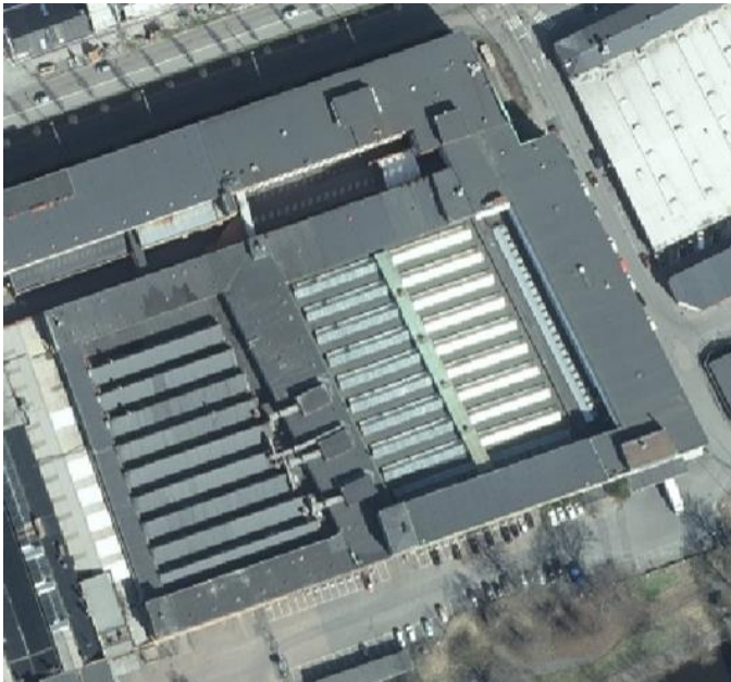
S-fabrikens taklandskap som inte syns från marken kan beskådas på flygfotografier från Eniro eller, som här, Lantmäteriet. Fotot berättar en hel del om S-fabrikens olika delar och dess konstruktion: sågtandstaket från 1937 och 1941 samt taklanterninerna från 1947 finns ännu kvar. ©Lantmäteriet.
