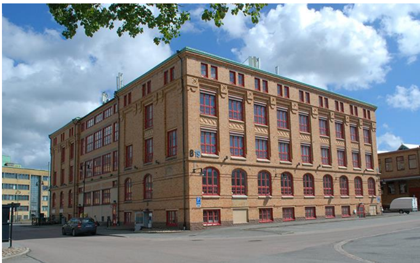
B19, bilden visar norra och västra fasaderna. Notera norra fasadens mittparti och jämför med ritningen nedan. Foto LKU 2021.
