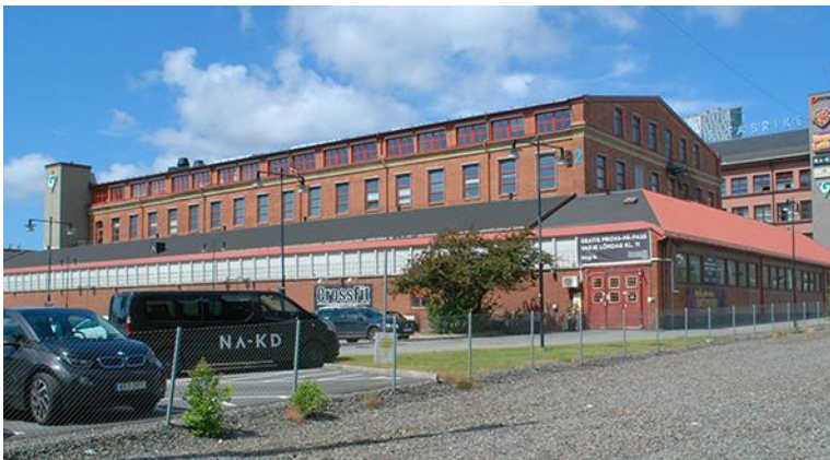
Fasaderna mot söder och öster med tillbyggnaden i ett plan från 1932. Foto LKU 2021.
