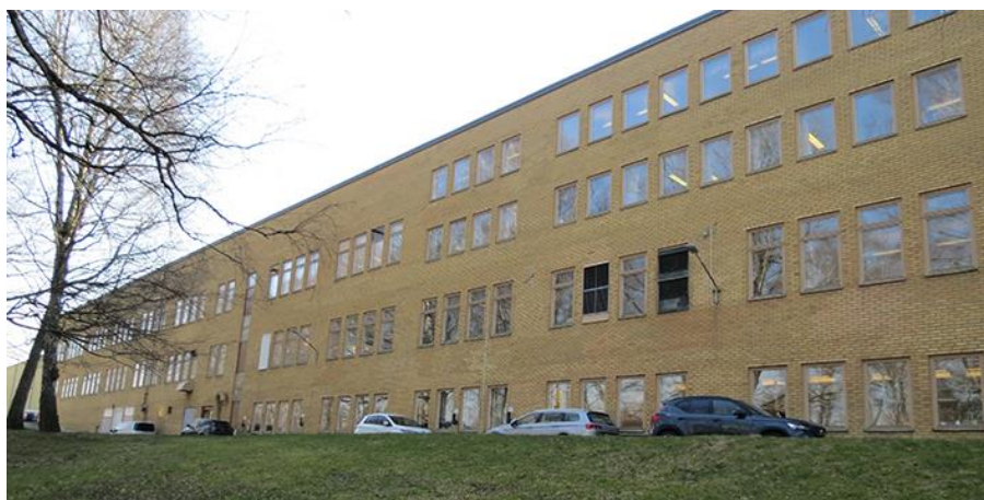
Byggnadens norra fasad består av fyra våningsplan. Här finns kontorsdelen. Foto ID 2022.
