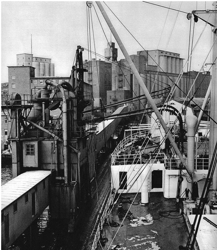
Bilden visar kvarnen Tre Lejon som senare blev Juvelkvarnen. För att kunna lossa spannmål från båtarna försågs kvarnens brygga med en lossnings-elevator. När spannmålen hade sugits upp ur båten forslades den vidare till silon med ett inkapslat transportband. Foto KF Industrier, 1960.
