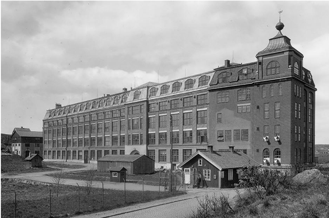
"Nordkulan", Volvos första bilfabrik. Här monterades bilar under en dryg tioårsperiod, fram till omkring 1938. Tillverkningen försiggick på olika våningsplan och bilarna fick hissas mellan dessa med hjälp av rep. Bild ur Volvos historiska arkiv.
