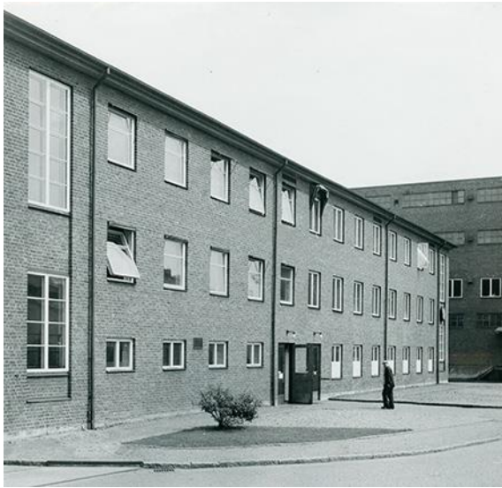
Kontors- och personalbyggnaden Sociala huset förr och nu. Bilderna visar byggnadens södra fasad. Foto Engelsbergs arkiv Nordstjernen och Lena Knutson Udd 2016.
