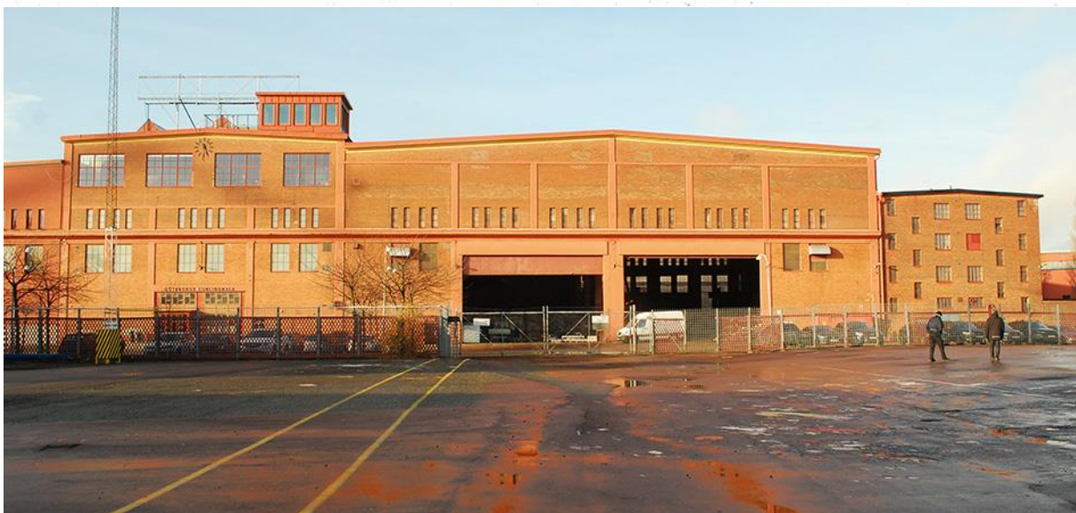
Plåtverkstaden mot öster och älven med kvarvarande oputsade fasader. Längst till höger i bild syns personalbyggnaden med sina säregna fönsterplaceringar. Ritning Göteborgs stadsbyggnadskontors arkiv och foto Lena Knutson Udd 2016.
