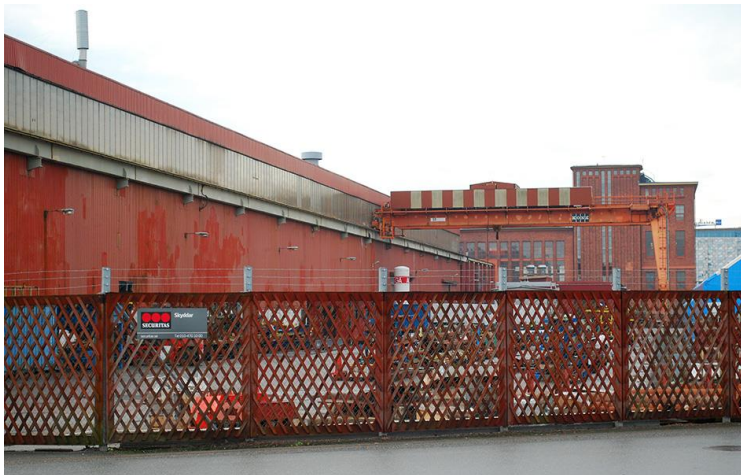
Pannverkstaden med utomhustraversen och bakom denna skymtar gamla maskinverkstaden. Foto Lena Knutson Udd 2016.
