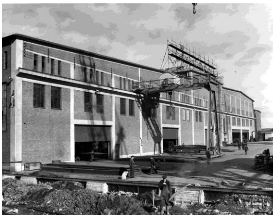
Plåtverkstaden uppförs. Foto Göteborgs Stadsmuseums varvshistoriska bildarkiv.
