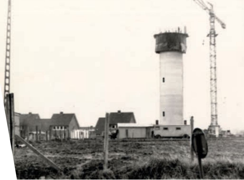
bouw watertoren Poperinge (Het Wekelijks Nieuws, 2-02-1973, p.7)
