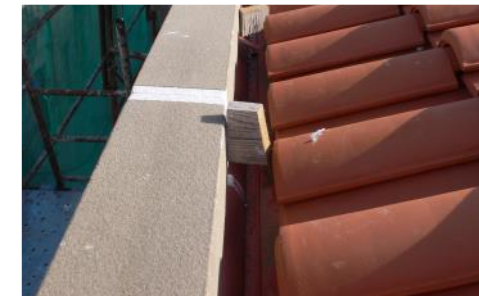
Fase di montaggio dei cornicioni copri gronda
