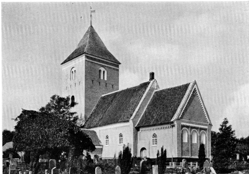
Fig. 1. Vaabensted. Ydre, set fra sydøst.
