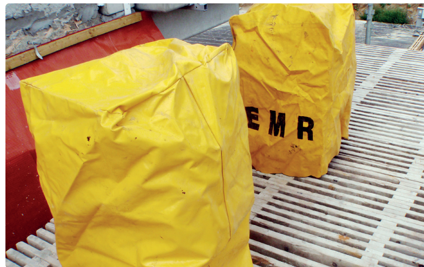
Plasthætter er bedst egnede til at beskytte udpakkede stenhoveder.
