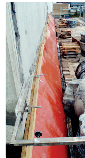
Afdækningen skal være tætsluttende ind mod en allerede opført bagmur, således at regnvand ikke ledes ned i isoleringen.
