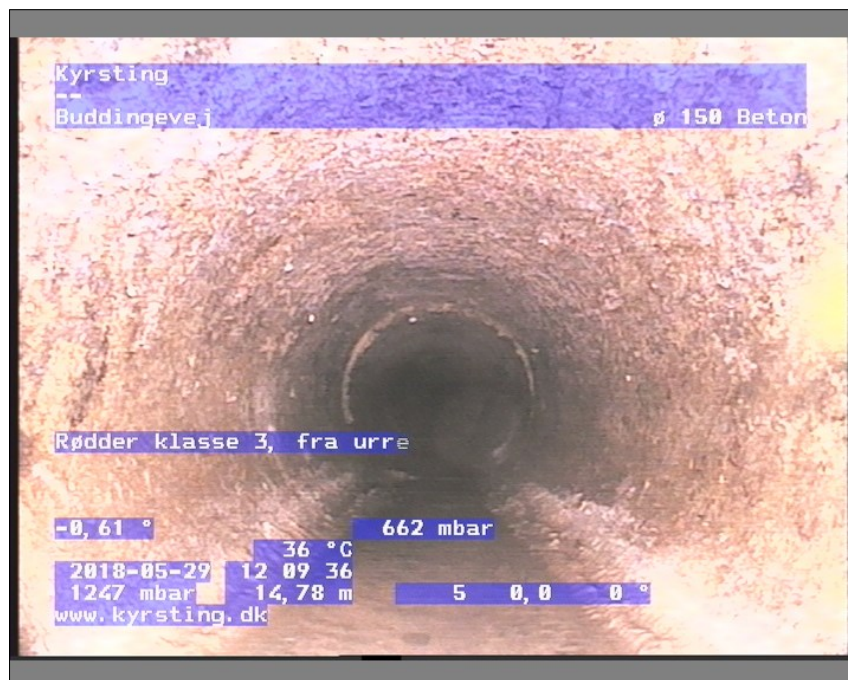
Foto: br 9-br1012094714-29-05-18_A.JPG, Medie #:: De Engelske _0, 00:05:25 14,78m, Rødder klasse 3, fra urref 07 til urref 04, Fine rødder, Stop
