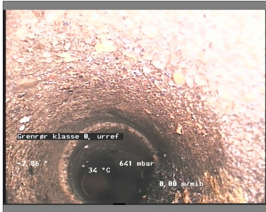
Foto: 15-211330487-29-05-18_A.JPG, Medie #.: De Engelske _0, 00:01:46 5,22m, Grenrør klasse 0, urref 3
