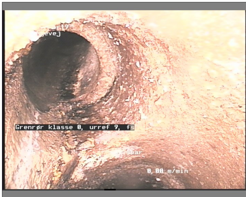
Foto: br 18-br1912241910-29-05-18_A.JPG, Medie #:: De Engelske _0, 00:03:38 7,47m, Grenrør klasse 0, urref 9 / fs 3 i gren
