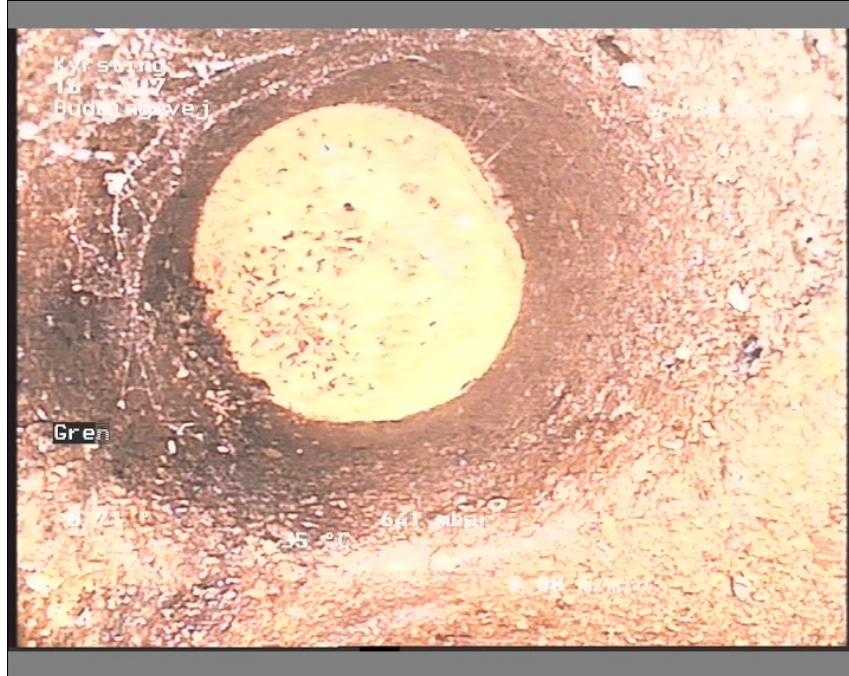
Foto: 16-1711240517-29-05-18_A.JPG, Medie #:: De Engelske _0, 00:00:37 13,07m, Grenrør klasse 0, urref 10, Stiktilslutning er afproppet
