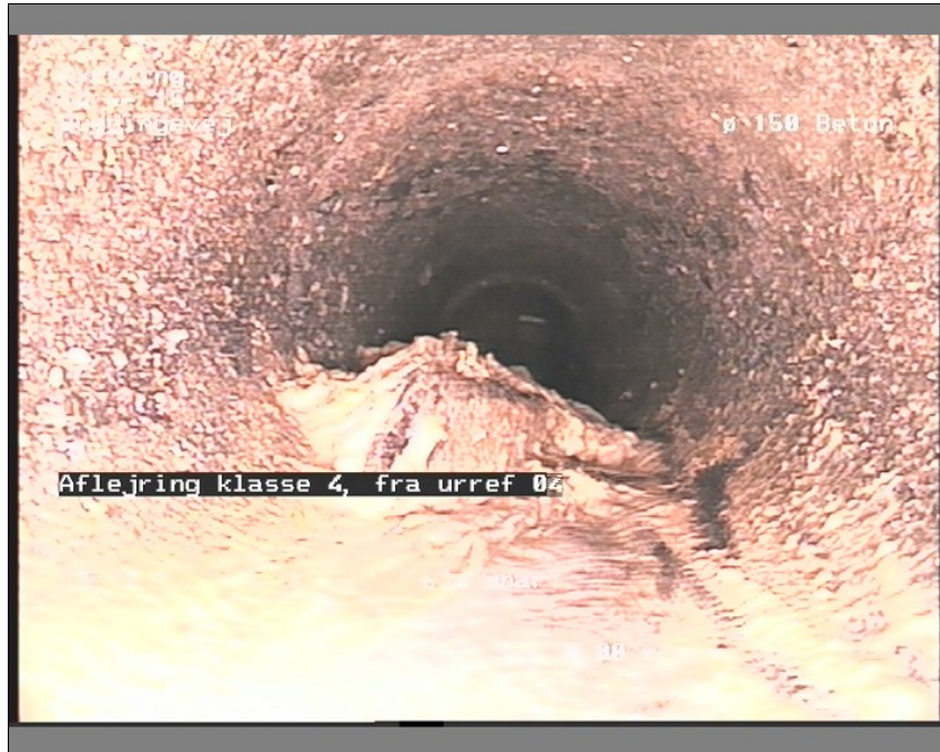
Foto: 14-151033278-29-05-18_A.JPG, Medie #: De Engelske _0, 00:05:25 11,16m, Aflejrning klasse 4, fra urref 04 til urref 08, Hårde materialer / skal cuttes væk
