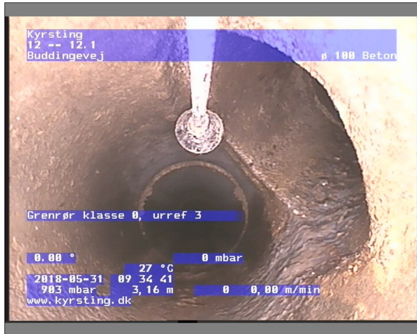
Foto: 12-12.10934566-29-05-18_A.JPG, Medie #.: De Engelske _0, 00:03:33 3,16m, Grenrør klasse 0, urref 3
