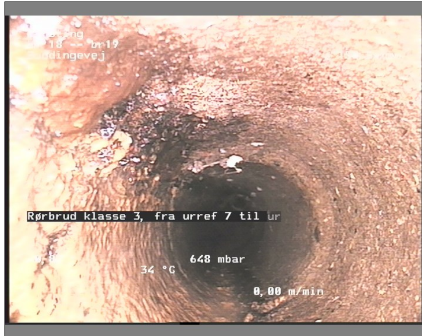
Foto: br 18-br1912354532-29-05-18_A.JPG, Medie #:: De Engelske _0, 00:09:14 22,18m, Rørbrud klasse 3, fra urref 7 til urref 10, Brud / gr foring
