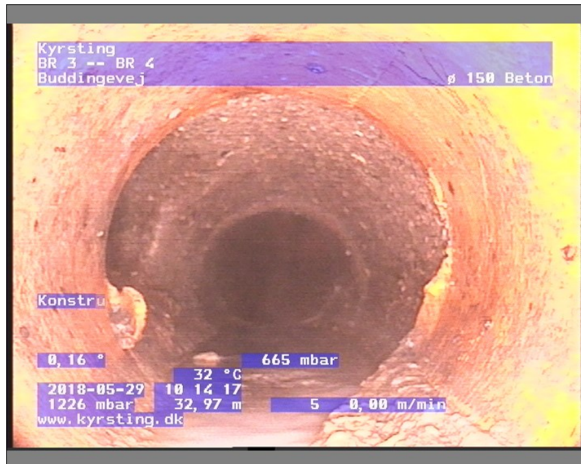
Foto: BR 3-BR 410142723-29-05-18_A.JPG, Medie #:: De Engelske _0, 00:09:58 32,97m, Konstruktionsændring klasse 3, Materialeændring, Dimensionsændring
