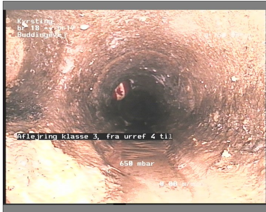
Foto: br 18-br1912293218-29-05-18_A.JPG, Medie #:: De Engelske _0, 00:06:11 14,55m, Aflejring klasse 3, fra urref 4 til urref 8, Hårde materialer, Fastsiddende, Start
