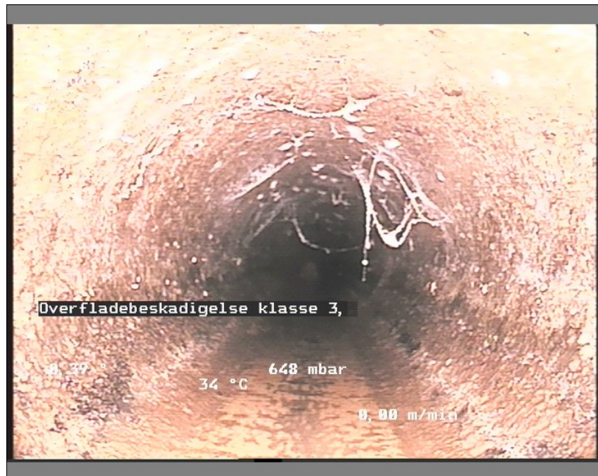
Foto: br 18-br1912324125-29-05-18_A.JPG, Medie #:: De Engelske _0, 00:07:50 18,12m, Overfladebeskadigelse klasse 3, fra urref 01 til urref 12, Stop
