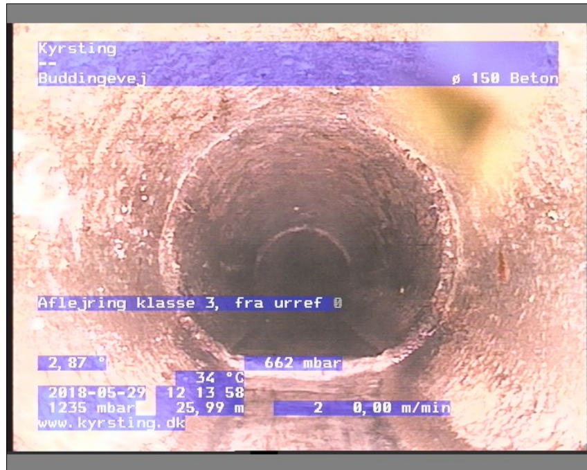
Foto: br 9-br1012140820-29-05-18_A.JPG, Medie #:: De Engelske _0, 00:08:43 25,99m, Aflejrning klasse 3, fra urref 04 til urref 07, Hårde materialer, Fastsiddende, Stop
