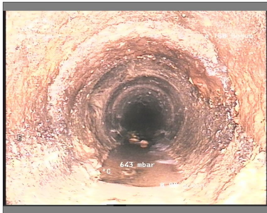
Foto: 16-1711302431-29-05-18_A.JPG, Medie #:: De Engelske _0, 00:00:37 22,2m, FS3, Åben samling
