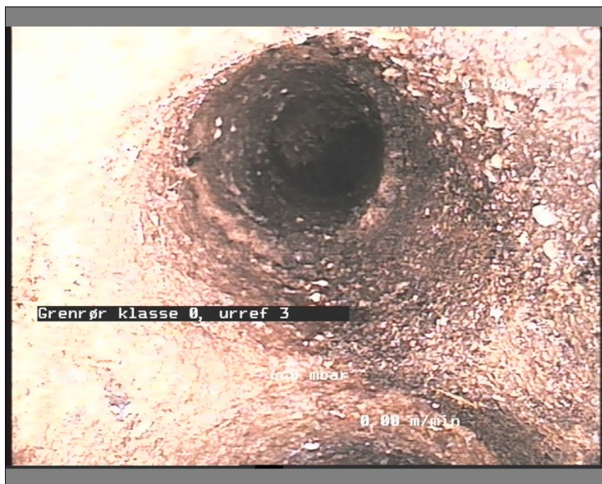
Foto: 15-2113344916-29-05-18_A.JPG, Medie #:: De Engelske _0, 00:03:57 11,83m, Grenrør klasse 0, urref 3
