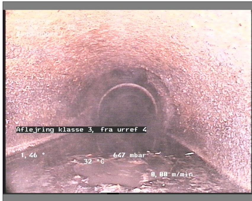
Foto: br 23-br 251027525-29-05-18_A.JPG, Medie #: De Engelske _0 4,64m, Aflejring klasse 3, fra urref 4 til urref 8, Hårde materialer, Sand/Grus
