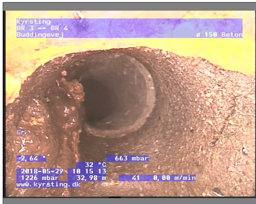
Foto: BR 3-BR 410152324-29-05-18_A.JPG, Medie #:: De Engelske _0, 00:10:15 32,98m, Grenrør klasse 1, urref 9 / aflejring i grenm og revne i toppen af røret.
