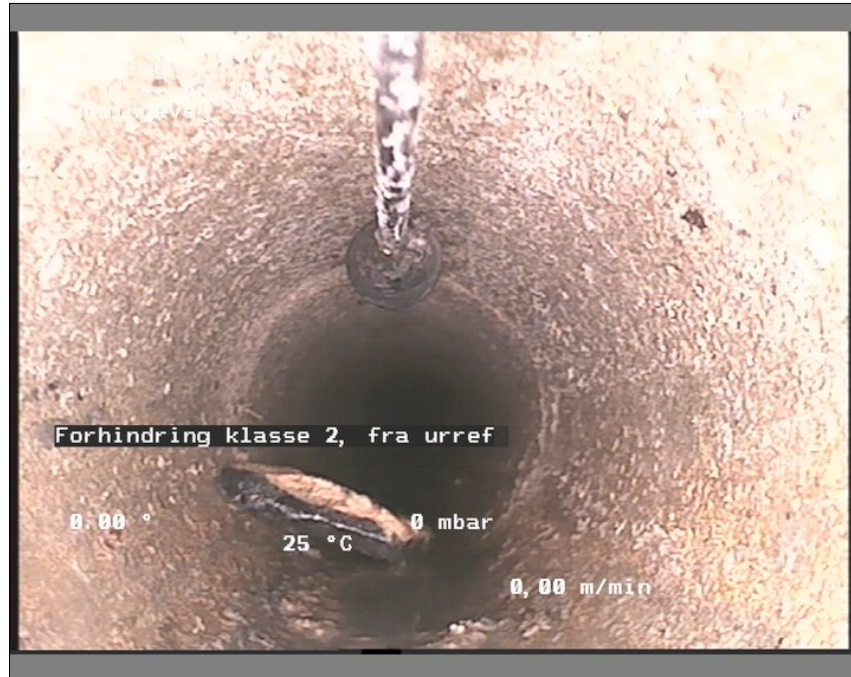
Foto: br 10-br 1113382312-29-05-18_A.JPG, Medie #: De Engelske _0, 00:05:25 35,83m, Forhindring klasse 2, fra urref 6 til urref 9, Genstand i bundløb, Forhindring er af anden type
