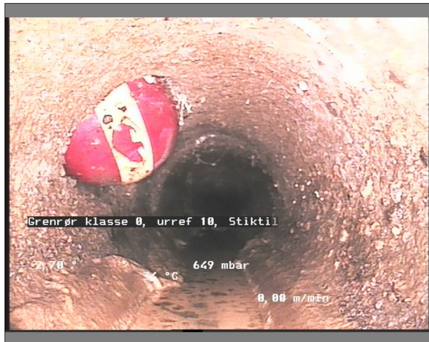
Foto: br 18-br1912304620-29-05-18_A.JPG, Medie #:: De Engelske _0, 00:06:49 15,2m, Grenrør klasse 0, urref 10, Stiktilslutning er afproppet / stikker ind i røret
