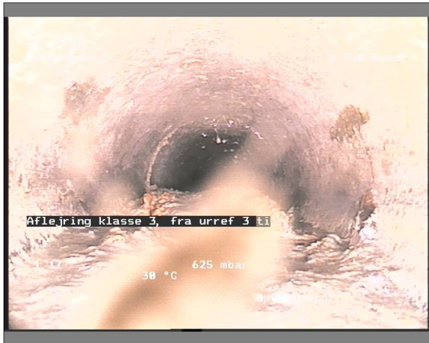
Foto: 23-251057376-29-05-18_A.JPG, Medie #.: De Engelske _0, 00:01:30 1,98m, Aflejring klasse 3, fra urref 3 til urref 9, Papir/Fækalier
