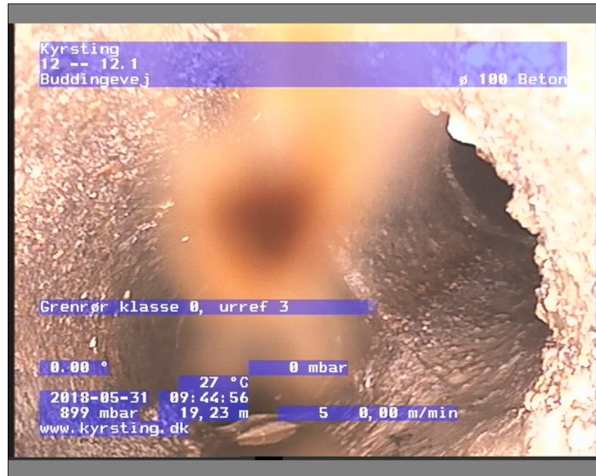
Foto: 12-12.109451121-29-05-18_A.JPG, Medie #: De Engelske _0, 00:10:22 19,23m, Grenrør klasse 0, urref 3
