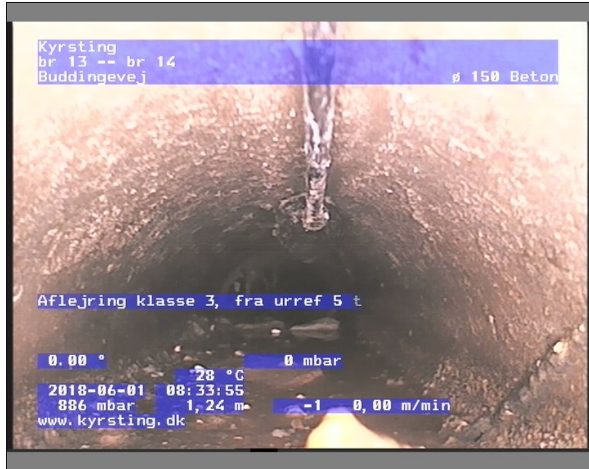
Foto: br 14-br 130834125-29-05-18_A.JPG, Medie #.: De Engelske _0, 00:02:32 1,24m, Aflejrning klasse 3, fra urref 5 til urref 7, Hårde materialer, Fastsiddende
