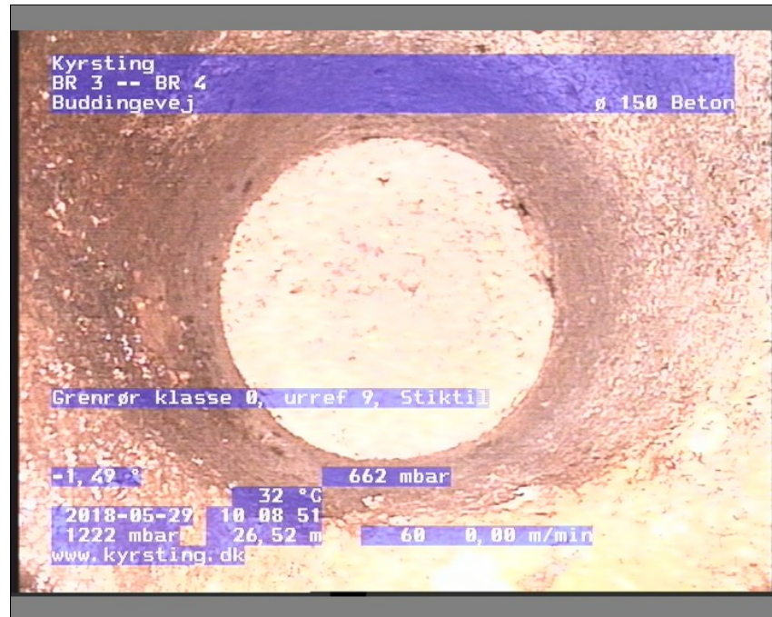
Foto: BR 3-BR 410090118-29-05-18_A.JPG, Medie #: De Engelske _0, 00:07:41 26,52m, Grenrør klasse 0, urref 9, Stiktilslutning er afproppet
