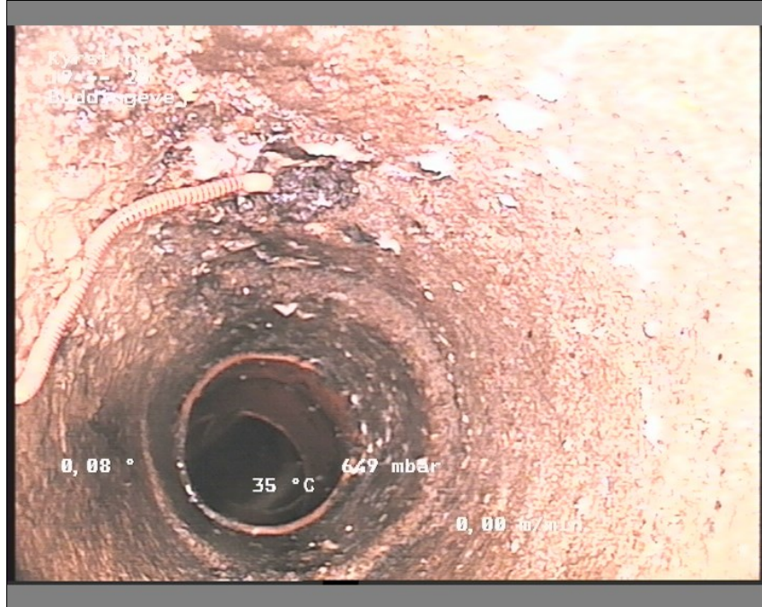
Foto: 19-2012501110-29-05-18_A.JPG, Medie #:: De Engelske _0, 00:02:12 43,18m, Grenrør klasse 0, urref 9
