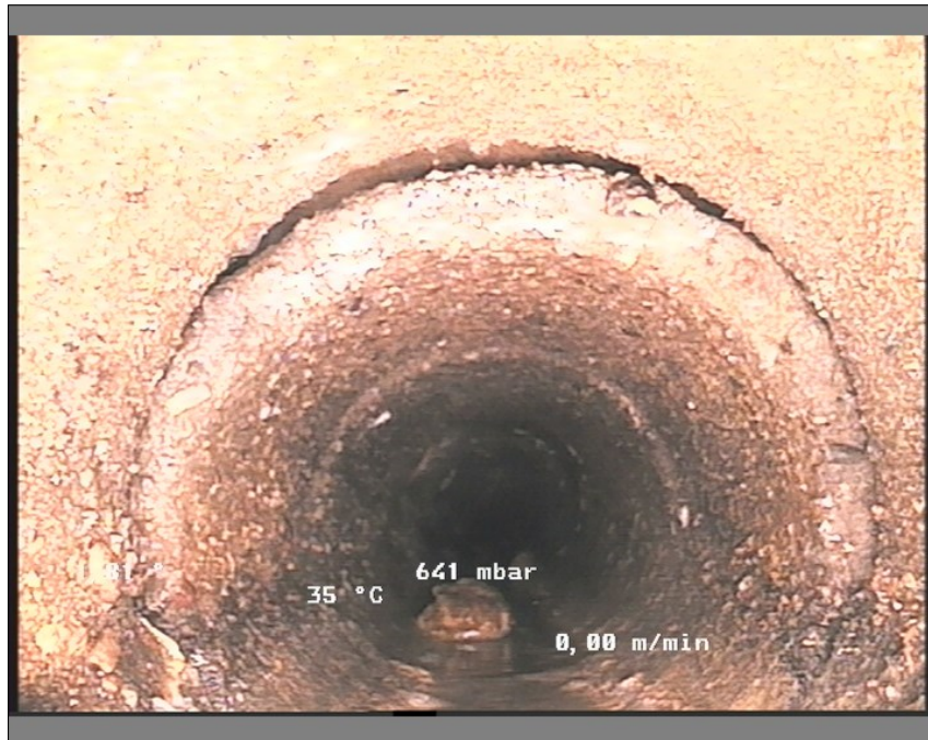
Foto: 16-1711250618-29-05-18_A.JPG, Medie #:: De Engelske _0, 00:00:37 14,4m, FS3, Åben samling
