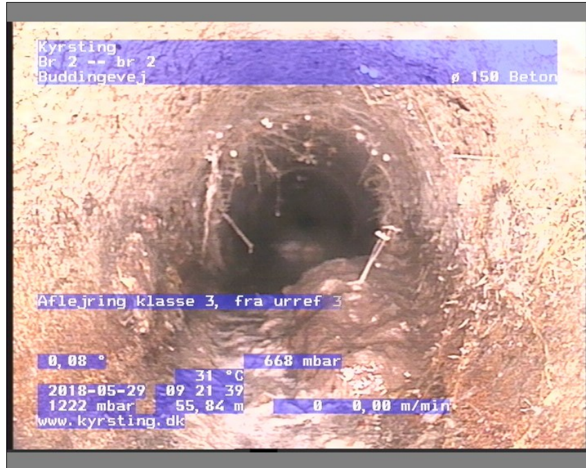
Foto: Br 2-br 209214932-29-05-18_A.JPG, Medie #:: De Engelske _0, 00:01:41 55,84m, Aflejring klasse 3, fra urref 3 til urref 6, Hårde materialer
