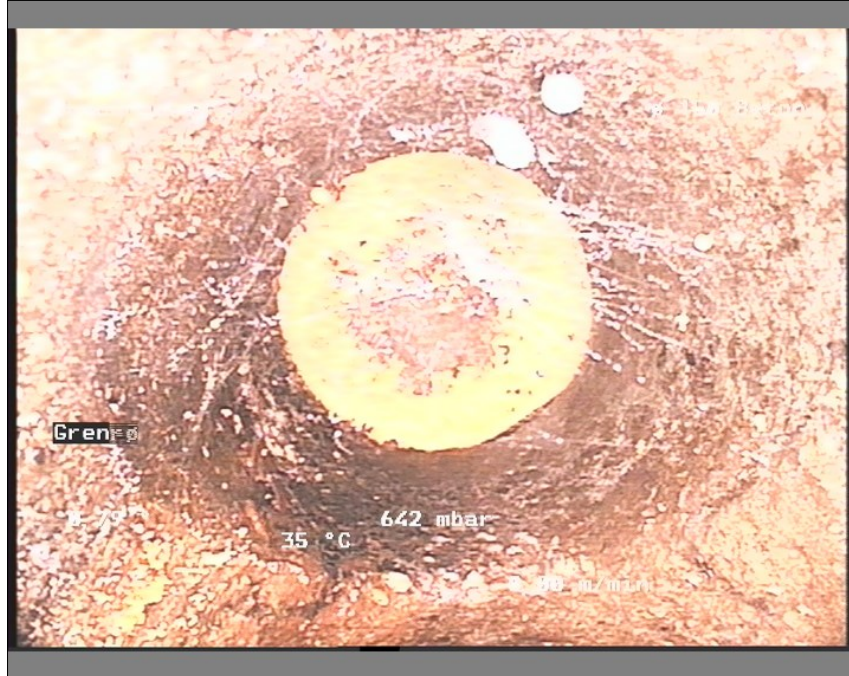
Foto: 16-1711283227-29-05-18_A.JPG, Medie #:: De Engelske _0, 00:00:37 20,01m, Grenrør klasse 0, urref 10, Stiktilslutning er afproppet
