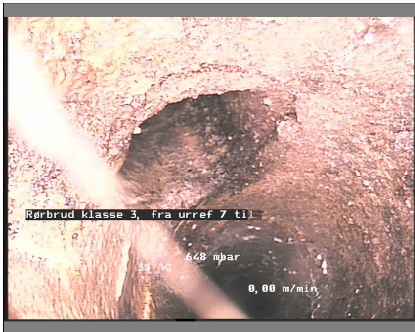
Foto: br 18-br1912405940-29-05-18_A.JPG, Medie #:: De Engelske _0, 00:11:58 29,68m, Rørbrud klasse 3, fra urref 7 til urref 11, Brud / brud i gr
