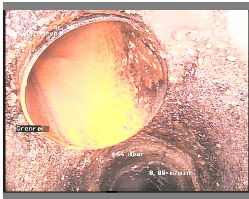
Foto: br 17-br 1812010727-29-05-18_A.JPG, Medie #.: De Engelske _0, 00:08:33 23,39m, Grenrør klasse 0, urref 10, Indragende foring/rør fra gren / fejl monteret
