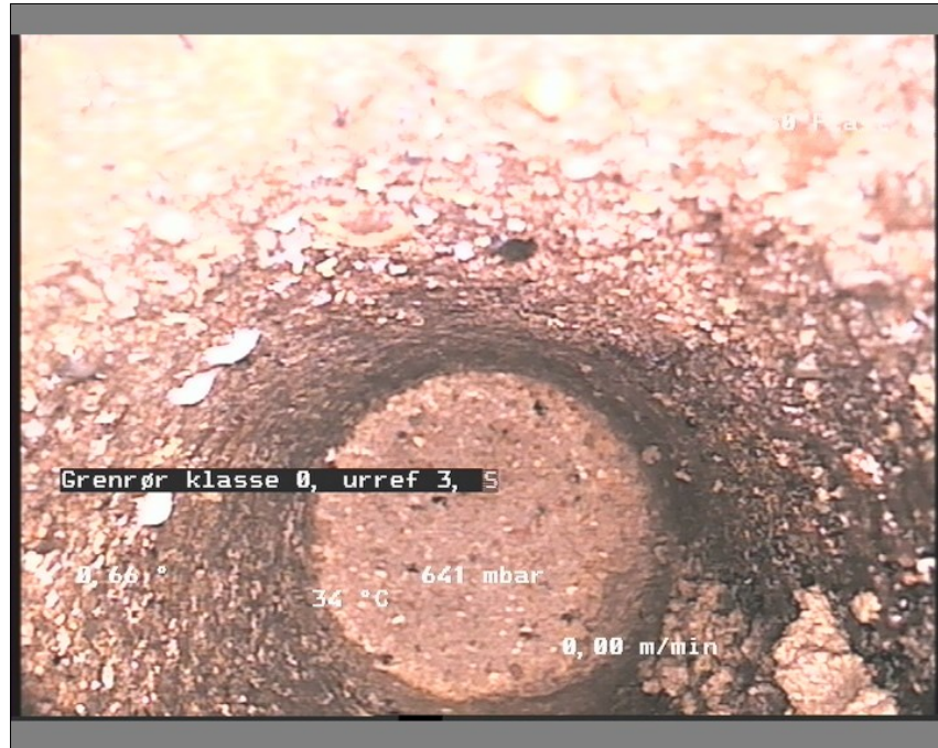
Foto: 15-2113334213-29-05-18_A.JPG, Medie #:: De Engelske _0, 00:03:25 10,9m, Grenrør klasse 0, urref 3, Stiktilslutning er afproppet
