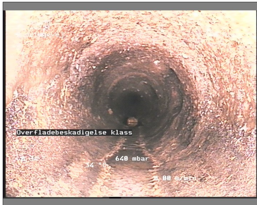
Foto: 15-21133341214-29-05-18_A.JPG, Medie #:: De Engelske _0, 00:03:37 11,17m, Overfladebeskadigelse klasse 3, fra urref 3 til urref 5
