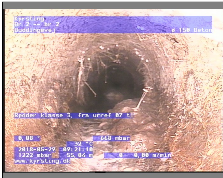
Foto: Br 2-br 209212031-29-05-18_A.JPG, Medie #:: De Engelske _0, 00:01:41 55,84m, Rødder klasse 3, fra urref 07 til urref 05, Fine rødder, Stop
