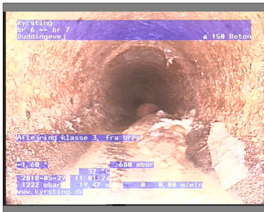
Foto: br 6-br 711013411-29-05-18_A.JPG, Medie #:: De Engelske _0, 00:07:14 19,47m, Aflejring klasse 3, fra urref 3 til urref 7, Papir/Fækali
