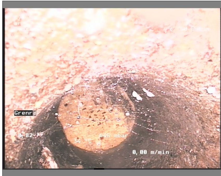
Foto: br 17-br 181205239-29-05-18_A.JPG, Medie #: De Engelske _0, 00:11:12 28,4m, Grenrør klasse 0, urref 10, Stiktilslutning er afproppet
