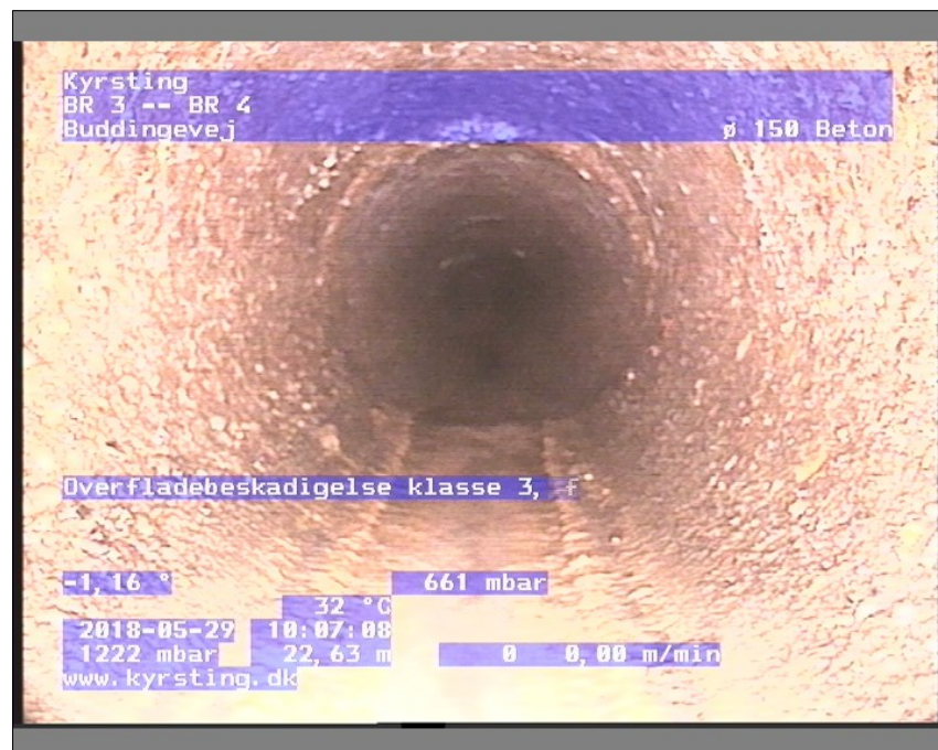
Foto: BR 3-BR 410071815-29-05-18_A.JPG, Medie #:: De Engelske _0, 00:06:32 22,63m, Overfladebeskadigelse klasse 3, fra urref 01 til urref 12, Stop
