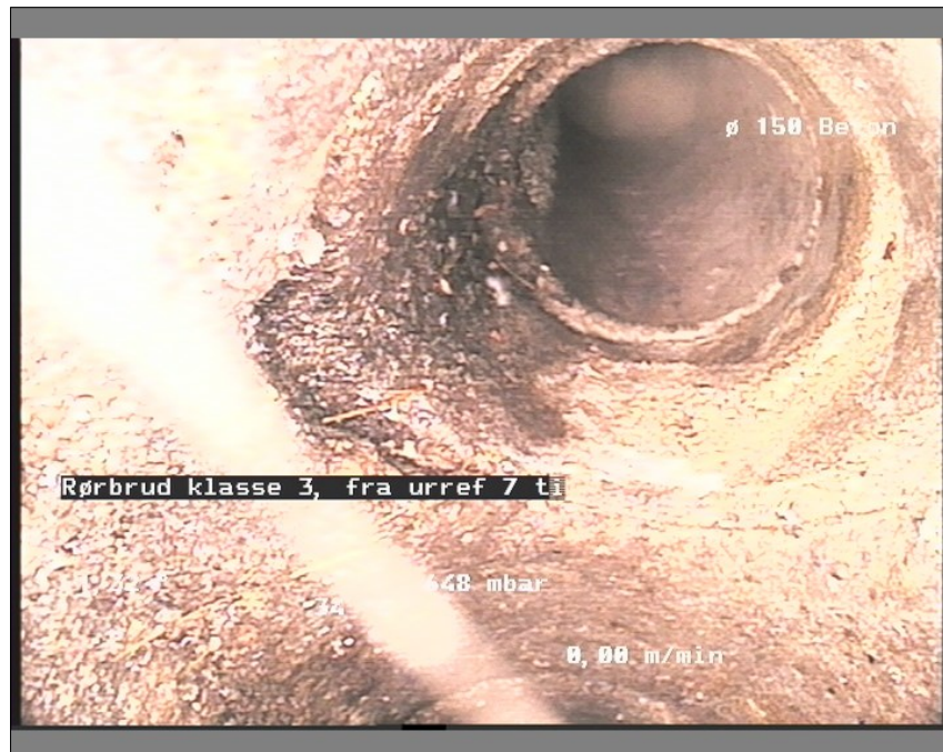
Foto: br 18-br1912370233-29-05-18_A.JPG, Medie #:: De Engelske _0, 00:09:47 22,8m, Rørbrud klasse 3, fra urref 7 til urref 8, Brud / brud i gr
