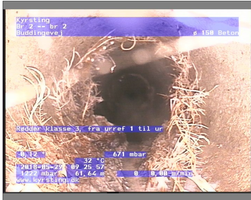
Foto: Br 2-br 209260735-29-05-18_A.JPG, Medie #:: De Engelske _0, 00:01:41 61,64m, Rødder klasse 3, fra urref 1 til urref 12, Fine rødder
