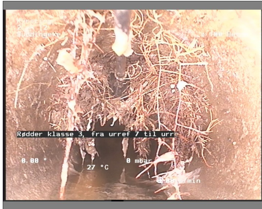
Foto: 2-1208444823-29-05-18_A.JPG, Medie #.: De Engelske _0, 00:02:01 13,81m, Rødder klasse 3, fra urref 7 til urref 4, Fine rødder
