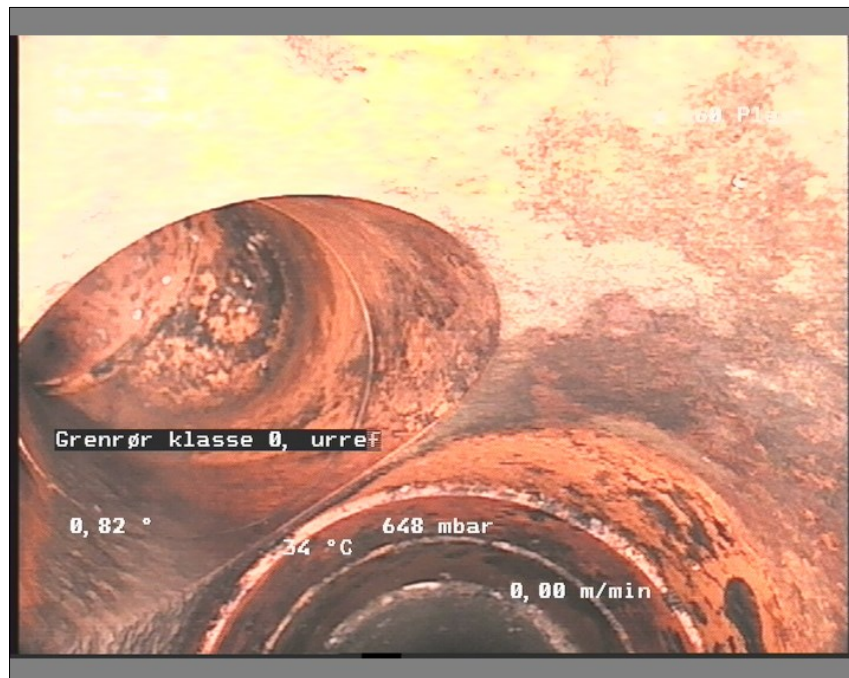
Foto: 19-201247003-29-05-18_A.JPG, Medie #.: De Engelske _0, 00:00:26 36,52m, Grenrør klasse 0, urref 9
