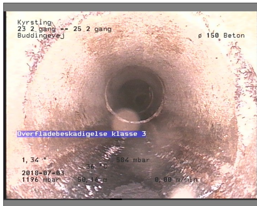
Foto: 23 2 gang-25 2 gang09413930-29-05-18_A.JPG, Medie #: De Engelske _0, 00:12:27 50,16m, Overfladebeskadigelse klasse 3, fra urref 4 til urref 8, Start
