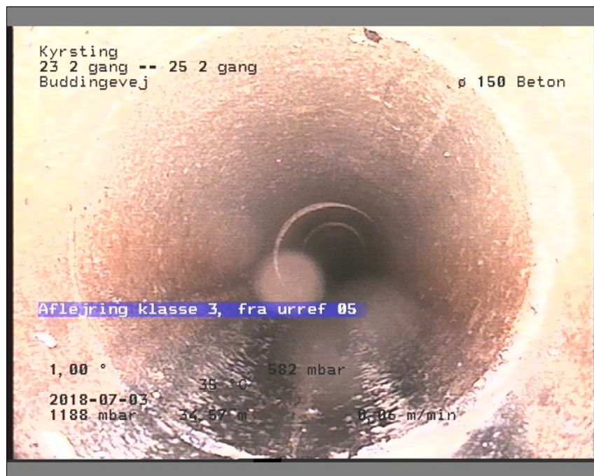
Foto: 23 2 gang-25 2 gang09350220-29-05-18_A.JPG, Medie #: De Engelske _0, 00:09:46 34,57m, Aflejrings klasse 3, fra urref 05 til urref 08, Hårde materialer, Stop
