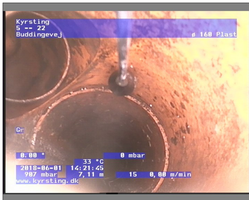
Foto: 5-221422016-29-05-18_A.JPG, Medie #.: De Engelske _0, 00:01:57 7,11m, Grenrør klasse 0, urref 9
