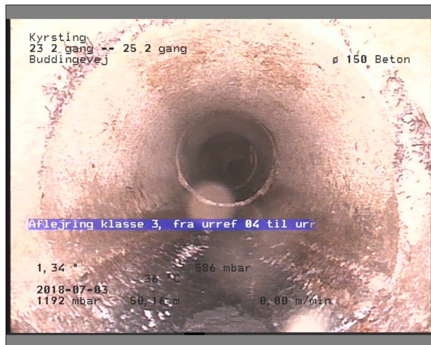
Foto: 23 2 gang-25 2 gang09392128-29-05-18_A.JPG, Medie #: De Engelske _0, 00:12:17 50,16m, Aflejring klasse 3, fra urref 04 til urref 08, Hårde materialer, Stop
