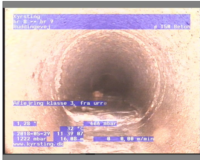
Foto: br 8-br 911391813-29-05-18_A.JPG, Medie #:: De Engelske _0, 00:04:20 16,08m, Aflejring klasse 3, fra urref 4 til urref 8, Hårde materialer, Fastsiddende
