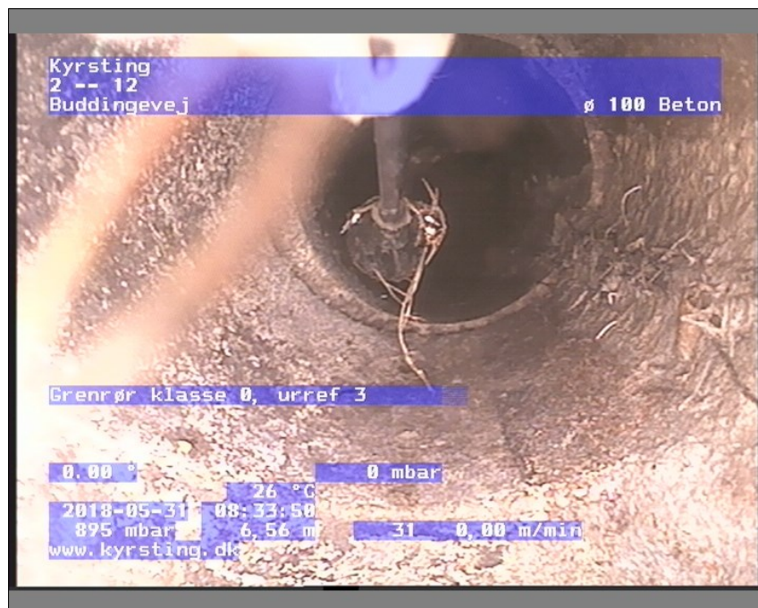
Foto: 2-1208340513-29-05-18_A.JPG, Medie #: De Engelske _0, 00:07:03 6,56m, Grenrør klasse 0, urref 3
