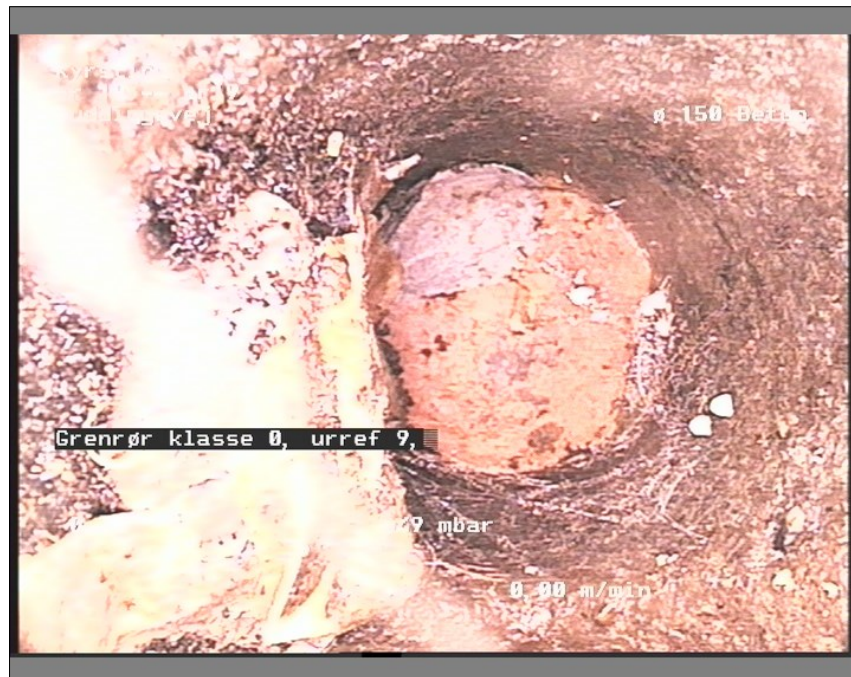
Foto: br 18-br1912383335-29-05-18_A.JPG, Medie #:: De Engelske _0, 00:10:56 28,46m, Grenrør klasse 0, urref 9, Stiktilslutning er afproppet
