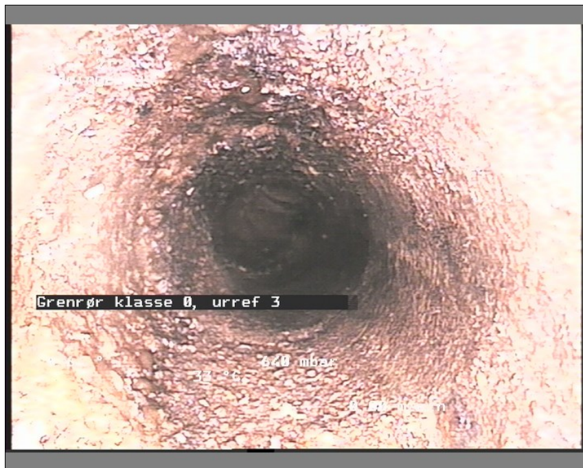
Foto: 15-2113343115-29-05-18_A.JPG, Medie #:: De Engelske _0, 00:03:47 11,83m, Grenrør klasse 0, urref 3
