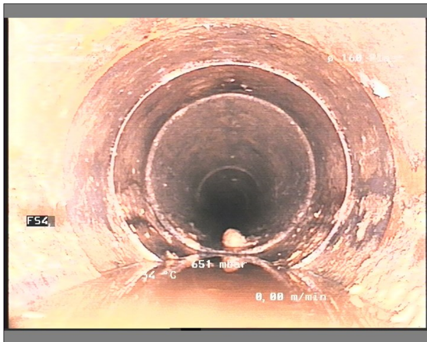
Foto: br 21-21a13572615-29-05-18_A.JPG, Medie #.: De Engelske _0, 00:04:14 20,38m, FS4, Åben samling
