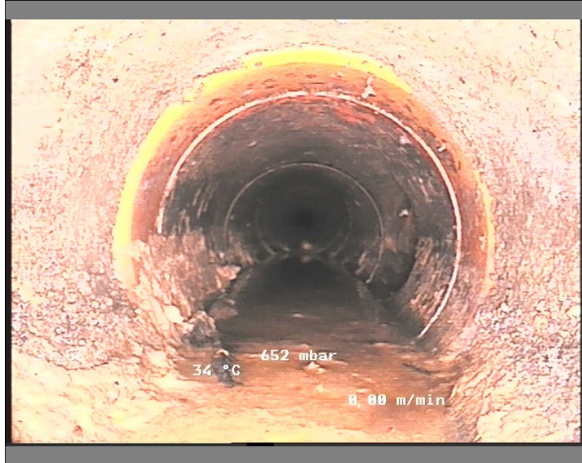
Foto: br 21-21a13563712-29-05-18_A.JPG, Medie #: De Engelske _0, 00:03:50 19,66m, Konstruktionsændring klasse 2, Materialeændring, Dimensionsændring
