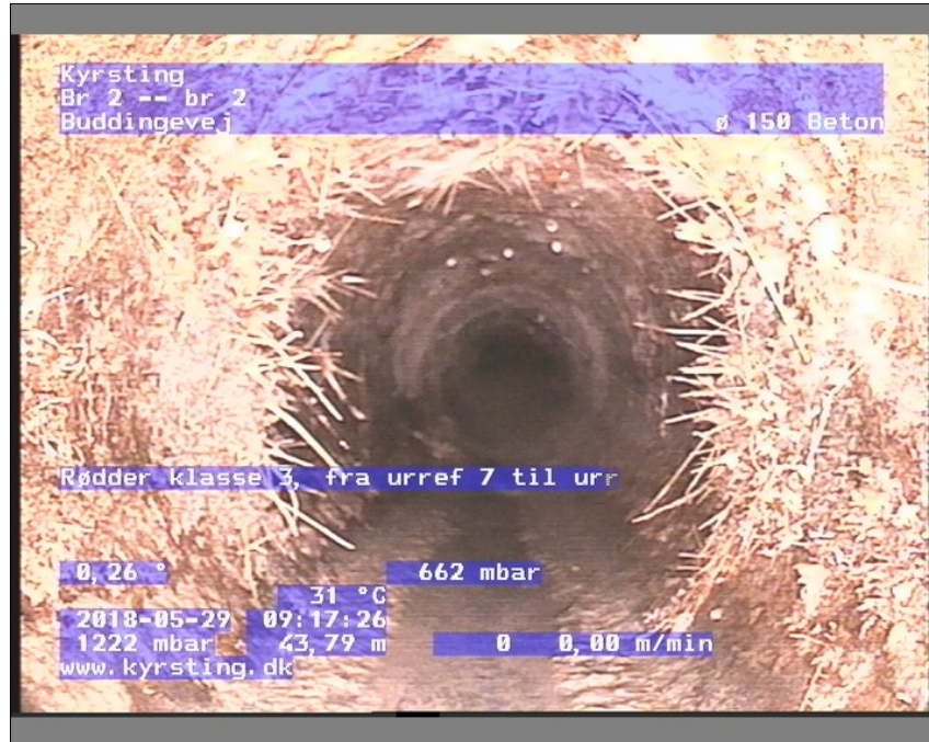
Foto: Br 2-br 209173527-29-05-18_A.JPG, Medie #:: De Engelske _0, 00:01:41 43,79m, Rødder klasse 3, fra urref 7 til urref 5, Fine rødder
