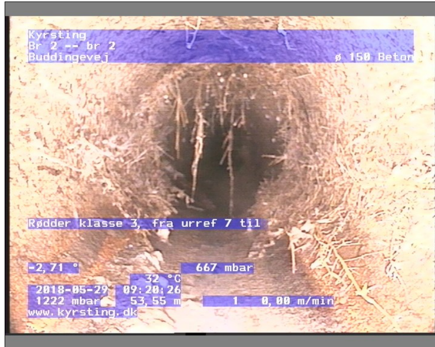
Foto: Br 2-br 209203630-29-05-18_A.JPG, Medie #:: De Engelske _0, 00:01:41 53,55m, Rødder klasse 3, fra urref 7 til urref 5, Fine rødder, Start
