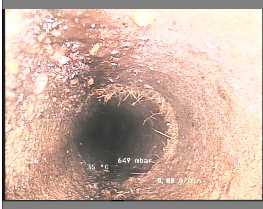
Foto: 19-2012532116-29-05-18_A.JPG, Medie #:: De Engelske _0, 00:03:57 50,04m, Grenrør klasse 0, urref 9
