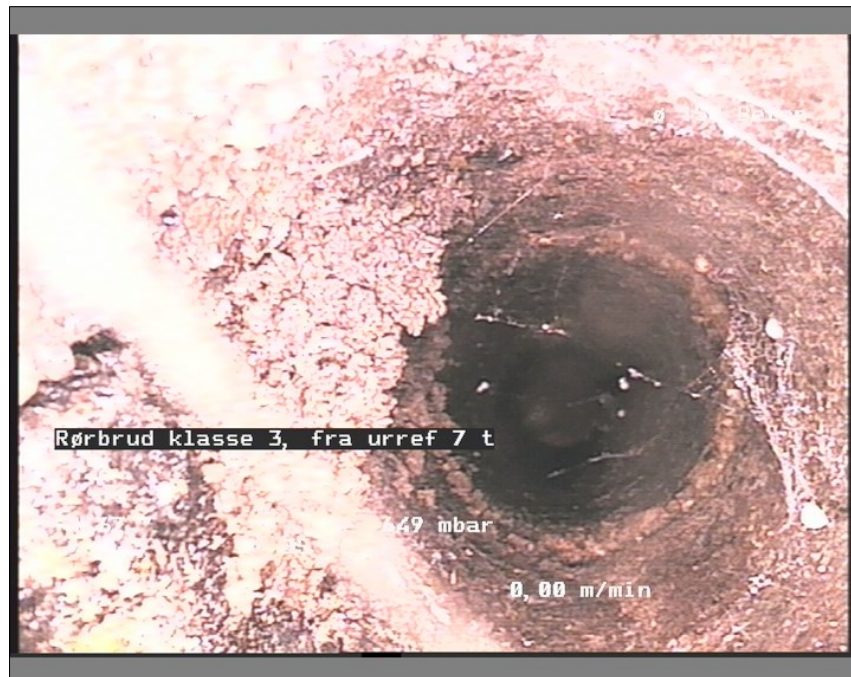
Foto: br 18-br1912393637-29-05-18_A.JPG, Medie #: De Engelske _0, 00:11:21 29,11m, Rørbrud klasse 3, fra urref 7 til urref 9, Brud / brud i gr
