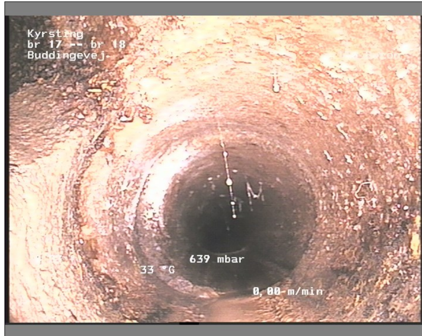
Foto: br 17-br 1811474713-29-05-18_A.JPG, Medie #: De Engelske _0, 00:03:23 9,2m, Rørbrud klasse 2, fra urref 6 til urref 12, Cirkulær revne vinkelret på røaksen
