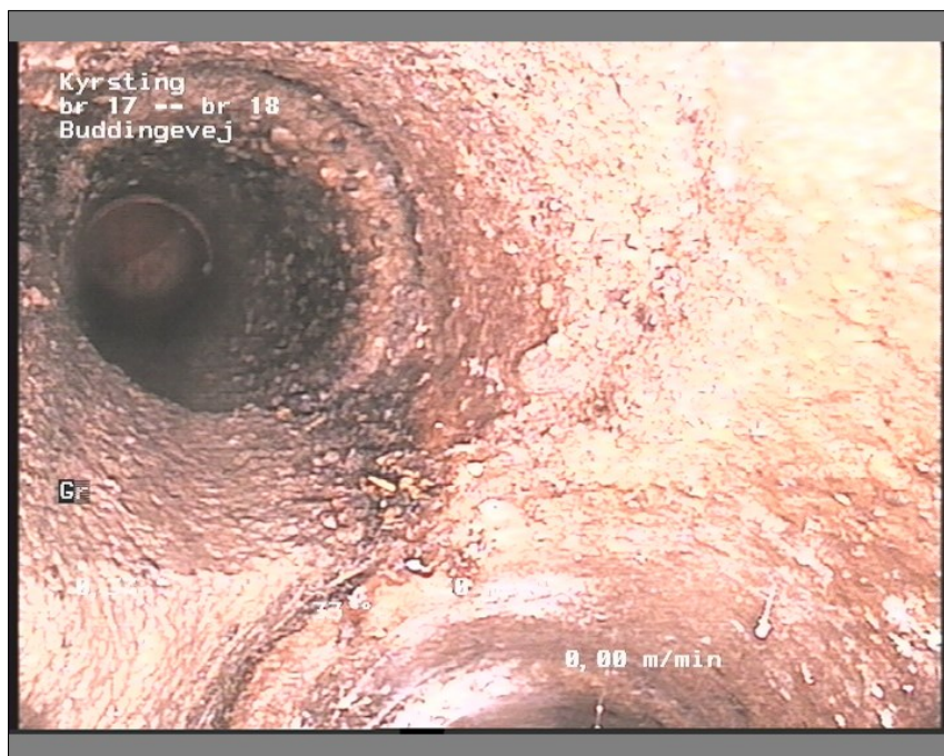
Foto: br 17-br 1811465212-29-05-18_A.JPG, Medie #: De Engelske _0, 00:02:55 9,2m, Grenrør klasse 0, urref 10 / fs 3 i grenrør
