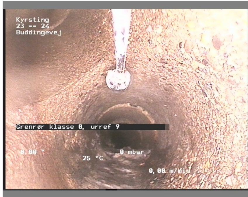
Foto: 23-240953215-29-05-18_A.JPG, Medie #.: De Engelske _0, 00:01:30 2,97m, Grenrør klasse 0, urref 9
