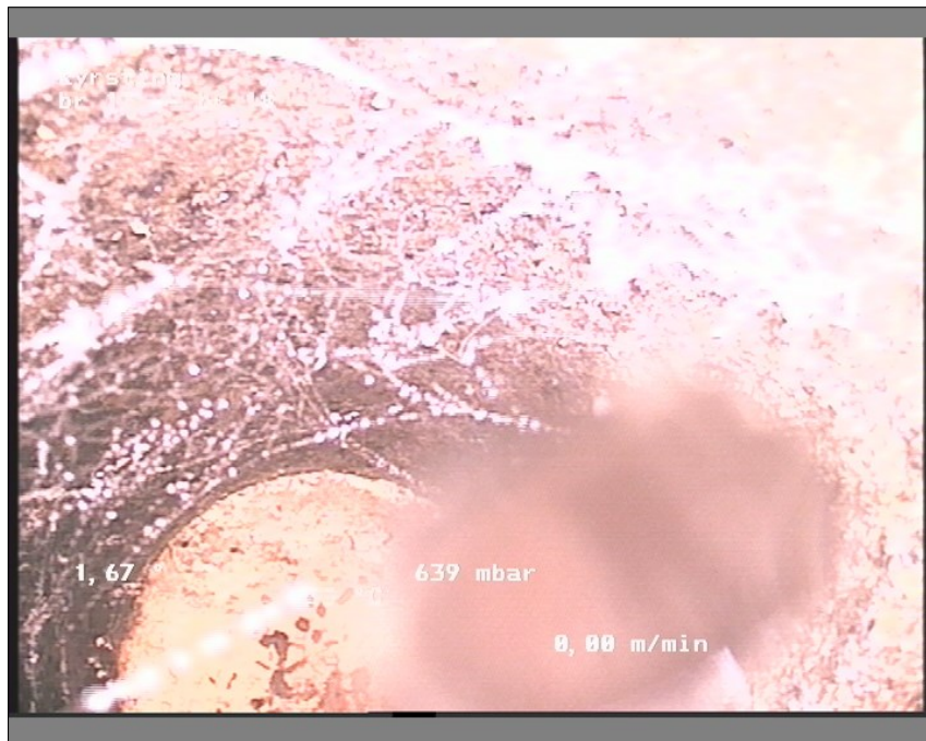
Foto: br 17-br 1811454110-29-05-18_A.JPG, Medie #.: De Engelske _0, 00:02:03 6,9m, Grenrør klasse 0, urref 11, Stiktilslutning er afproppet
