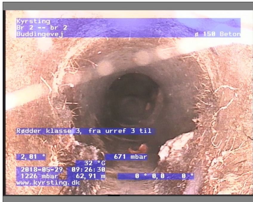
Foto: Br 2-br 209264036-29-05-18_A.JPG, Medie #:: De Engelske _0, 00:01:41 62,91m, Rødder klasse 3, fra urref 3 til urref 9, Fine rødder
