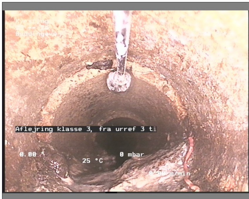
Foto: 23-240954258-29-05-18_A.JPG, Medie #: De Engelske _0, 00:01:56 3,19m, Aflejring klasse 3, fra urref 3 til urref 9, Hårde materialer
