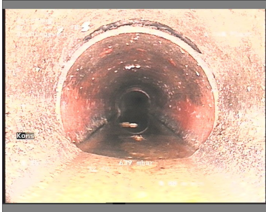
Foto: br 17-br 181142464-29-05-18_A.JPG, Medie #: De Engelske _0, 00:00:15 1,29m, Konstruktionsændring klasse 3, Dimensionsændring, Materialeændring
