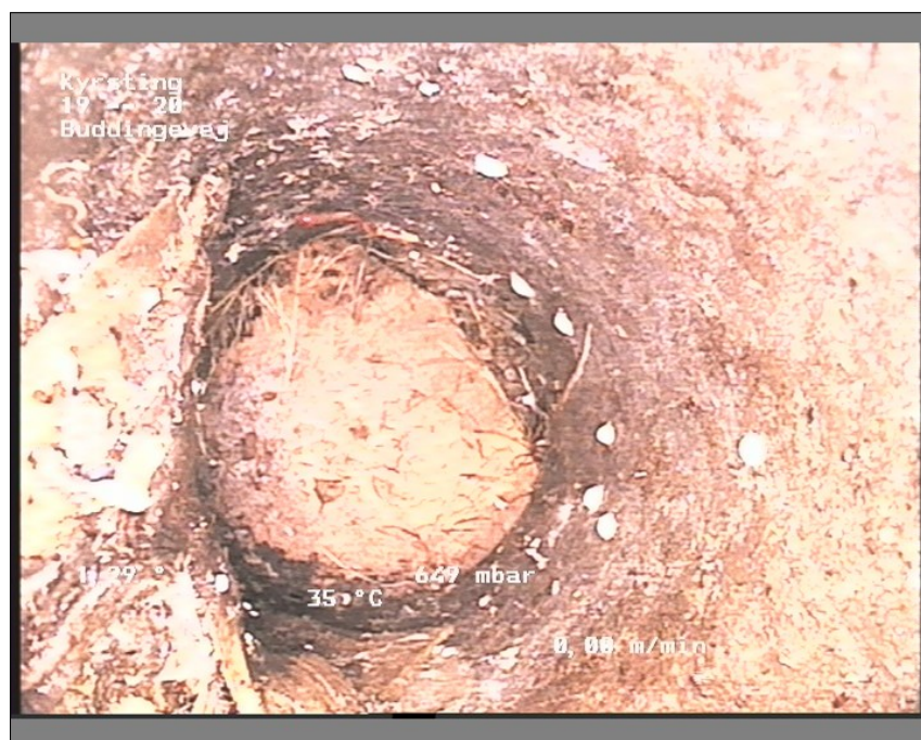
Foto: 19-201249178-29-05-18_A.JPG, Medie #.: De Engelske _0, 00:01:41 42,62m, Grenrør klasse 0, urref 10, Stiktilslutning er afproppet
