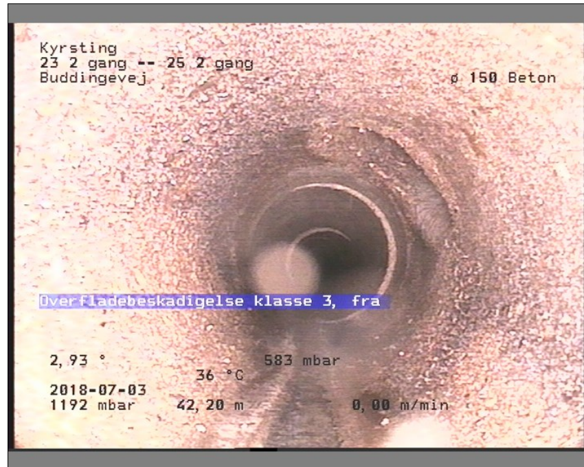
Foto: 23 2 gang-25 2 gang09374525-29-05-18_A.JPG, Medie #: De Engelske _, 00:11:22 42,2m, Overfladebeskadigelse klasse 3, fra urref 1 til urref 12, Start
