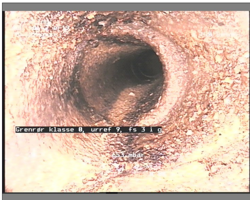
Foto: br 18-br1912251611-29-05-18_A.JPG, Medie #:: De Engelske _0, 00:04:16 8,47m, Grenrør klasse 0, urref 9 / fs 3 i gr
