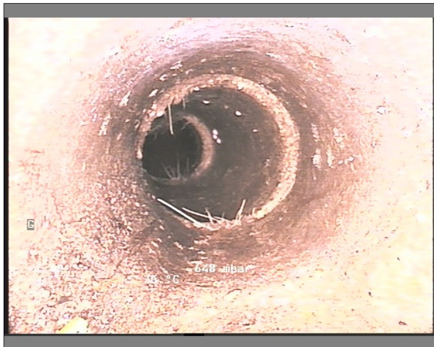
Foto: 19-2012540619-29-05-18_A.JPG, Medie #:: De Engelske _0, 00:04:19 50,63m, Grenrør klasse 0, urref 9
