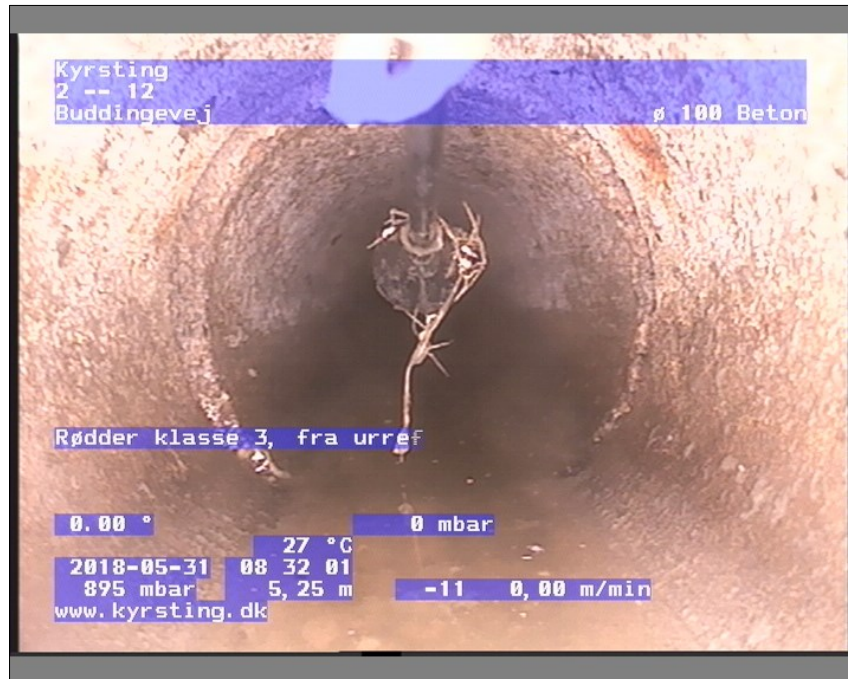
Foto: 2-1208321610-29-05-18_A.JPG, Medie #: De Engelske _0, 00:05:48 5,25m, Rødder klasse 3, fra urref 01 til urref 12, Fine rødder, Stop
