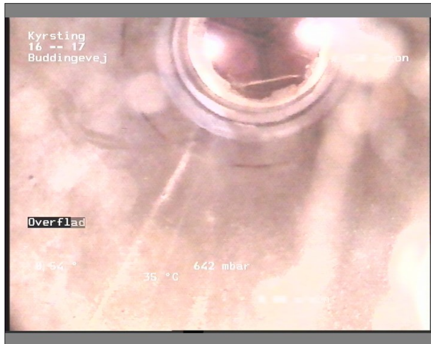
Foto: 16-1711374434-29-05-18_A.JPG, Medie #:: De Engelske _0 27,07m, Overfladebeskadigelse klasse 3, fra urref 01 til urref 12, Stop
