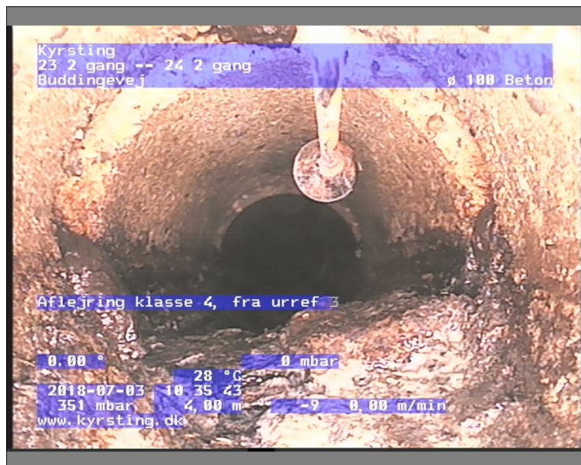
Foto: 23 2 gang-24 2 gang1037195-29-05-18_A.JPG, Medie #: De Engelske _0, 00:00:59 4m, Aflejring klasse 4, fra urref 3 til urref 8, Hårde materialer, Fastsiddende
