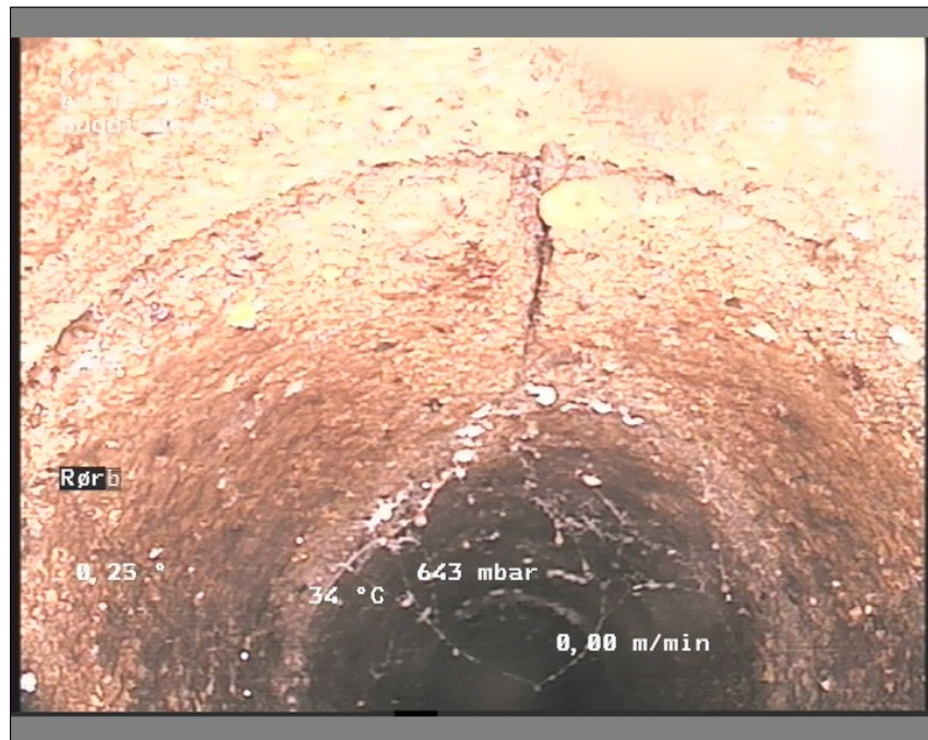
Foto: br 17-br 1812023732-29-05-18_A.JPG, Medie #: De Engelske _0, 00:09:01 23,52m, Rørbrud klasse 3, fra urref 12 til urref 1, Brud
