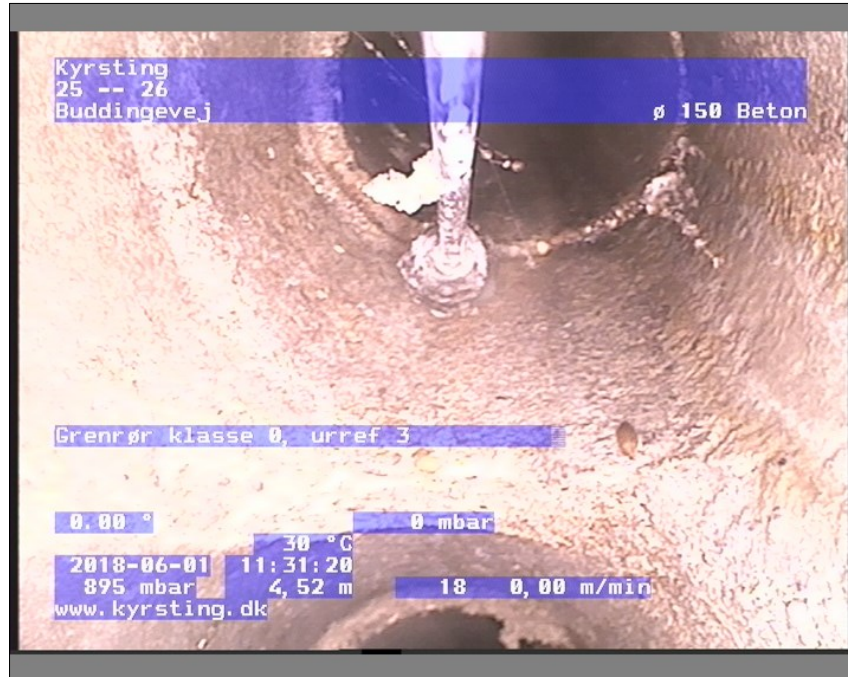
Foto: 25-261131376-29-05-18_A.JPG, Medie #.: De Engelske _0, 00:01:59 4,52m, Grenrør klasse 0, urref 3
