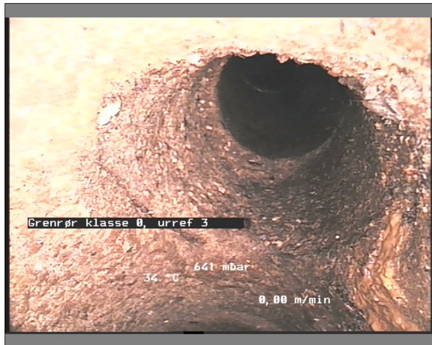
Foto: 15-2113321710-29-05-18_A.JPG, Medie #.: De Engelske _0, 00:02:45 8,52m, Grenrør klasse 0, urref 3
