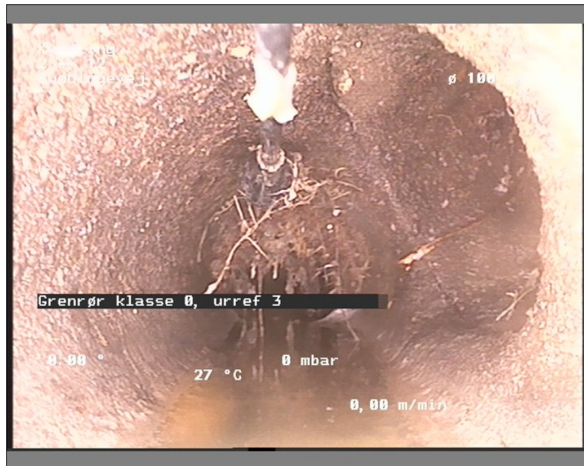
Foto: 2-1208441922-29-05-18_A.JPG, Medie #.: De Engelske _0, 00:01:49 13,59m, Grenrør klasse 0, urref 3
