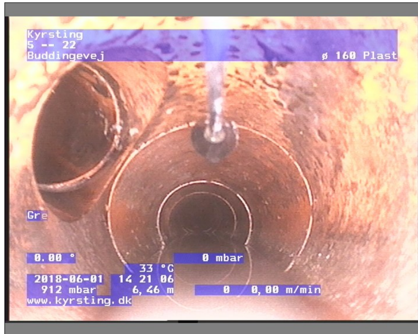
Foto: 5-221421234-29-05-18_A.JPG, Medie #.: De Engelske _0, 00:01:35 6,46m, Grenrør klasse 0, urref 9
