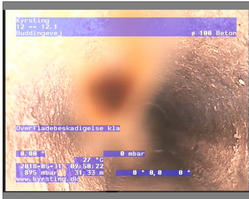
Foto: 12-12.109505329-29-05-18_A.JPG, Medie #: De Engelske _0, 00:14:59 31,33m, Overfladebeskadigelse klasse 3, fra urref 2 til urref 11, Start
