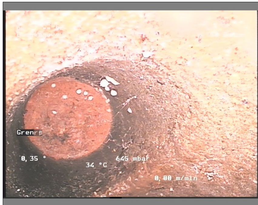
Foto: br 17-br 1812052138-29-05-18_A.JPG, Medie #: De Engelske _0, 00:10:56 27,94m, Grenrør klasse 0, urref 10, Stiktilslutning er afproppet
