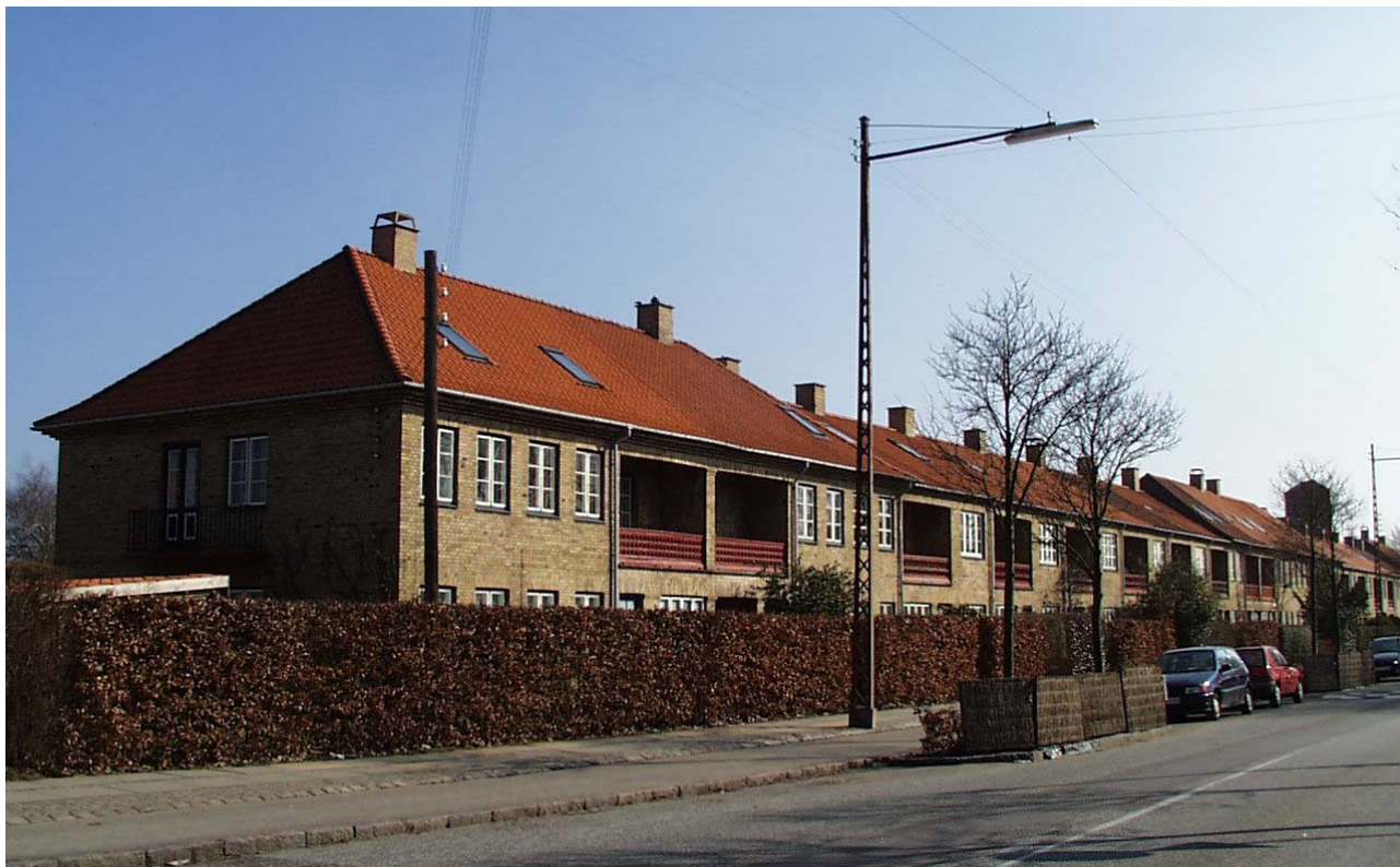
På Christian X's Allé har forhaverne hækbeplantning mod vej. På Christian X's Allé må forhaverne ikke indrettes til parkering, da der er mulighed for parkering på vejen og på p-pladsen på Christian X's Allé 99. På billedet ses variationen i tagfladen på rækkehusstokken tydeligt.
