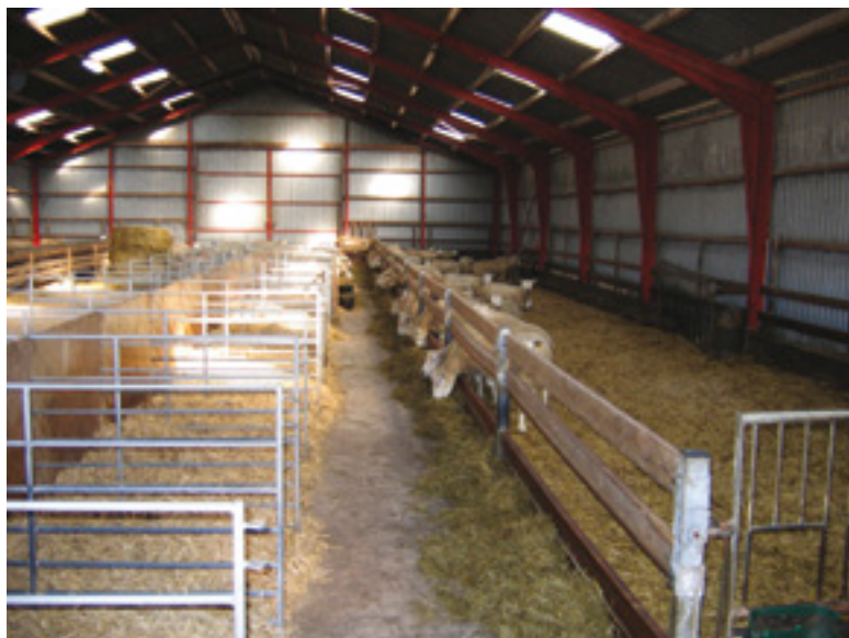
Højre side af stalden. Der er mulighed for at inddеле afsnittet i sektioner. Der er naturlig ventilation gennem de perforerede plader. Læmmeboksene er stationære og med et skillerum lavet af krydsfiner mellem de 2 sektioner. Der er i alt 32 læmmebokse til rådighed. Ved en læmmeperiode på 20-25 dage, svarende til 6-7 læmninger pr. døgn, kan får med lam være 4-5 dage i læmmeboksen.
