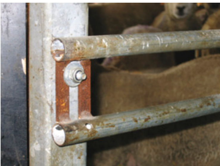
Foderbordsdetalje – rørene kan hæves i takt med lammernes vækst.
