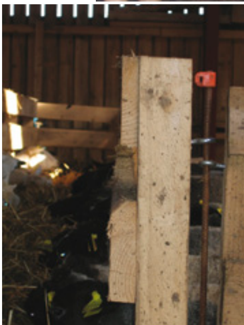
Grindens fæstning til foderbordet.
