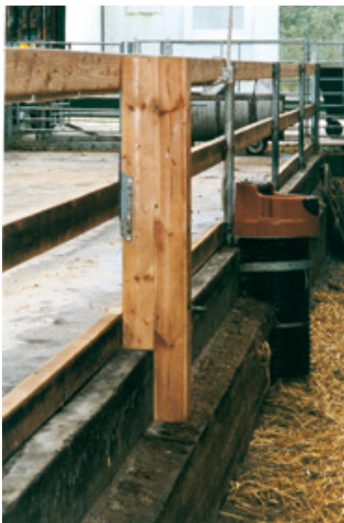
Bemærk de tværgående foderborde samt udformningen af væggen, der giver en fortrinlig naturlig ventilation. Den nederste halvdel af væggen er opført af betonelementer. Stalden tilhører Mette Marie Thomsen og Svend-Erik Svenningsen, Vinderup. Foderbordet er hævet i forhold til lejet. Bemærk anvendelsen af grinder.
