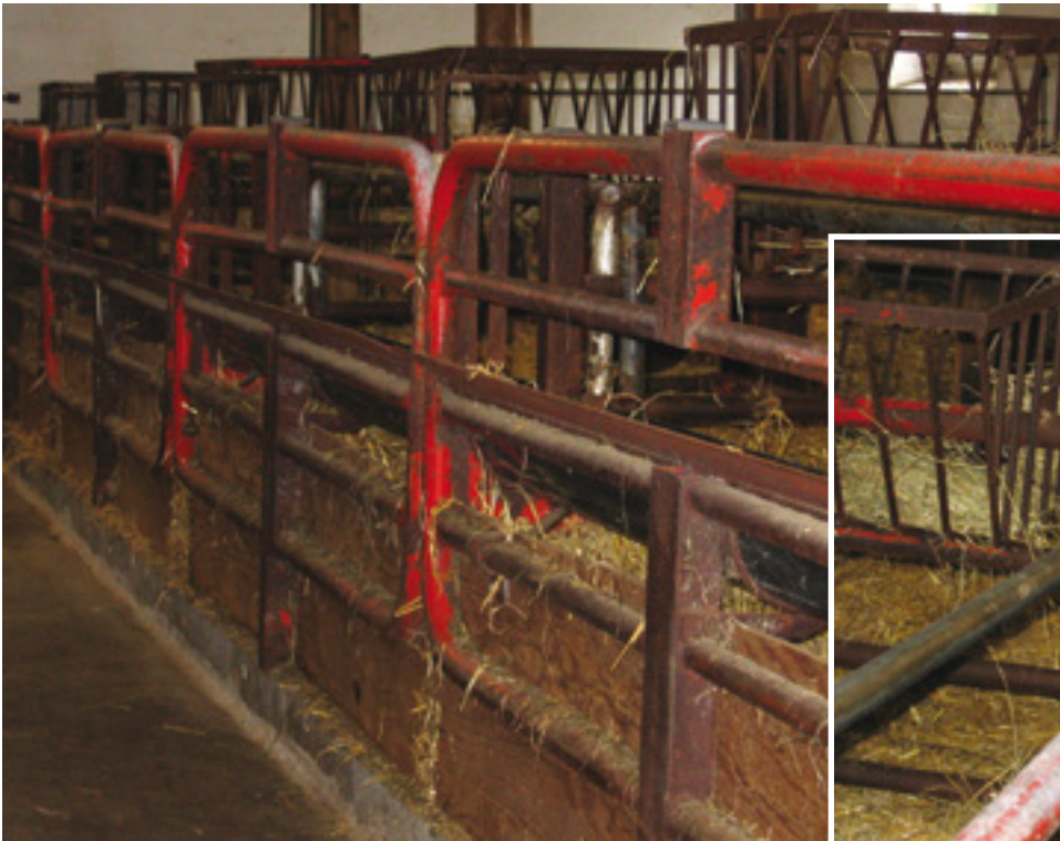
Højre sides forværk lavet af rør. Nederst er anvendt krydsfinerplade.
