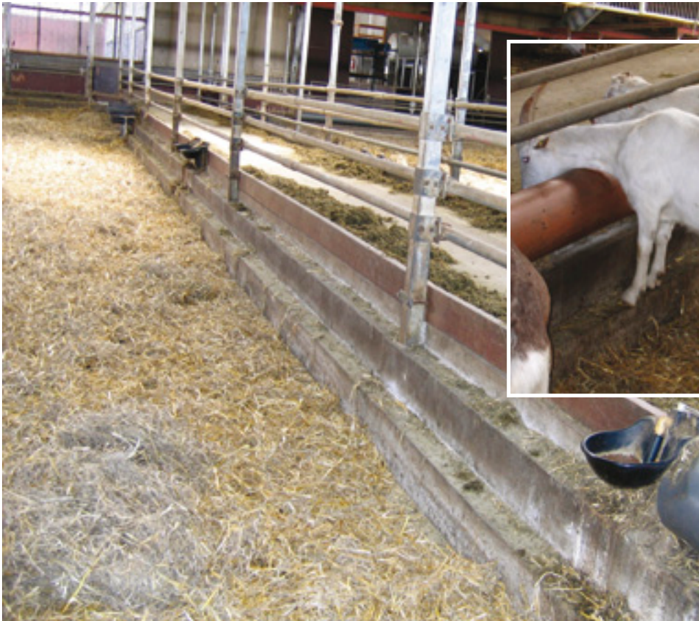
Foran foderbordet er projekteret en såkaldt »gedetrappe«, som gederne meget gerne vil stå på. Billedet viser kun 2 sektioner, mens den 3. sektion er under dybstrøelsen. Højden på trappen er 20 cm, mens bredden er 10 cm. Brættet ved foderbordet er 15 cm, mens mellemrummene mellem rørene er 16 cm. Forværkets samlede højde er 75 cm over foderbordet.
