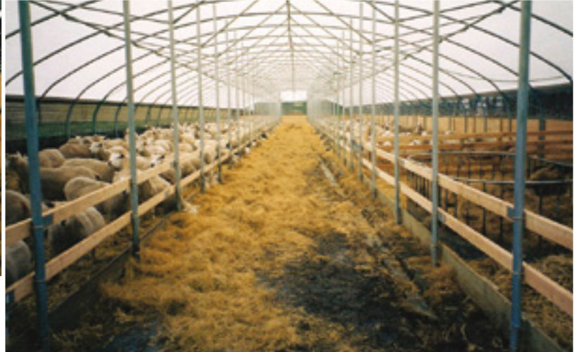
Polytunnel stald tilhørende David Wotton på Fuglsang. Beklædning med plader på siderne – dermed læ, men naturlig ventilation alligevel.
