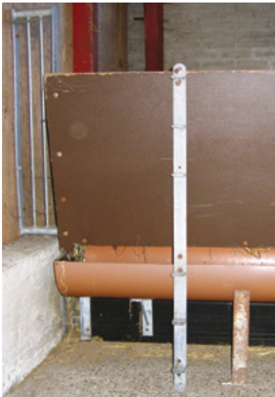
Stolpe og fod til forværk m.m. Foden er støbt ned og der kan sættes låg på, når stolpen fjernes. Forværket kan hæves i takt med gødningsmåttens tykkelse – jvnf. udformningen af stolpen.
