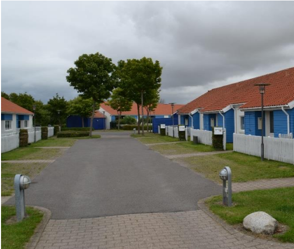
Det sidste nye kvarter i Dannemare er den almennyttige bebyggelse omkring Jørgen C. Pedersensvej, der kom til efter 1990. I 2016 er fem af kvarterets ungdomsboliger indstillet til nedrivning
