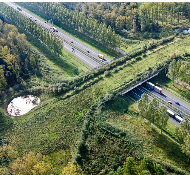
Faunapassage over motorvej i Holland, foto Grond, Groen & Water
