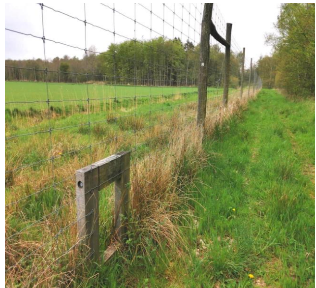
Eksempel på semi-permeable hegn, der kun holder de store græssere inde. Fra mellemområdet i Lille Vildmose. foto Rune Engelbreth Larsen
