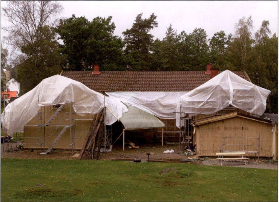
Nymanska gården renoveras. Foto Jan Berg.
