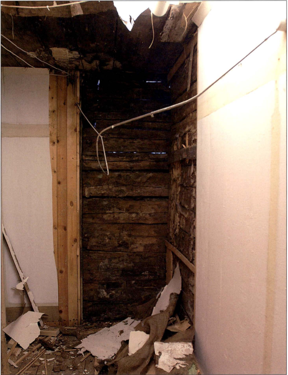
Invändig renovering av fuktskada i Nymanska gården 2008. Gammalt trä ersätts med nytt, en förutsättning för bevarandet av helheten. Foto Jan Berg.
