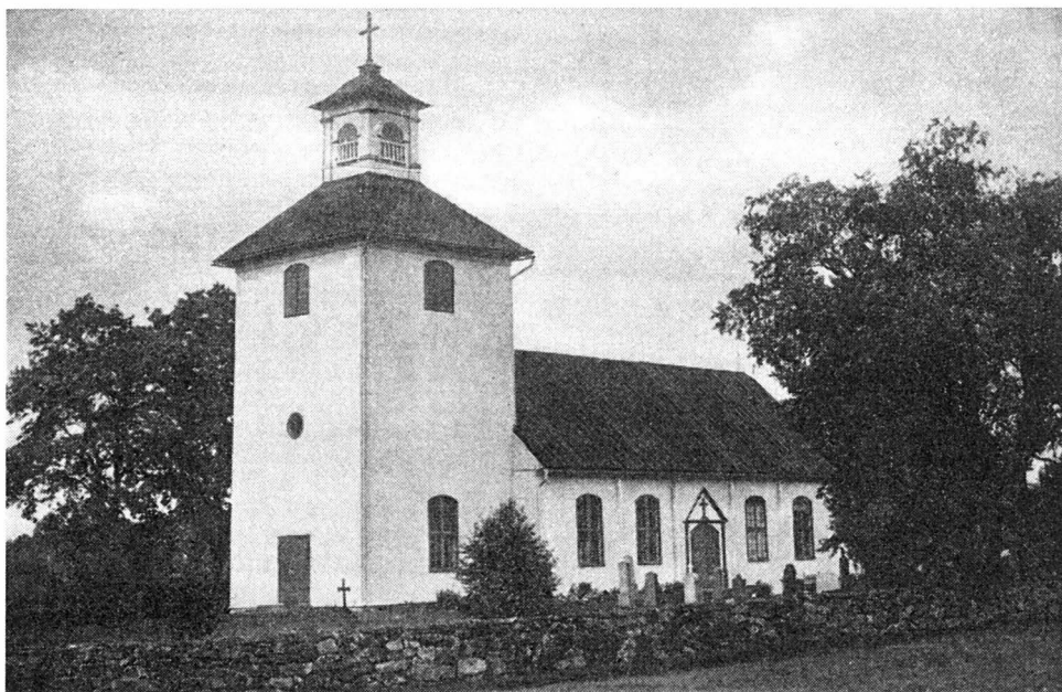
Håcksviks kyrktorn, som erhöill sin nuvarande form 1791, bevarar delar av ett gammalt försvars- eller vaktorn och är timrat av kraftiga stockar. Kyrkan uppfördes 1826.
