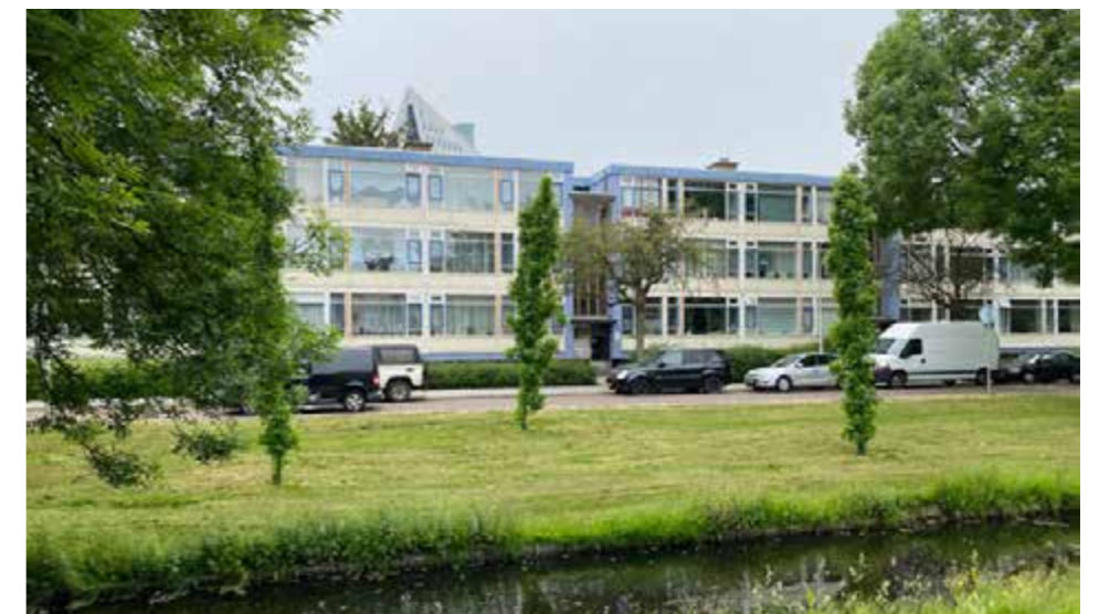
Portiekflat aan de Enschedelaan. Terugliggende, transparante trappenhuizen met luifels zorgen voor ritmiek en plastiek in de continue gevelwand
