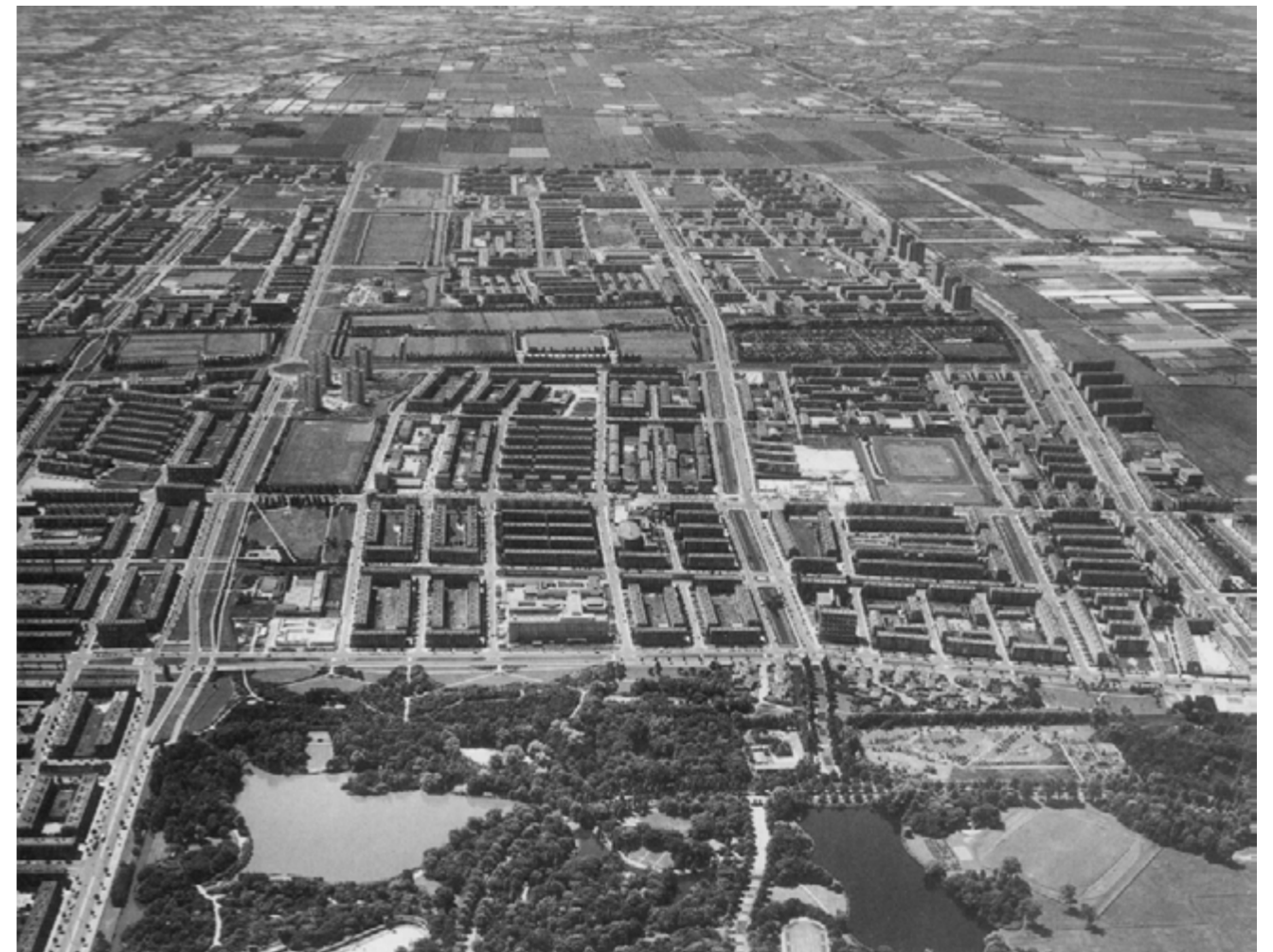
Luchtfoto van Morgenstond (onder) en Bouwlust met centraal het groene, nog onbebouwde assenkruis (Haags Gemeentearchief)
