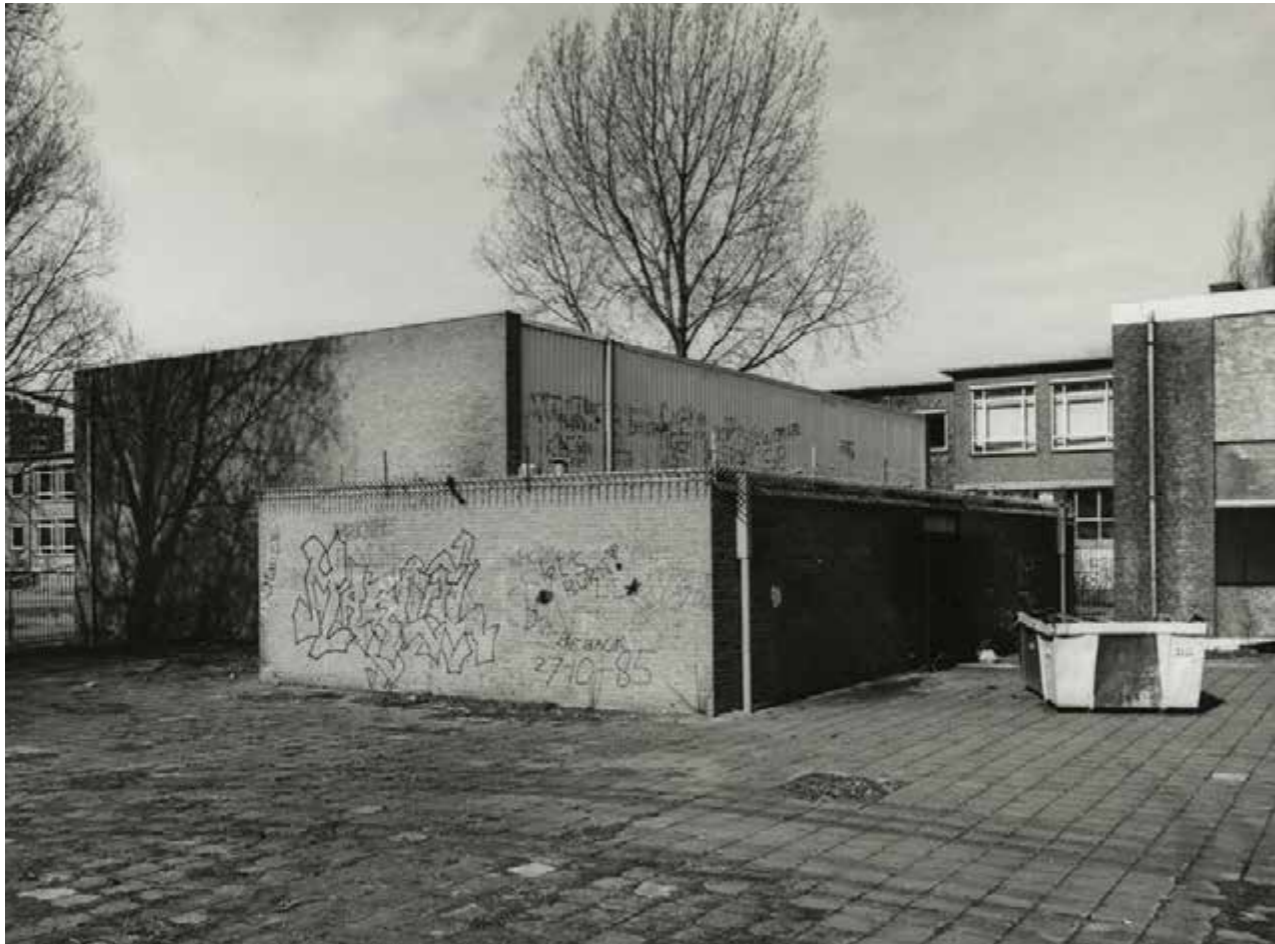
Vervallen schoolgebouw aan De Rade in Bouwlust, 1986 (Haags Gemeentearchief)
