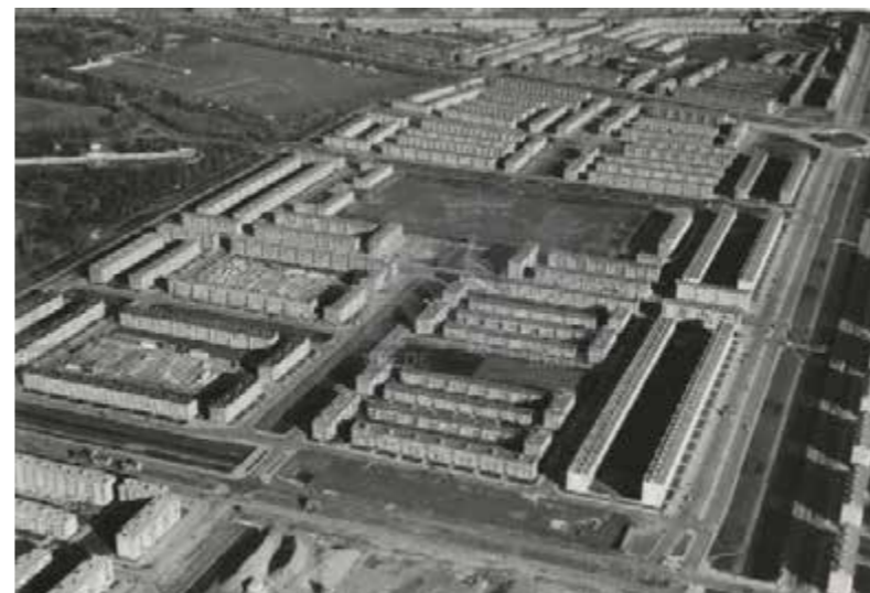
Sportterreinen ter hoogte van de Aagje Dekenlaan. In de huidige situatie zijn de randen dichtgebouwd met nieuwe woningbouw (Haags Gemeentearchief, Fotobureau Roel Dijkstra)
