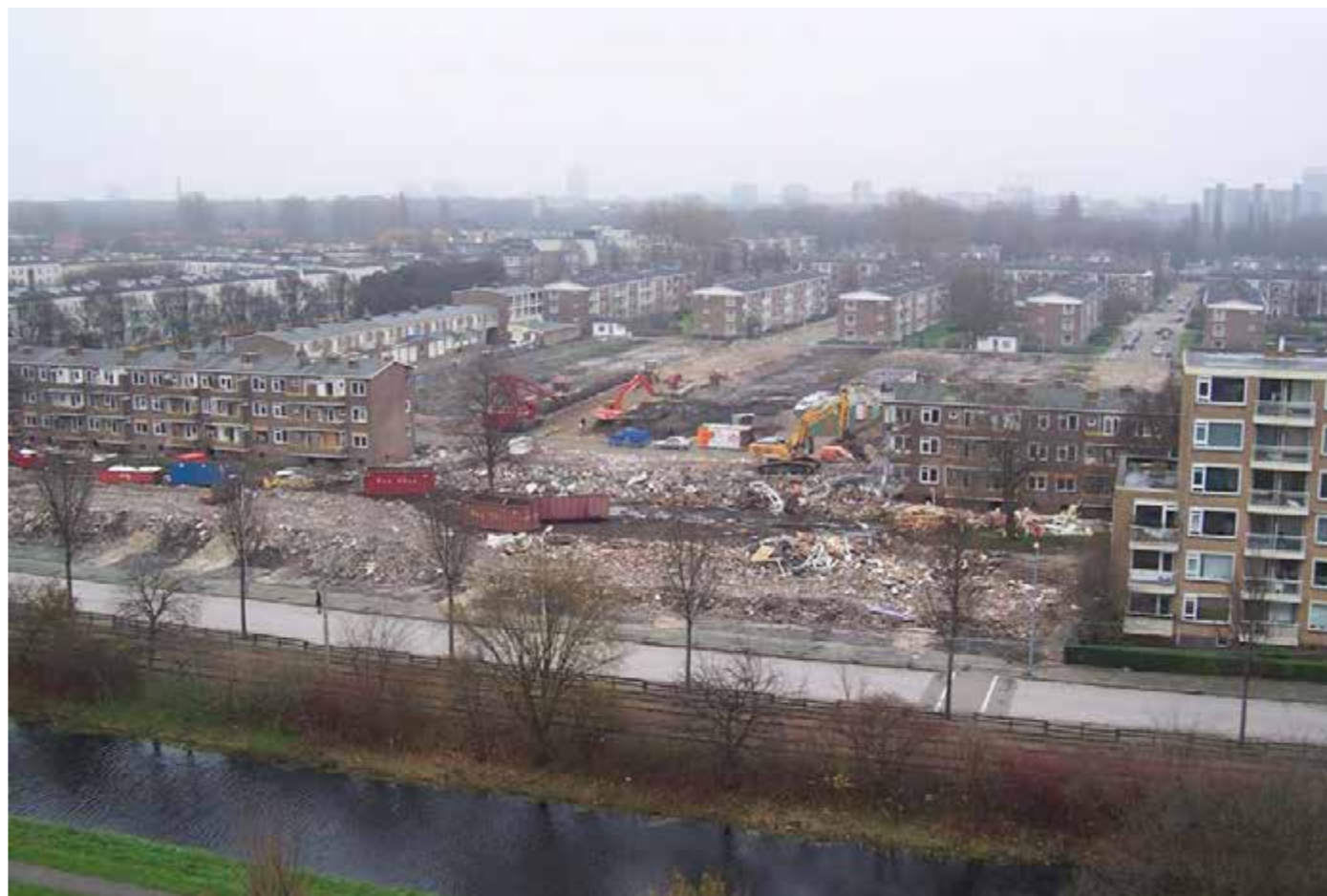
Sloop van portieketageflats aan de Erasmusweg in Moerwijk voor de bouw van nieuwe woningen, 2008 (Haags Gemeentearchief, R. Postma)
