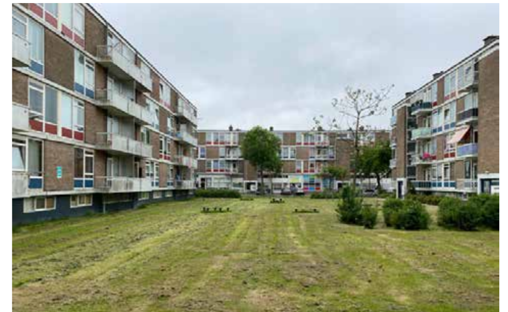
Voorbeeld van gestapelde bouw in Bouwlust, waarbij plint, puien, trappenhuis en balkons zorgen voor dynamiek in de gevel
