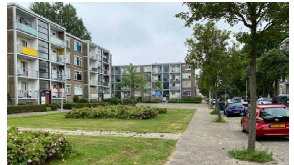
Portiekflat in Vrederust-west. Terugliggende, transparante trappenhuisen met luifels zorgen voor ritmiek en plastic in de continue gevelwand
