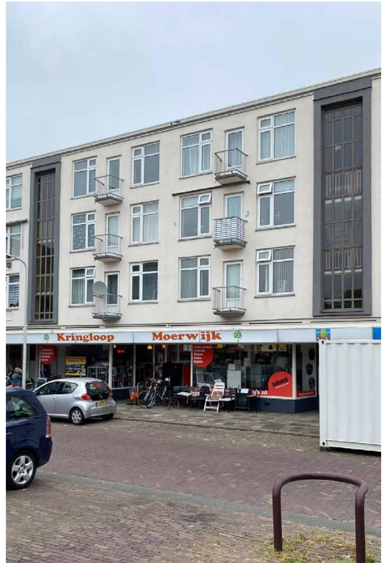
Voorbeeld van woningbouw renovatie in de jaren tachtig, Heeswijkplein
