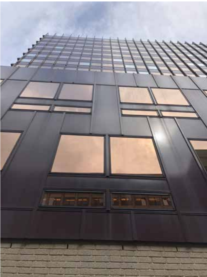
Verschillende texturen van de huid van het gebouw (achterzijde), 2020
