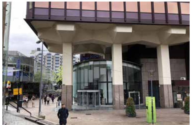
Het Binnenwegplein met de vernieuwde entree, 2020
