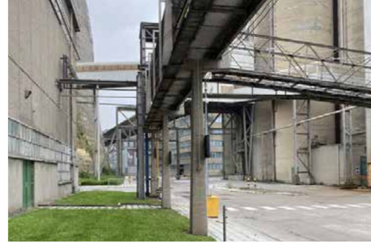
Gevorkte betonmasten voor leidingwerk
