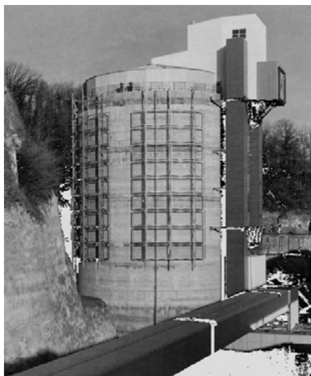
Nieuwe opslagsilo aan de noordzijde voor afgewerkte cement (70 jaar ENCI)
