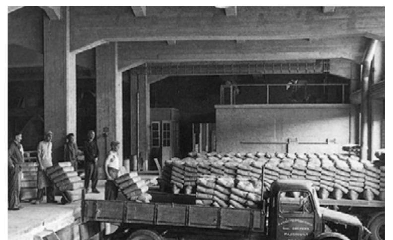
Zakken cement in het verpakingsgebouw (70 Jaar ENCI)
