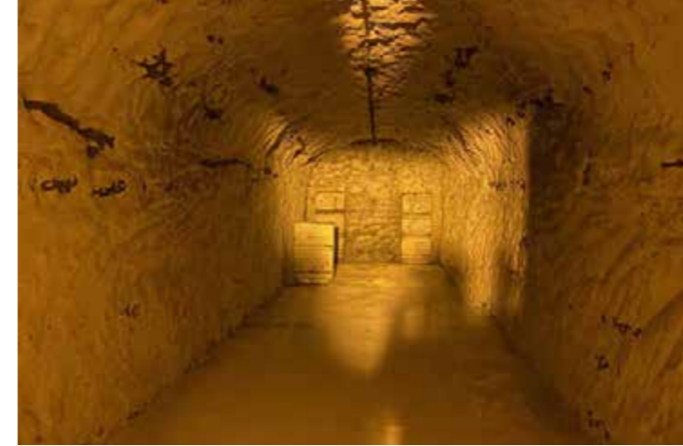
Opslagbunker voor springstoffen
