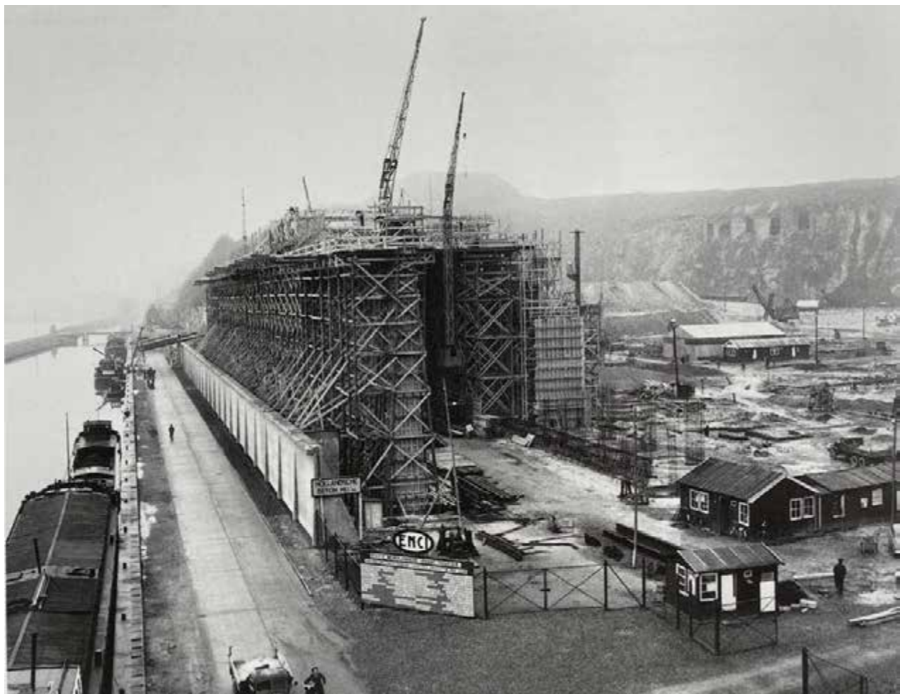
De nieuwe grondstofhallen in aanbouw als onderdeel van de zuidelijke uitbreidingen, circa 1950 (70 jaar ENCI)
