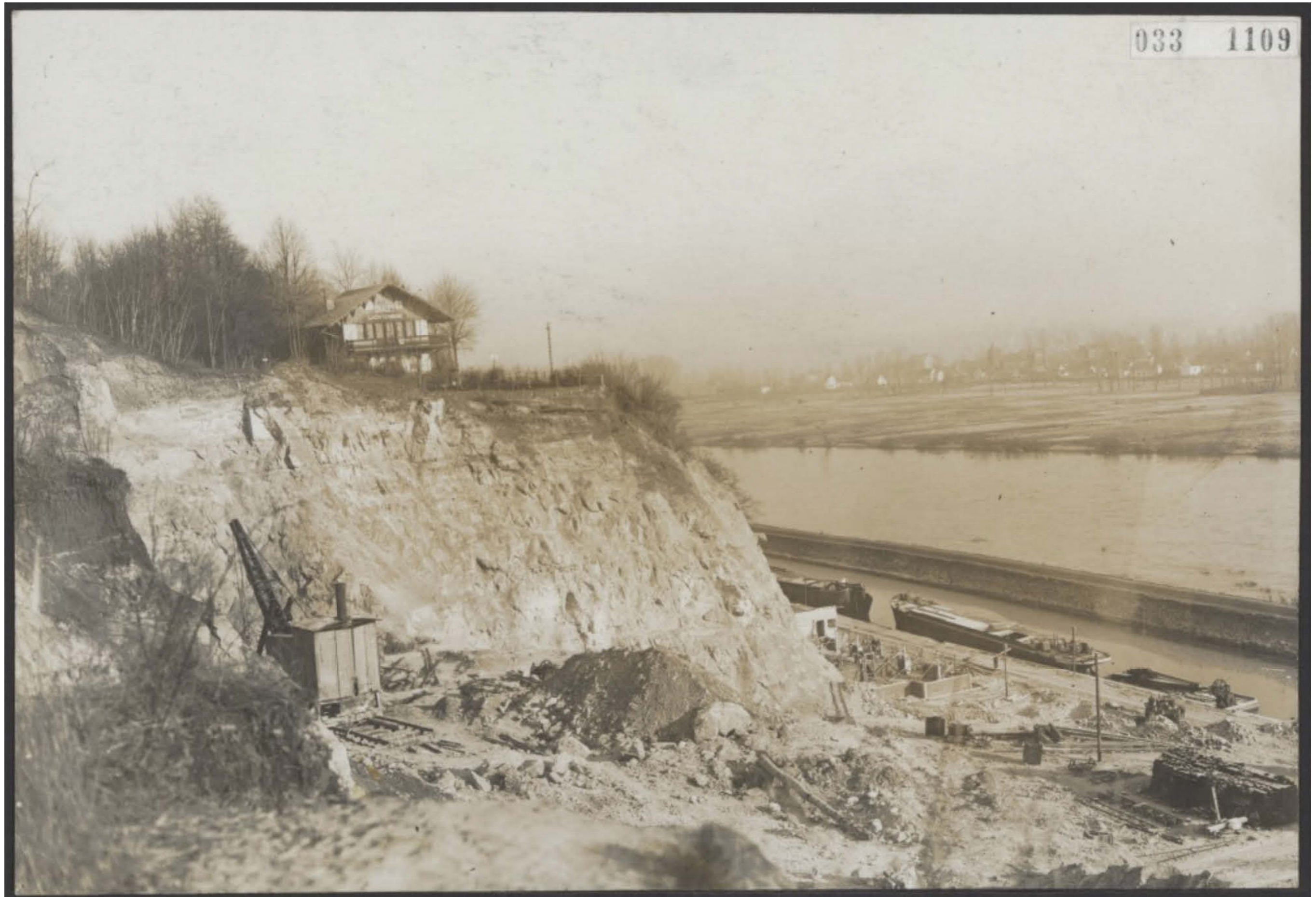
Afgraving van de Sint-Pietersberg om plaats te maken voor de bouw van de fabriek, 1925 (Nationaal Archief)
