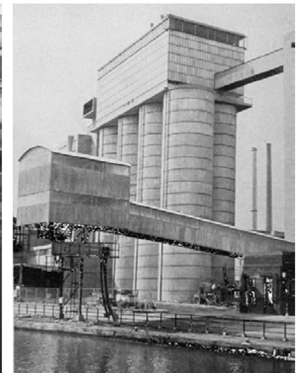
De silo's voor hoogovencement naast het latere hoofdkantoor (Cement, 1960, #11)
