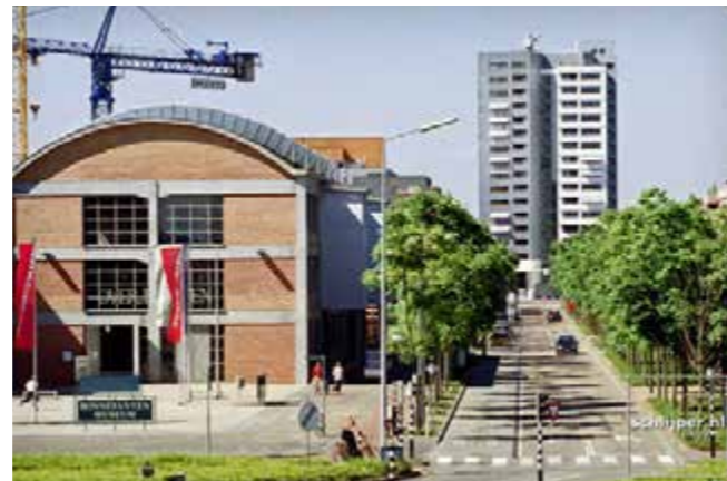
Ceramique in aanbouw met de Wiebengahal, 2001 (Thomas Schlijper)
