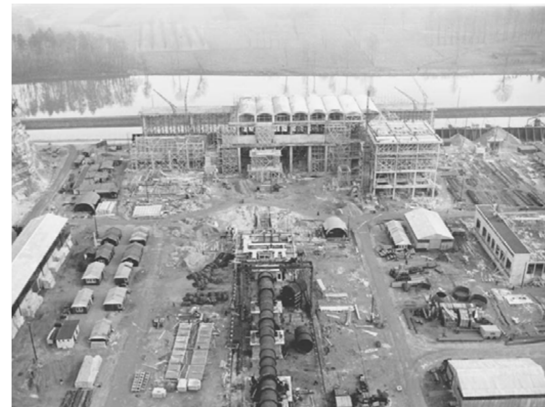
Uitbreiding zuid in aanbouw (Archief ENCI)
