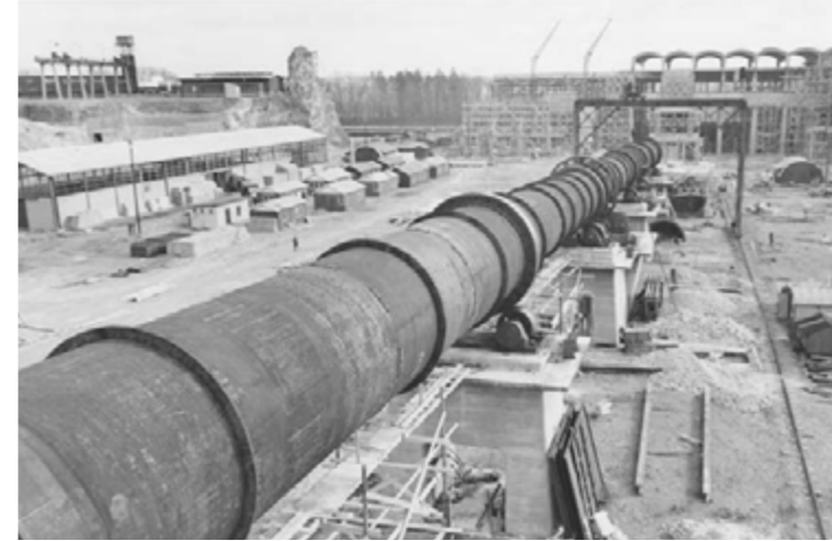
Bouw van de fabriekshal voor oven 5. Goed zichtbaar is hier dat eerst de ovenbuis is opgebouwd en dat vervolgens het gebouw er overheen wordt gezet (arcchief ENCI)
