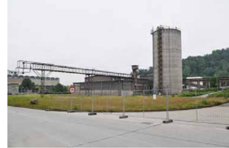
Brandstof- en vliegassilo
