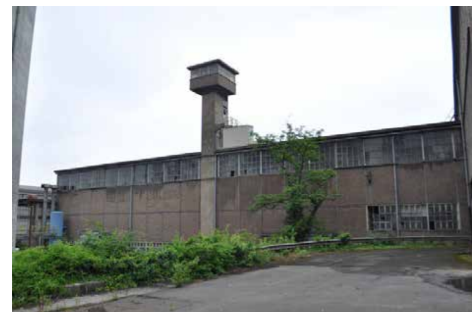
Het middelste deel van het papvoorbereidingsgebouw
