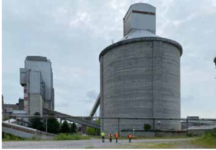
Klinker- en gipssilo
