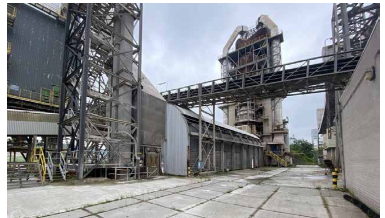
De cyclonentoren en de mergeldroger
