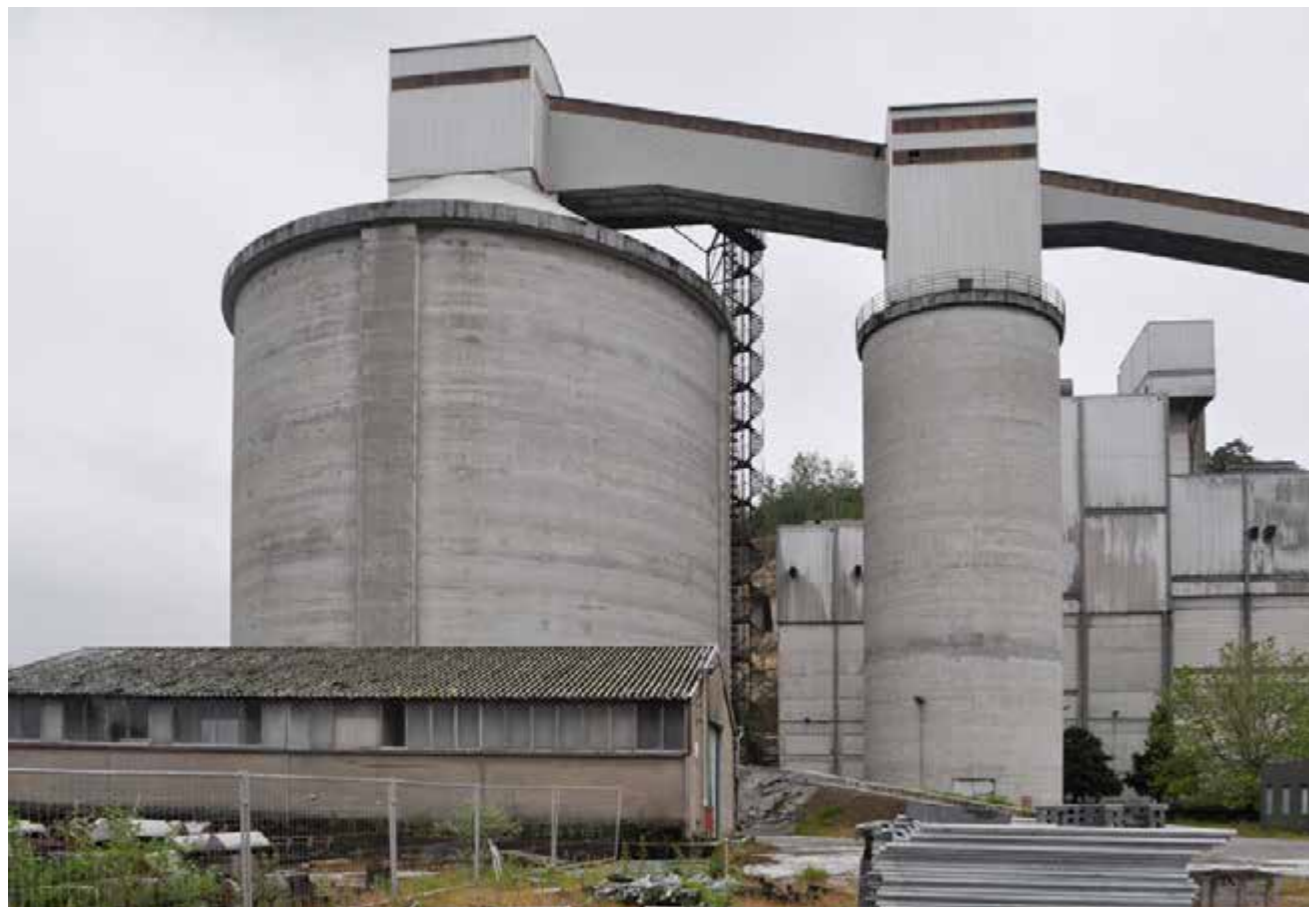
Klinker- en gipssilo
