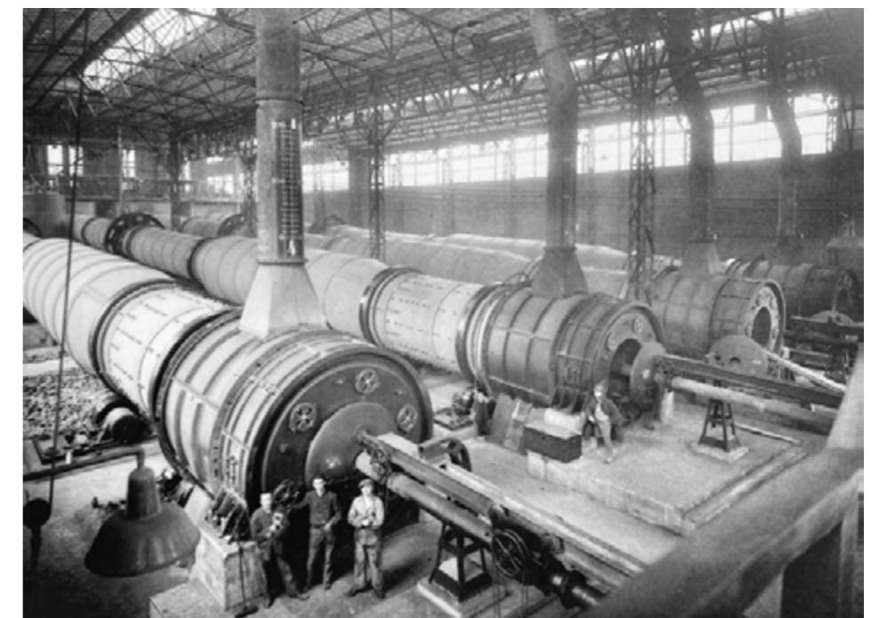
De vier roterende buisovens van de vooroorlogse fabriek (70 jaar ENCI)
