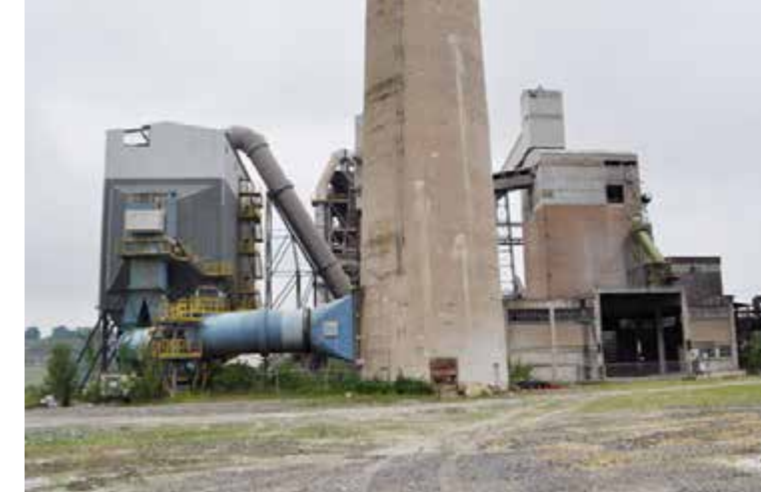
Het gebouw links van de schoorsteen is het E-filter
