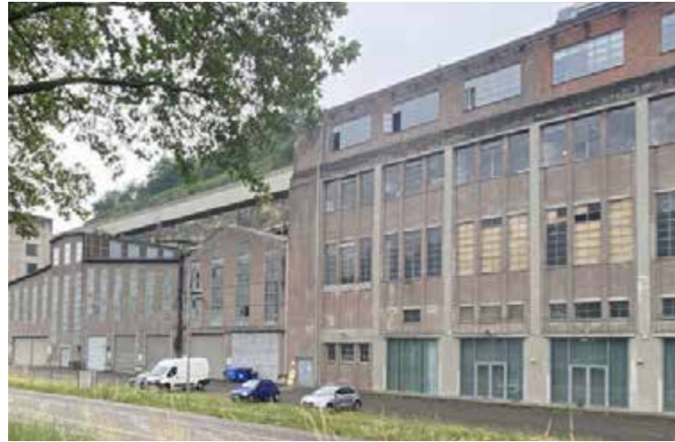
Rechts in beeld het verpakkingsgebouw, daar links naast het voormalige cementmolengebouw
