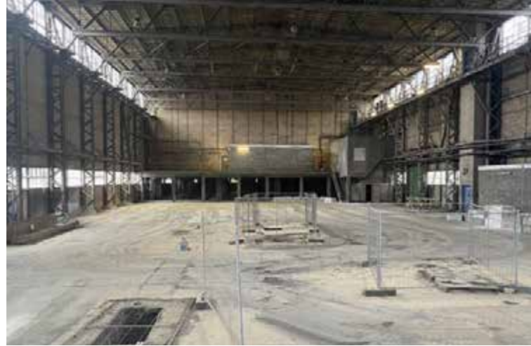
De grote fabriekshal waar vroeger de papmolens stonden opgesteld. Let op de imposante staalconstructie waarbij zowel voor de dakliggers als de kolommen samengestelde vakwerkconstructies zijn toegepast
