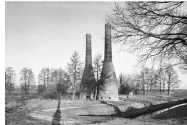
Voormalige schepkalkovencomplex, Dieverbrug (rce.nl, IJ. Th. Heins)
