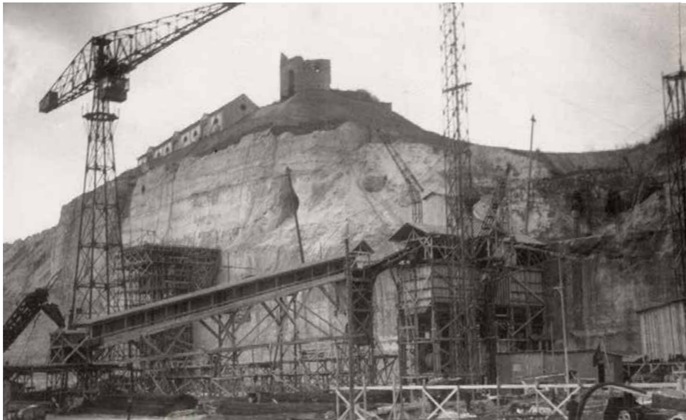
Bouw van de fabriek, 1927 (Het Geheugen)
