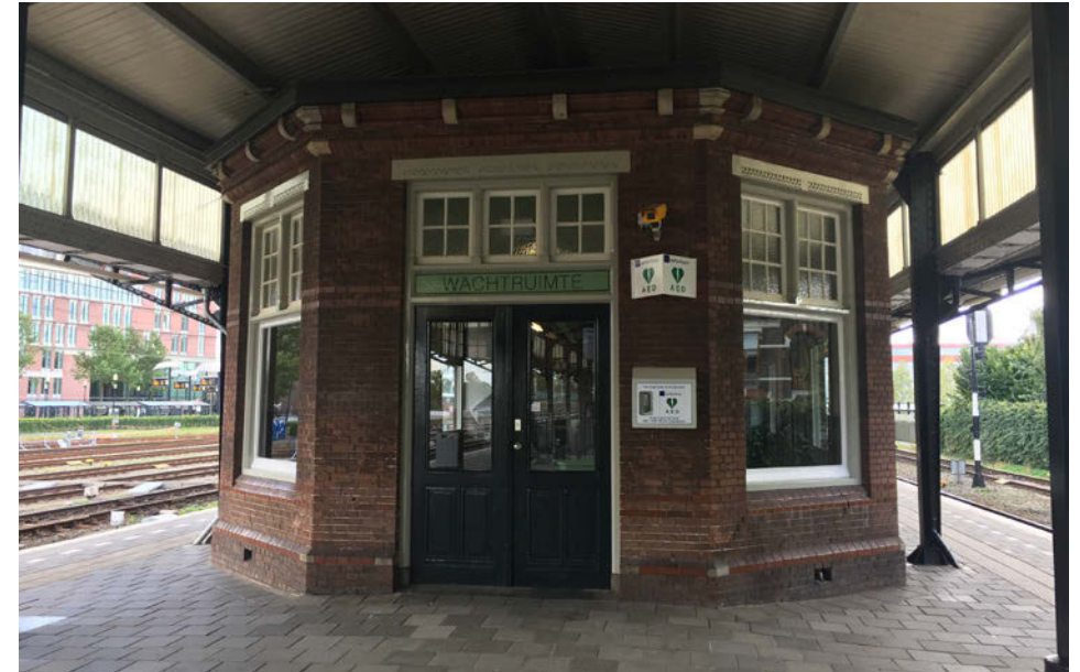
Kop perrongebouw, achterzijde
