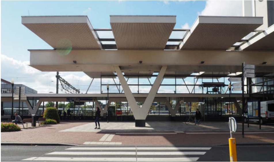
Overgedimensioneerde gebouwonderdelen ter plaatse van de hoofdingang
