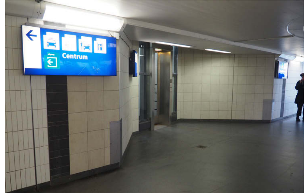
Lift in de perrontunnel naar het middenperron
