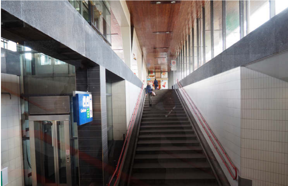
Trappen naar de perrontunnel, daarachter de voormalige restauratie / wachtkamer voor busreizigers
