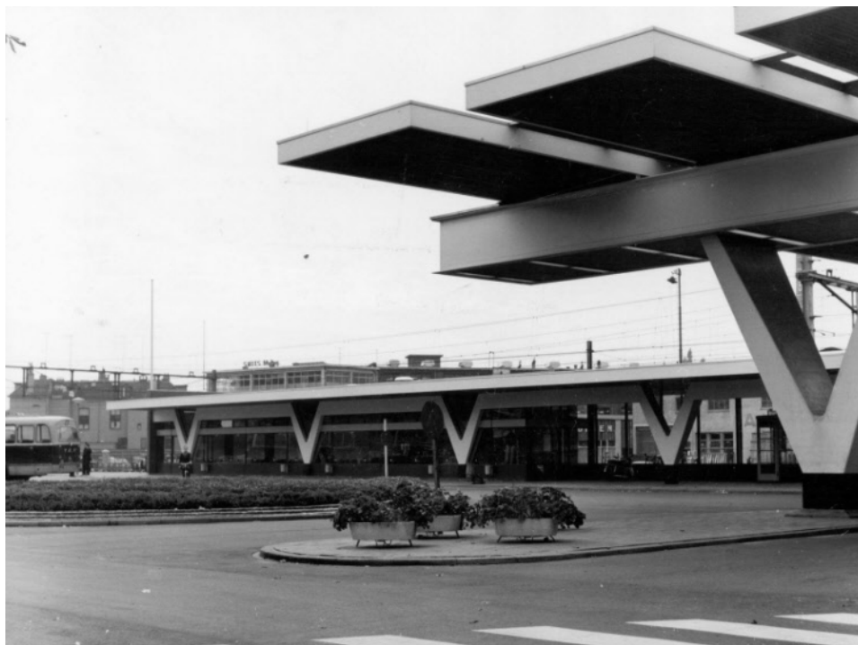
Verlichting in de doorlopende onderslagbalk
