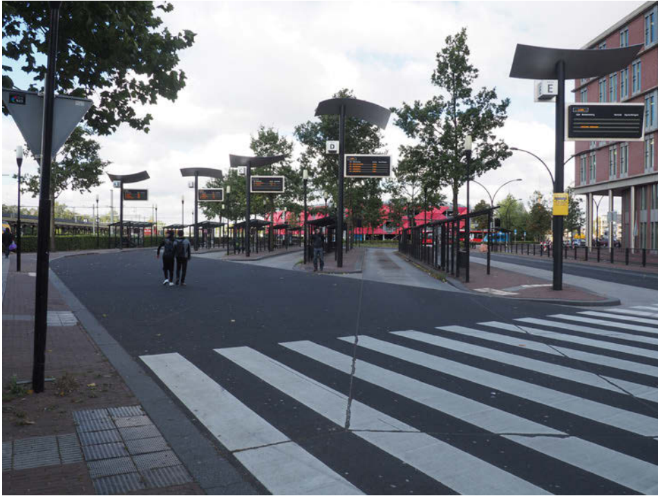
Nieuwe busstation uit 2003 ter plaatse van de vroegere goederenloodsen
