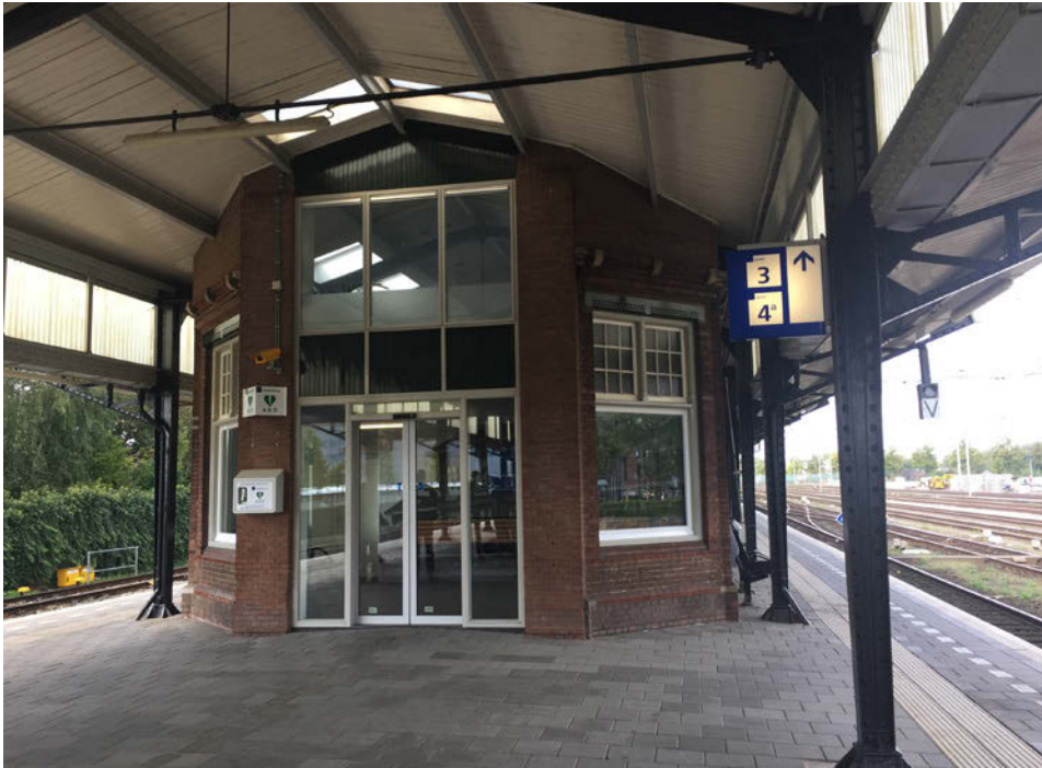
Kop perrongebouw, voorzijde
