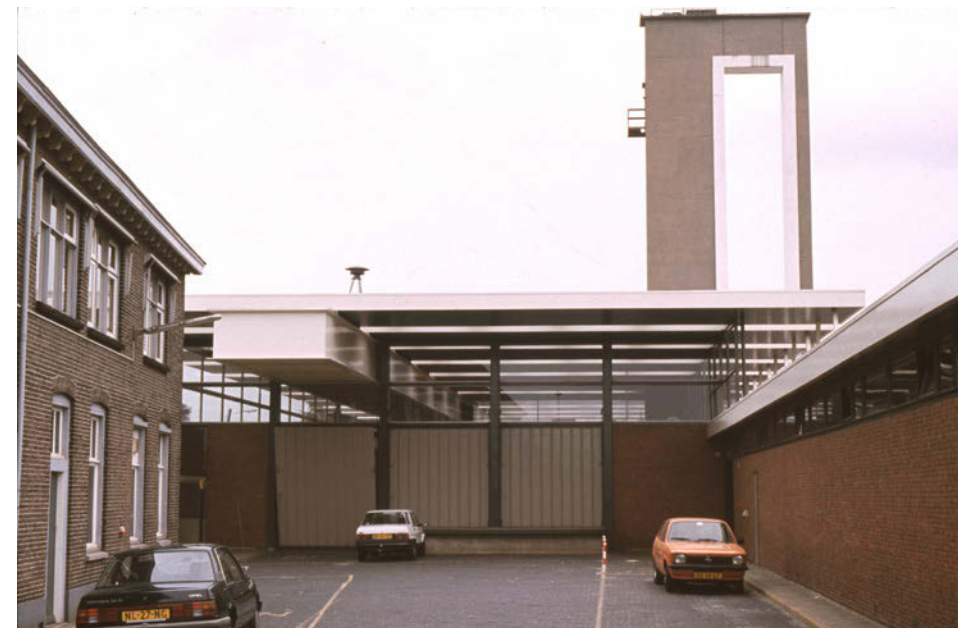
Oorspronkelijk gevelindeling aan de achterzijde (noordzijde) van het station
