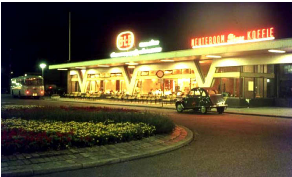
Situatie in de zeventiger jaren rond het eindpaviljoen in de zuidvleugel, met de restauratie voor busreizigers, momenteel in gebruik door Döner Company. Ongedateerde foto. (bron: www.toenwasalmelonogmooi.nl/ / Korneel D. Aschman)
