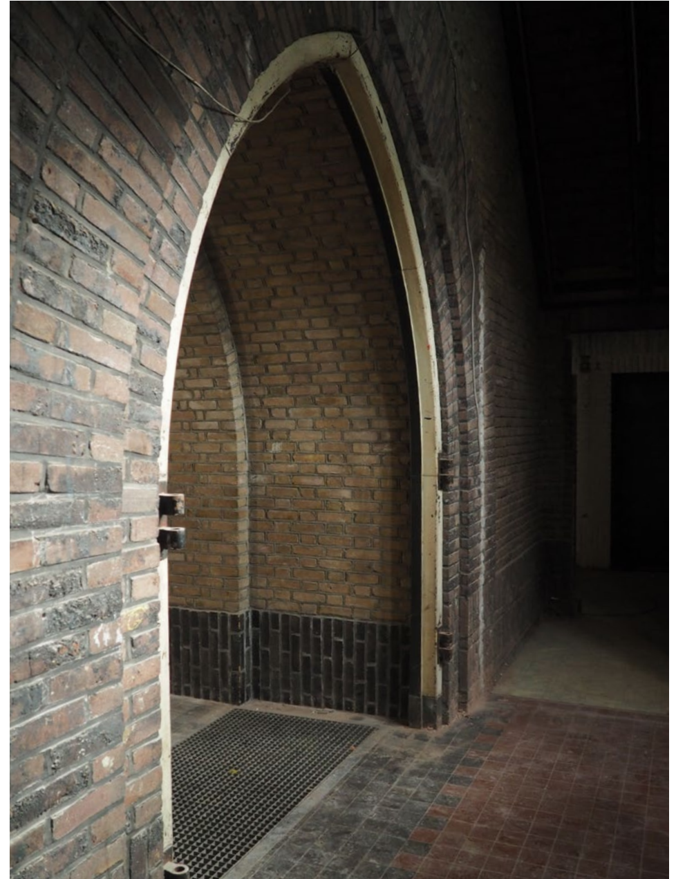
Oorspronkelijke plaats van de portaaldeuren
