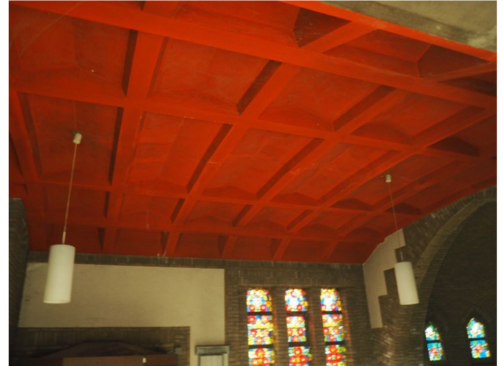
Betonnen cassetteplafond in de devotiekapel
