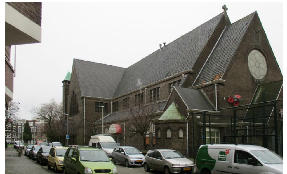
De situatie aan de noordzijde van de kerk in de Nootdorpstraat is verder min of meer oorspronkelijk
