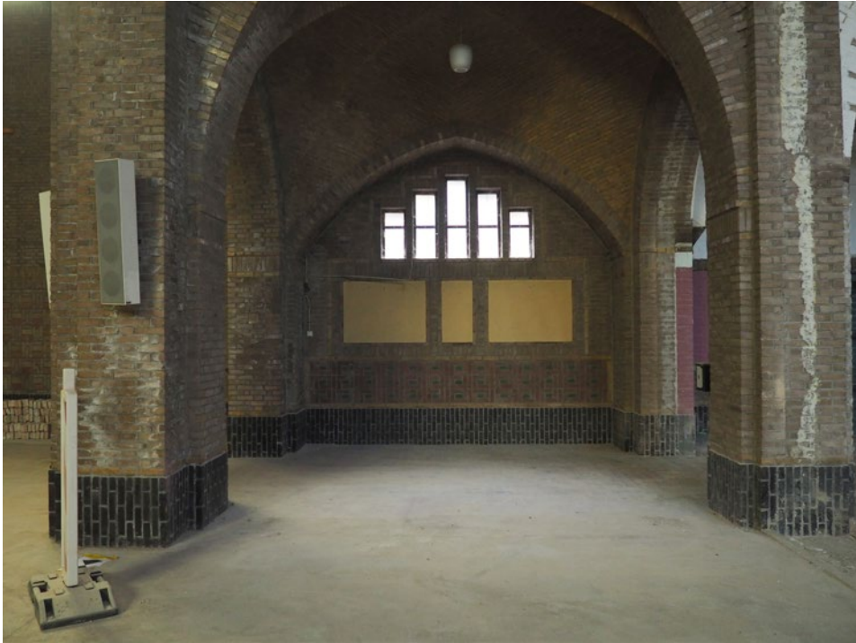
Raamopeningen in de zijbeuken
