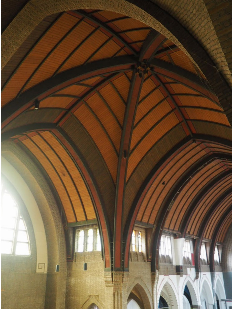
Spantconstructie boven de viering met op de kruising een lichtarmatuur
