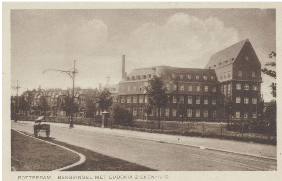
Uitbreiding van het Eudokiaziekenhuis uit 1930 aan de Bergsingel
