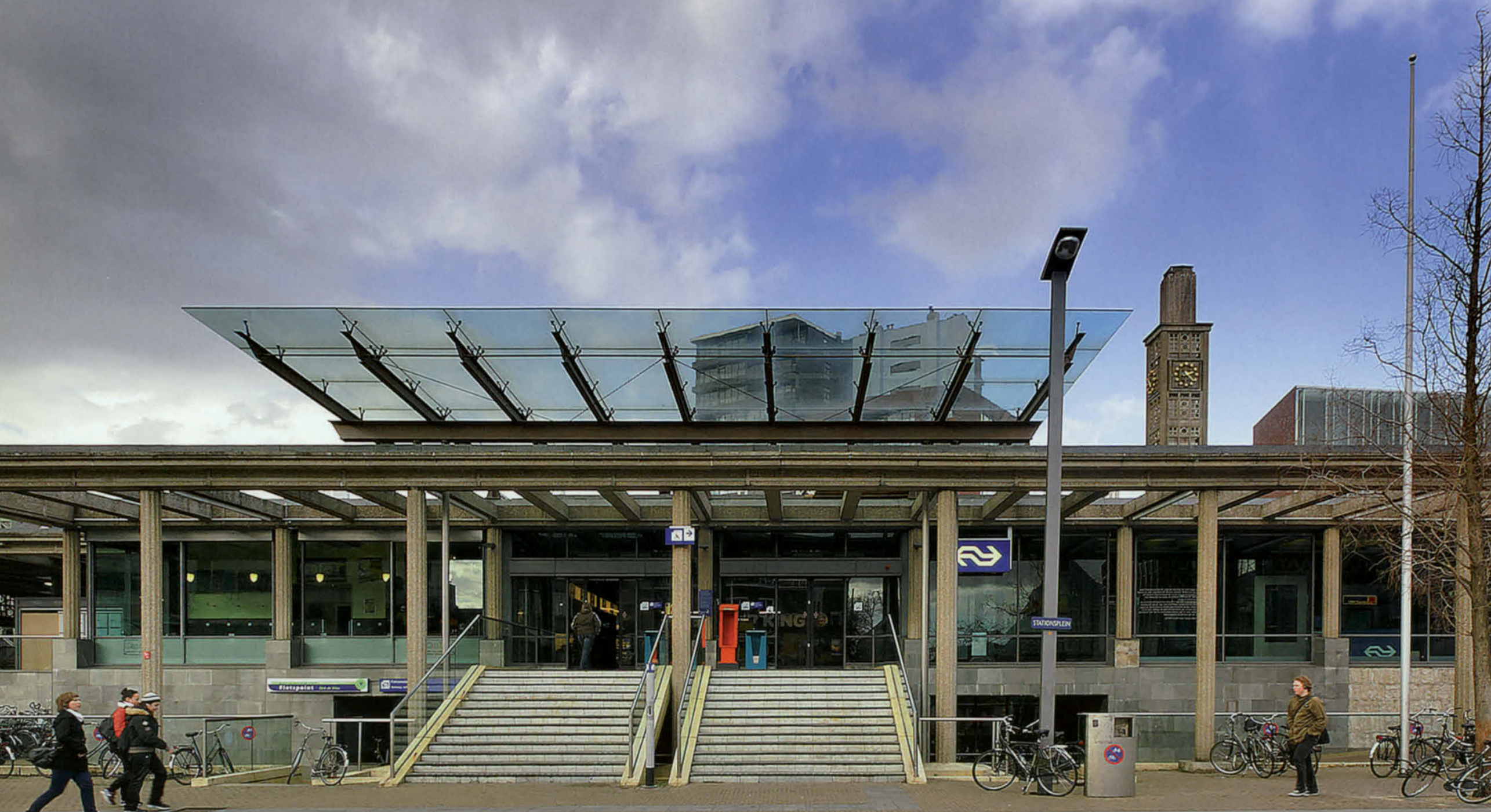
Nieuwe entree in Zuidgevel
