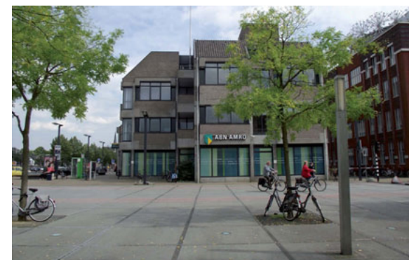
ABN-AMRO gebouw uit de jaren '80 (2011)
