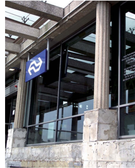
In plaats van op een borstwering te staan, hebben de kolommen nu sokkels gekregen
