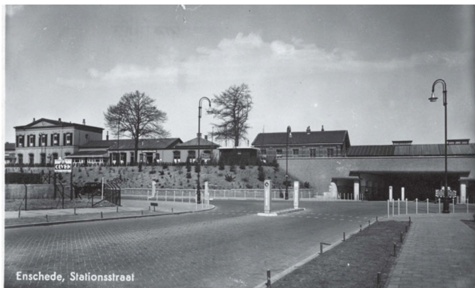
Het station (1865) gezien vanaf de De Ruitersweg met rechts de Prinsesstunnel
