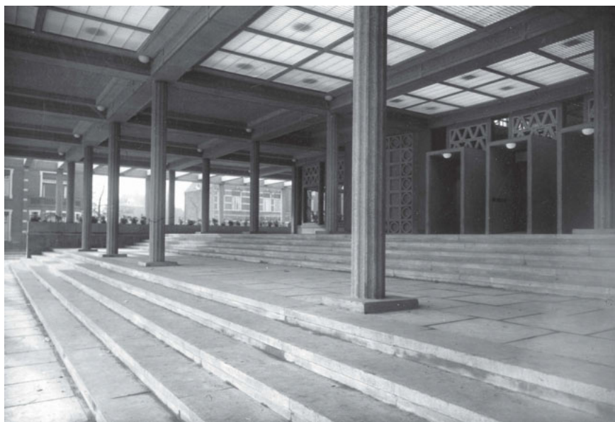
Peristyle met trappen naar de ingang
