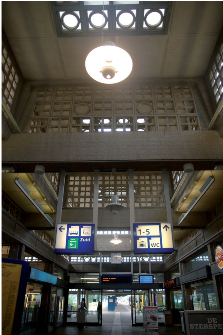
De Centrale Hal gezien richting het westen en de perrontree
