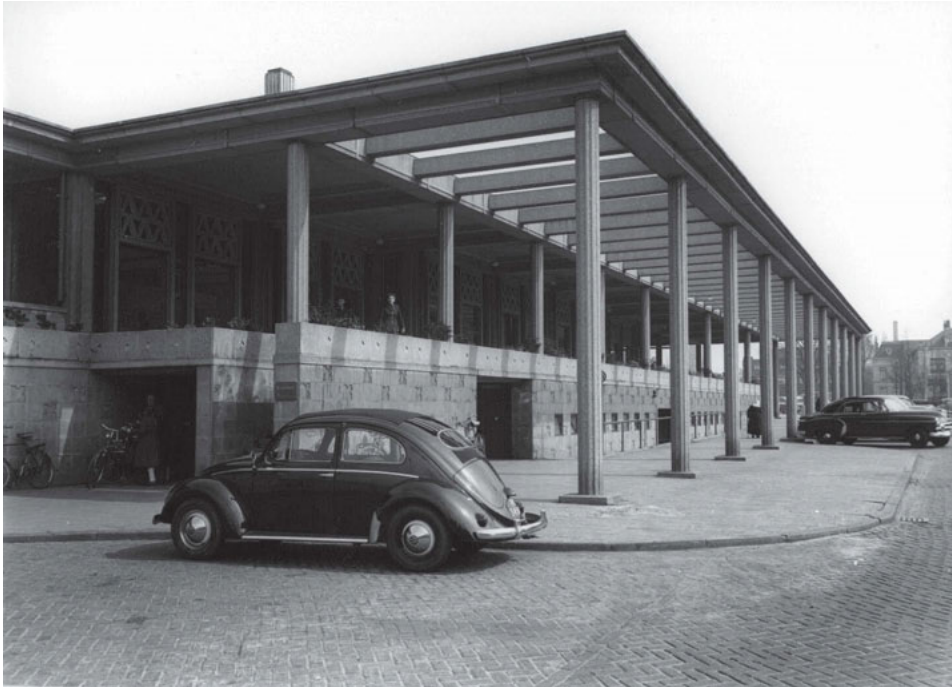
Terras onder pergola met helemaal links in het basement de trap naar het terras, middenin de opening naar de trap naar de hal en rechts nog te zien de opening naar de fietsenkelder
