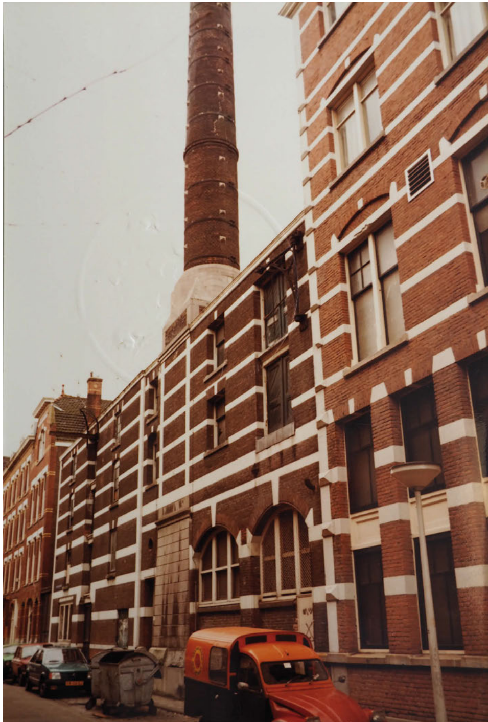
Ketelhuis en schoorsteen aan de zijde van de Burgemeester Hoffmanstraat, 1983 (bron: Stadsarchief Rotterdam)
