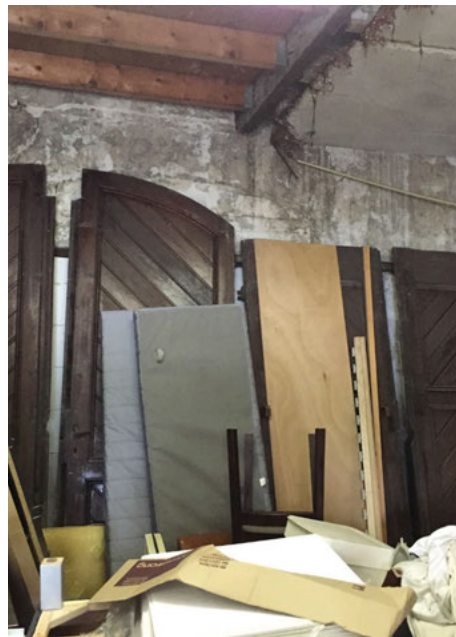
Opslagruimte begane grond (voorheen garage), 2016
