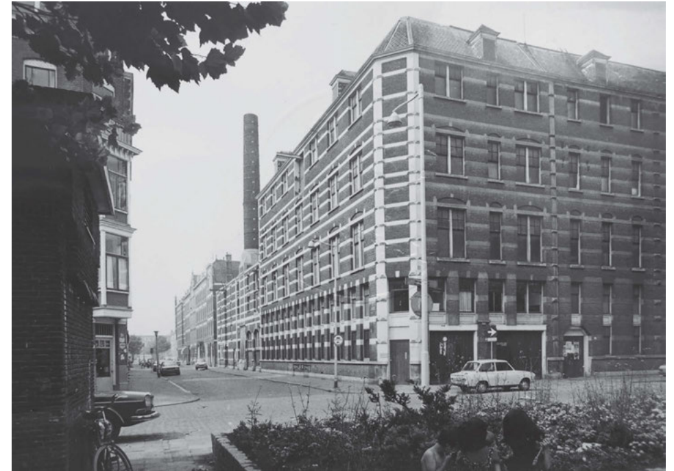
Ketelhuis en schoorsteen aan de zijde van de Burgemeester Hoffmanstraat, 1978 (bron: Stadsarchief Rotterdam)
