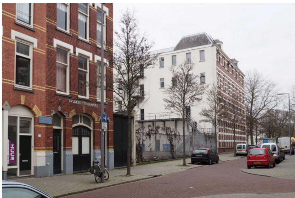
Achterzijde van de fabriek van Laming & Sons aan de Burgemeester Hoffmanstraat, 1978 (bron: Stadsarchief Rotterdam) en 2016
