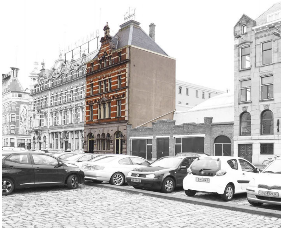
Bouwdeel eerste fase 1888 met wachtgevel
