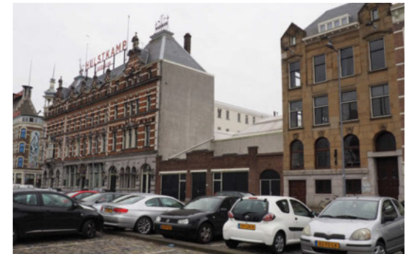
Extensie van het Hulstkampgebouw ter hoogte van de Maaskade 125-126
