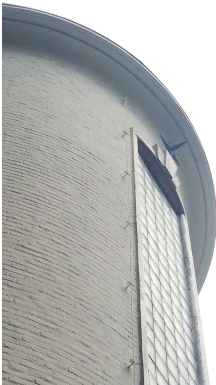
Verticaal raam in de westgevel
