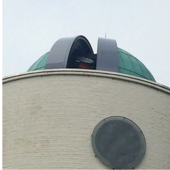
Koepeldak van buiten gezien
