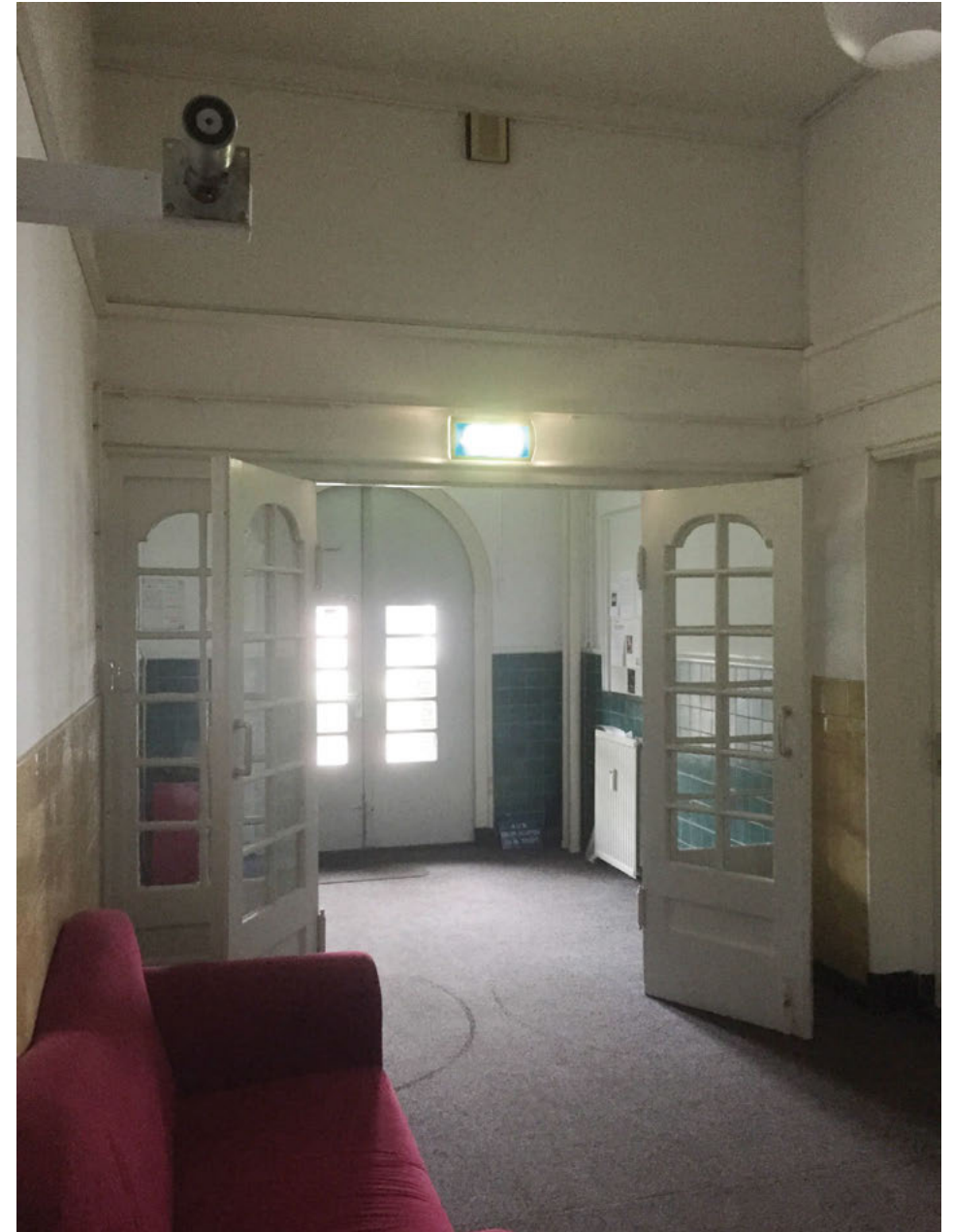
Entreehal met groen tegelwerk en oorspronkelijke tochtdeuren
