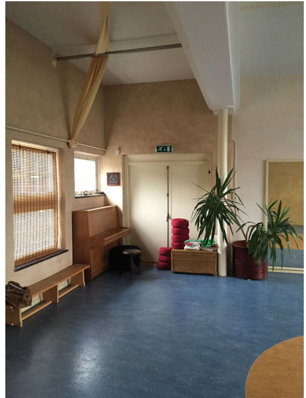
Doorbraak tussen lokaal 2 en gang
